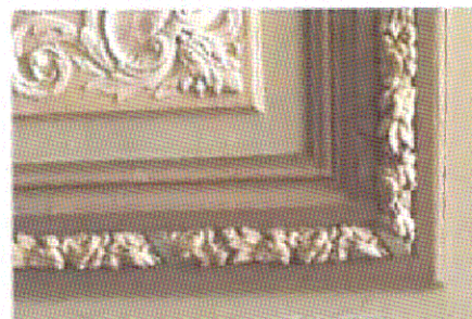
Лепной декор рамки филенки стены (пом. 2.4, фрагмент)
