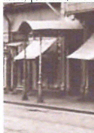
Фрагмент Ю-3 фасада, металлический навес, 1930-е гг.
