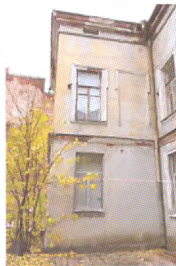
Дворовой Ю-З фасад дворового крыла
