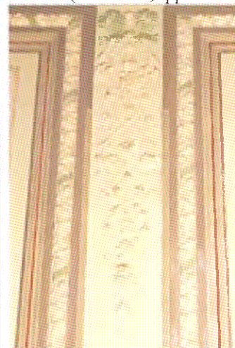
Лепной декор простенка между филенками (пом. 2.4, фрагмент)
