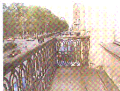
Балкон (Ю-З лицевой фасад)
