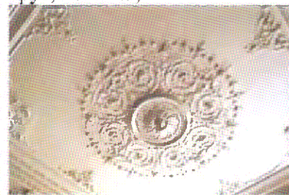
Лепной плафон (пом. 2.4)
