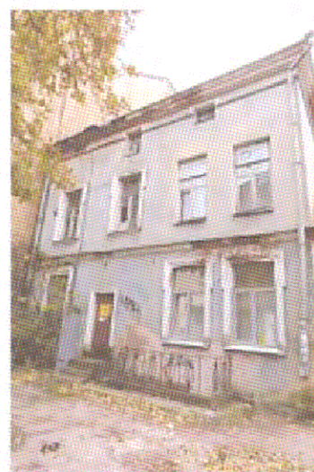
Дворовой С-В фасад дворового крыла
