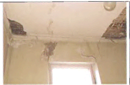
Плоское перекрытие (пом. 2.3)
