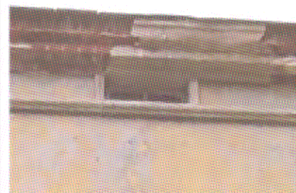
Оконный проем (фриз, дворовые фасады)
