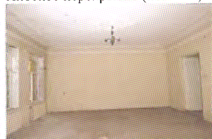
Плоское перекрытие (пом. 1.8)
