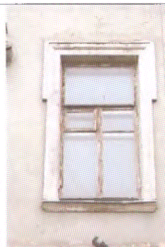
Оконный проем, его оформление (дворовые фасады)
