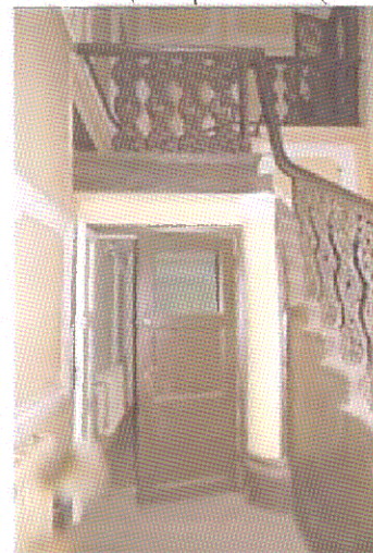
Опорная полуколонна (пом. 1.1, 1-ый ярус)
