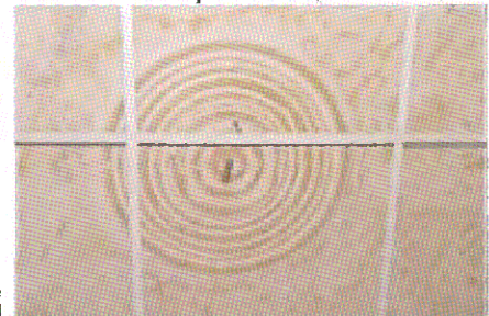
Потолочная розетка (пом. 1.12)
