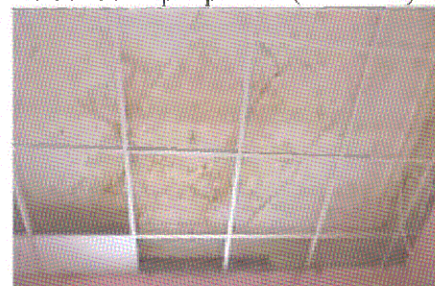
Плоское перекрытие (пом. 1.13)
