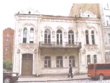
Ю-З лицевой фасад (фото 2018 г.)
