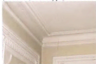
Потолочная галтель (пом. 1.2)
