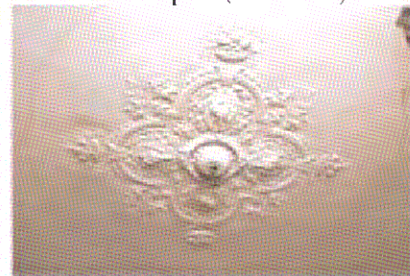
Лепной плафон (пом. 2.6)
