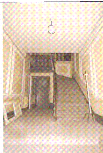
Плоское перекрытие (пом. 1.1)
