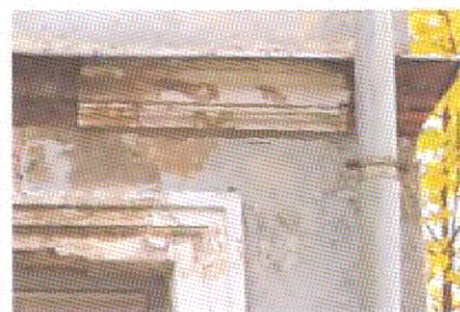
Межэтажный карниз (дворовые фасады)
