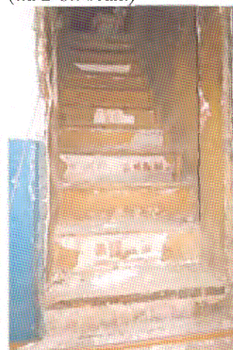
Лестница кирпичная (на чердак)
