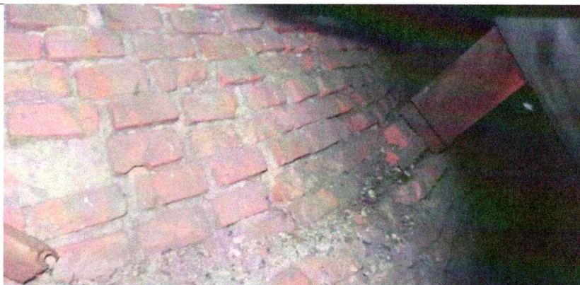
Материал свода - полнотелый керамический кирпич, уложенный на известковый раствор
