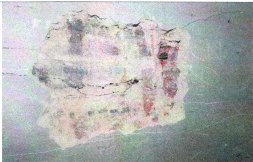
Материал штукатурного покрытия стен верхнего яруса интерьера – известковая штукатурка с окраской
