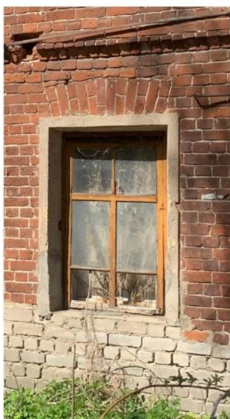
Вид оконного проема с лучковой перемычкой в кирпичной кладке без наличника.
