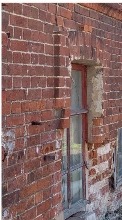
Вид оформления оконных проёмов полуналичниками из кирпича с замковыми камнями и пологими лучковыми перемычками.
