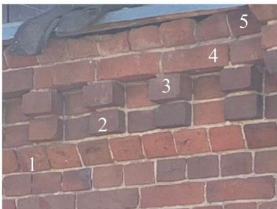
Вид пятирядного венчающего карниза.
