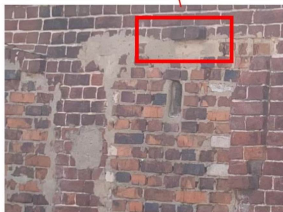
Вид оформления дверных проёмов прямыми полуналичниками из кирпича с замковыми камнями.
