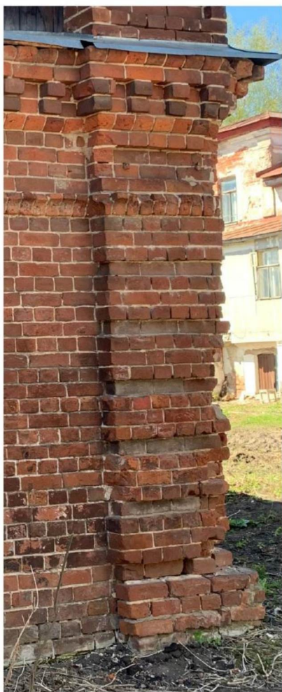
Вид рустованной лопатки с выносным венчающим карнизом.
