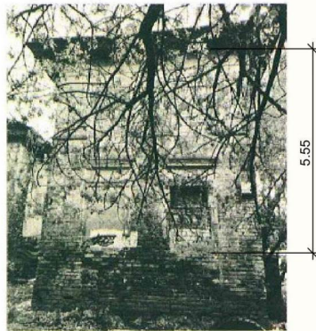
Северо-западный фасад (правая часть).
