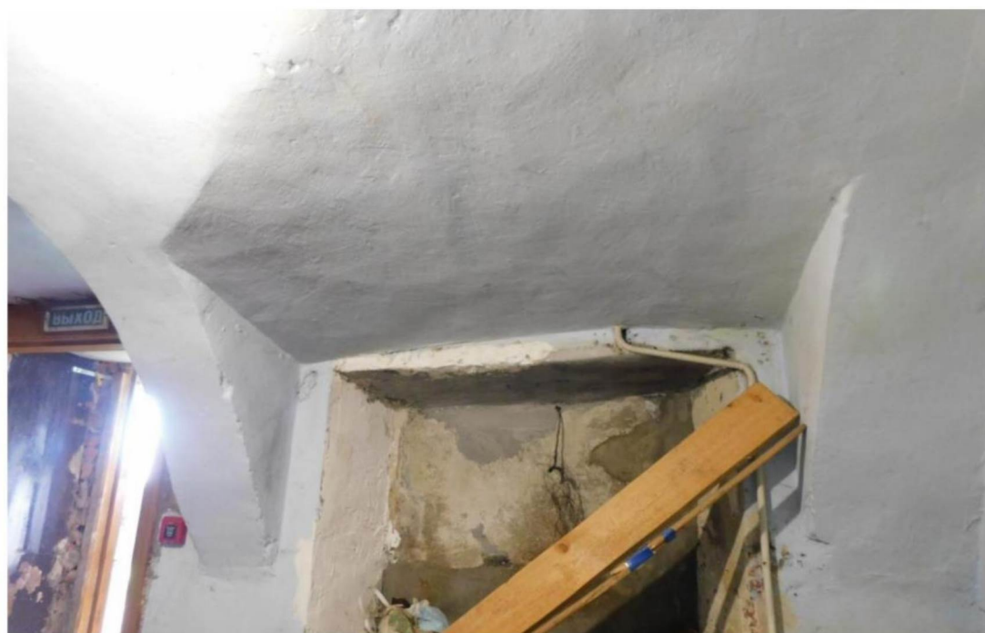
Коробовый свод с распалубками над проемами
