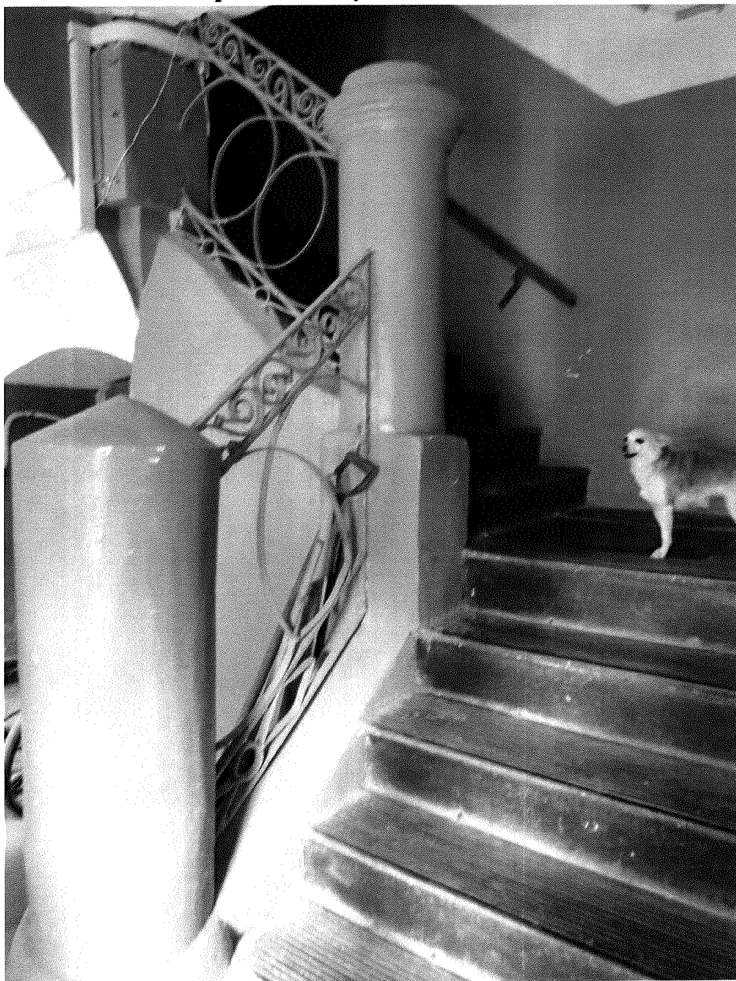
Г-образная лестница с ограждениями в виде кирпичных тумб и коваными металлическими заполнениями между ними
