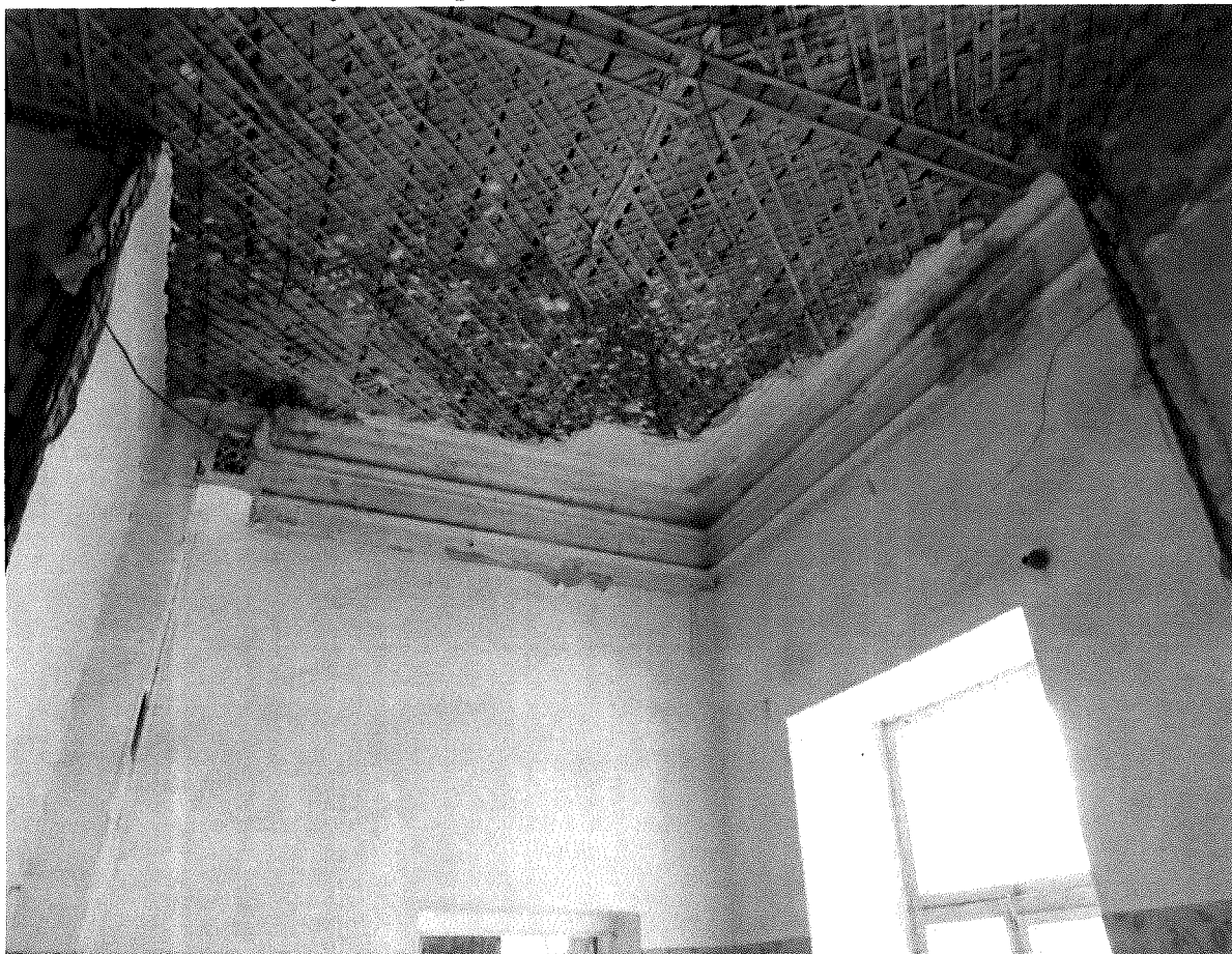
Фрагмент тянутого профилированного карниза в помещении второго этажа
