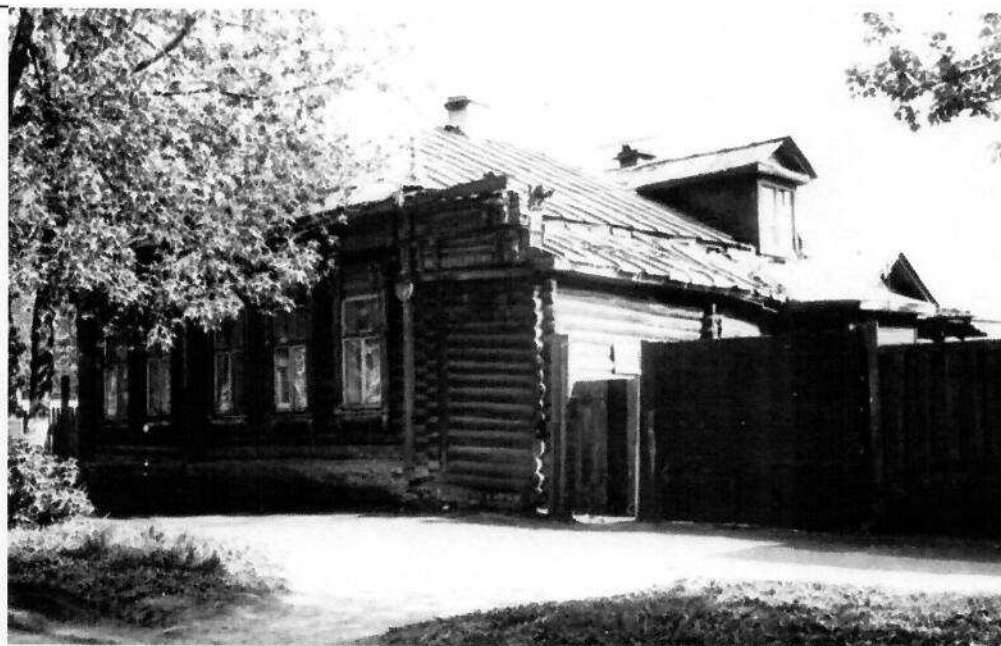
Рис. 6. Общий вид на здание с северо-запада. Фото 2-й пол. XX в. (до утраты северного объема сени).
