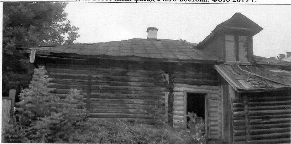
Рис.24. Вид на западный фасад (южная часть с дверным проемом скрыты объемами сеней). Фото 2020 г.
