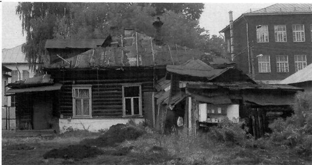
Рис.11. Общий вид на объект с юга. Фото 2020 г.
