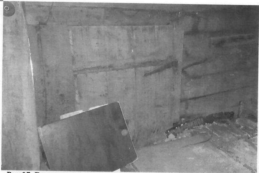
Рис.37. Вид изнутри на западную стену хоз.пристройки с вторично использованным дощатым полотном (при занижении проема). Фото 2020 г.
