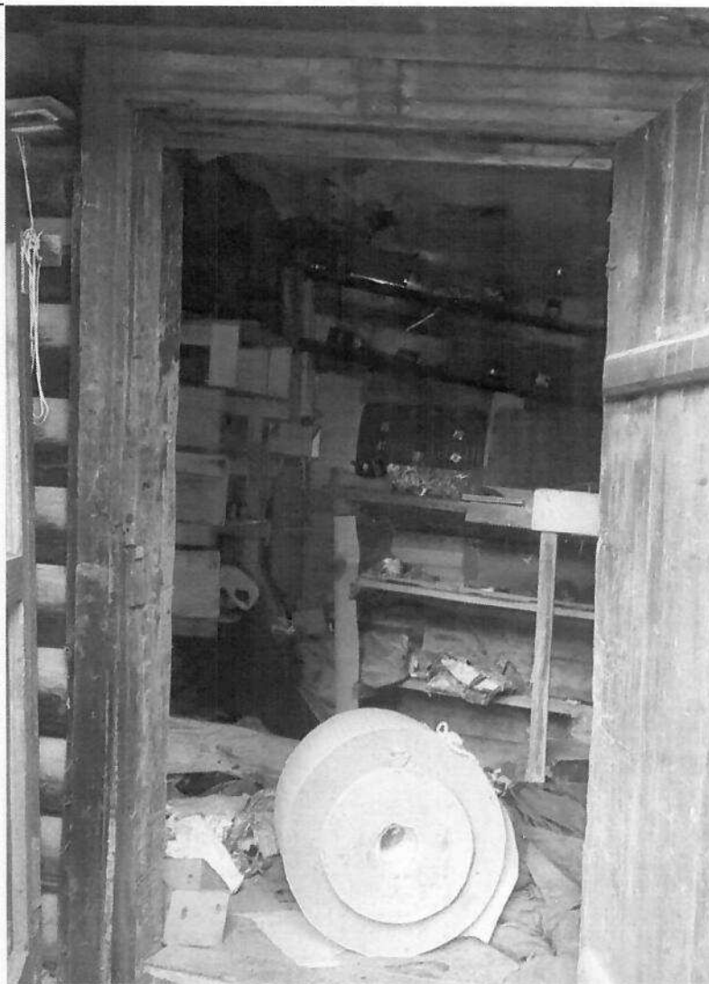
Рис.17. Колода дверного проема северного объема хозяйственной пристройки. Фото 2020 г.
