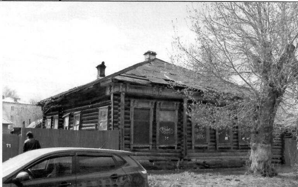
Рис. 5. Общий вид на здание с северо-востока. Фото 2019 г.
