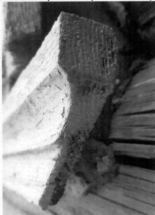
Рис.33. Фрагмент подоконной доски наличника проема восточного фасада. Фото 2020 г.
