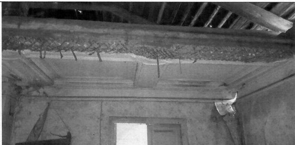
Рис. 43. Фрагмент сохранившегося кессонированного потолка, оформленного тягами с розетками по месту пересечения карнизов. Фото 2020 г.
