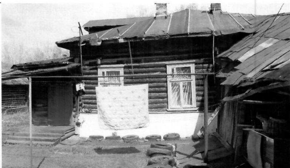
Рис.25. Вид на южный фасад (оконный и дверной проемы восточной части скрыты хозяйственной пристройкой). Фото 2019 г.
