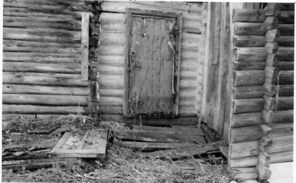
Рис.14. Фрагмент западного фасада: стены основного объема с перерубом по 3-й оси; на переднем плане переруб сеней в пол бревна. Фото 2020 г.
