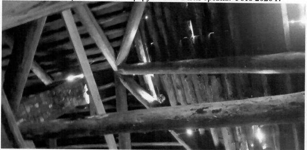
Рис.15. Вид на кровельные конструкции северной вальмы (снизу). Фото 2020 г.
