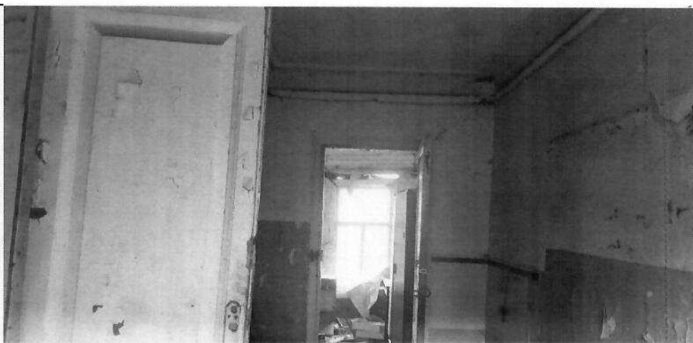
Рис.12. Общий вид коридора, слева – дверь в северо-западную залу, справа – заложенная дверь в юго-западное помещение, имеющие проходы вдоль северного и южного фасадов; прямо – вход в восточное помещение. Фото 2020г.
