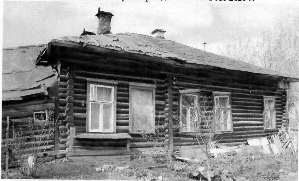
Рис.23. Вид на восточный фасад с юго-востока. Фото 2019 г.
