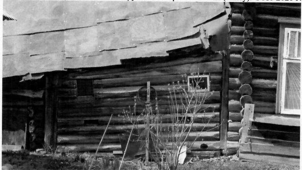
Рис.16. Фрагмент восточного фасада хоз.построек, прирубленных к основному объему через стойку. Фото 2019 г.
