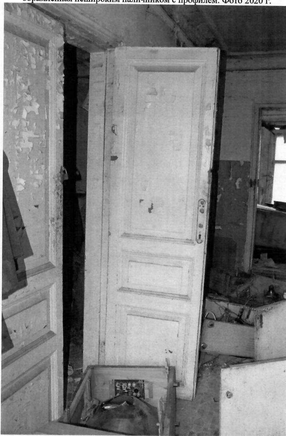
Рис.46. Двупольная филенчатая дверь в коридоре северного объема, идентичная по строению с дверью южного объема. Фото 2020 г.
