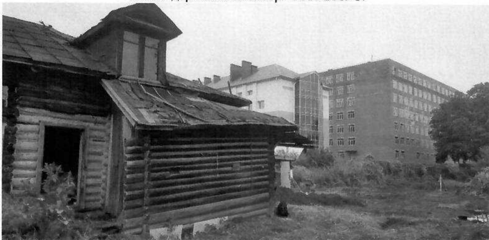
Рис. 4. Вид от северо-запада владения в сторону двора. Фото 2020 г.
