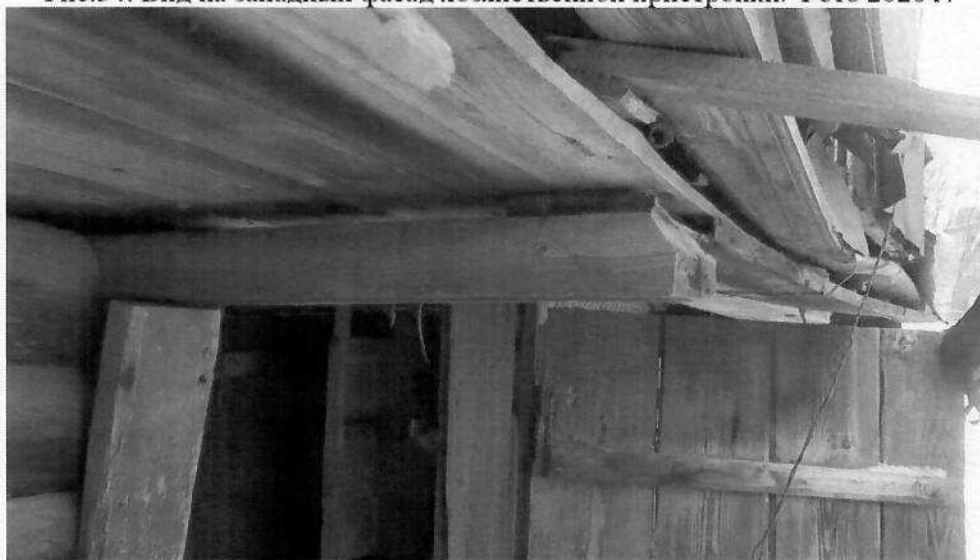
Рис.35. Общий вид восточного фасада с выносом кровли в виде навеса над дверным проемом. Фото 2020 г.
