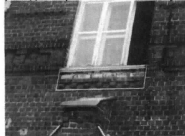
Пояс с сухариками по типу бриллиантового руста (северо восточный фасад северо-восточного выступа)
