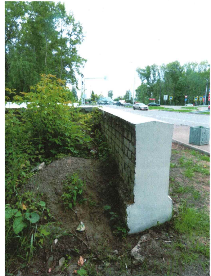
Фото 15. Северная стенка. Профиль северной и южной стенки. Фото 2023 г.
