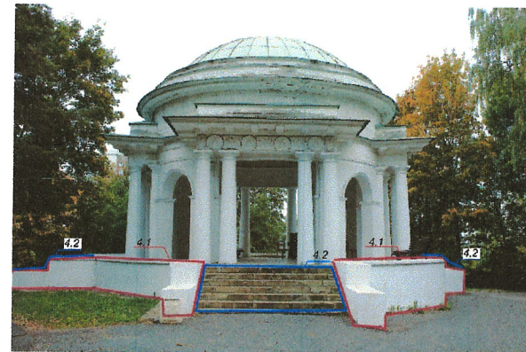
Фото 3. Вид на объект культурного наследия с южной стороны. Фотосъемка октябрь 2022 г.
