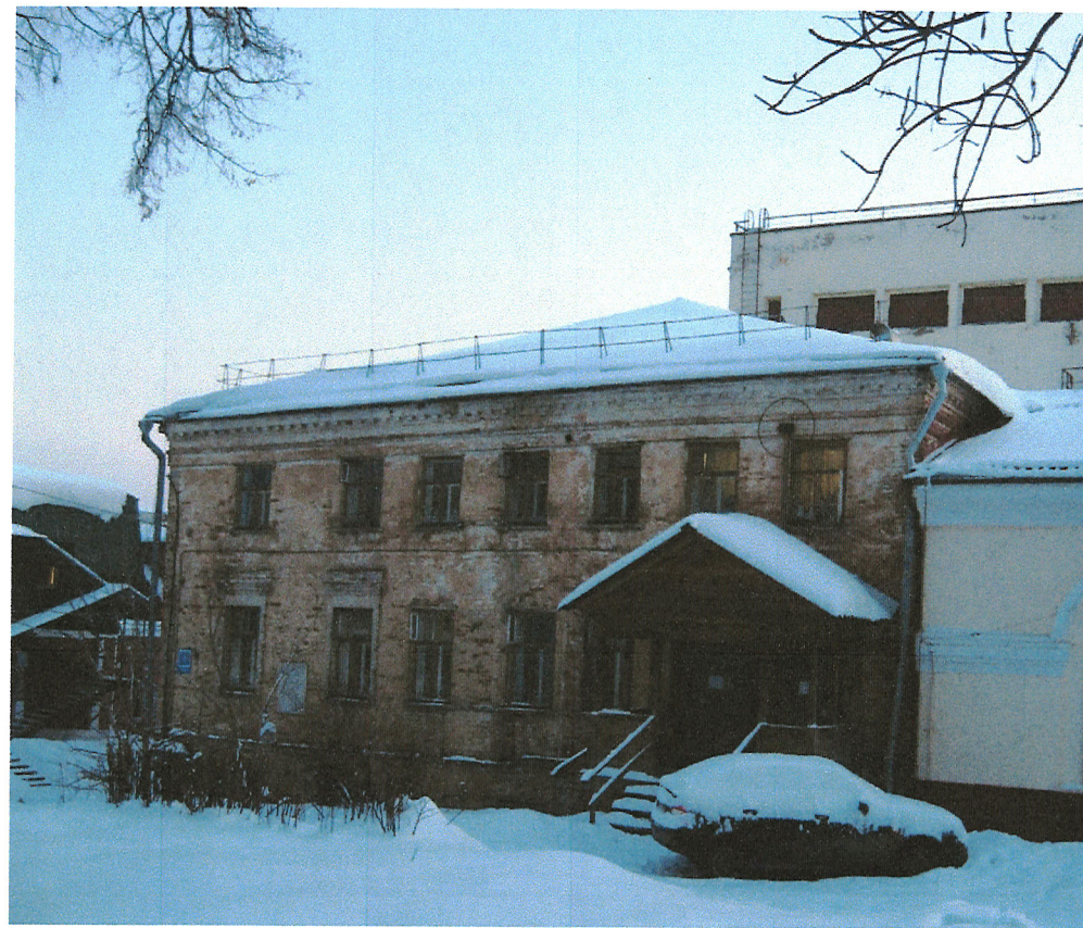
Фото 5. Северный фасад. Вид с северо-запада. Фотосъемка 2014 г.
