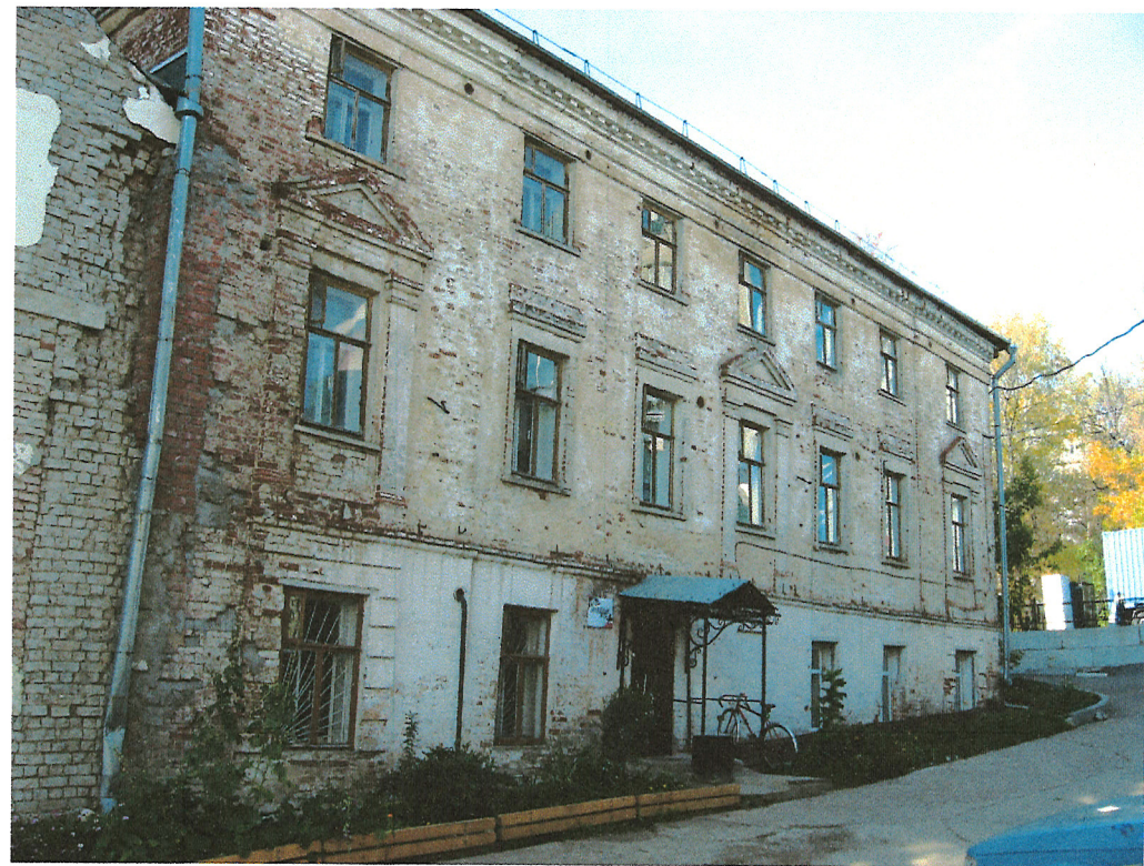
Фото 4. Восточный фасад. Вид с юго-востока с Кооперативного переулка. Фотосъемка 2013 г.
