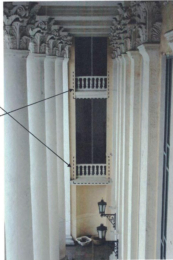
Фото 12. Вид на балконы главного фасада. Фотосъемка 2019 г.
