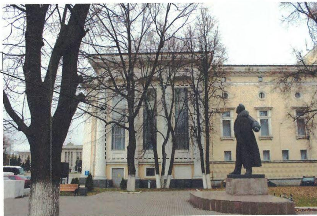
Фото 18. Восточный фасад. Общий вид. Фотосъемка 2019 г.
