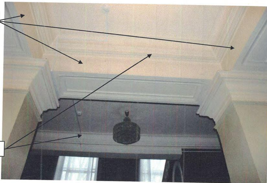
Фото 47. 1 этаж. Вестибюль. Потолок. Фотосъемка 2019 г.
