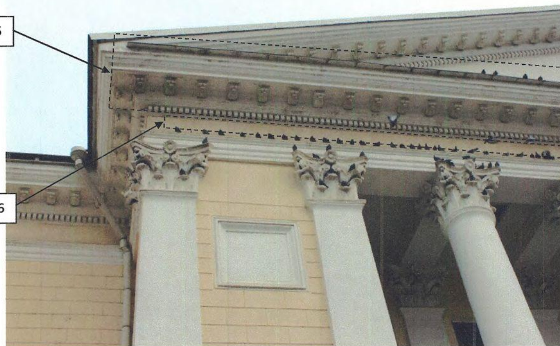
Фото 4. Фрагмент южного фасада. Фотосъемка 2019 г.
