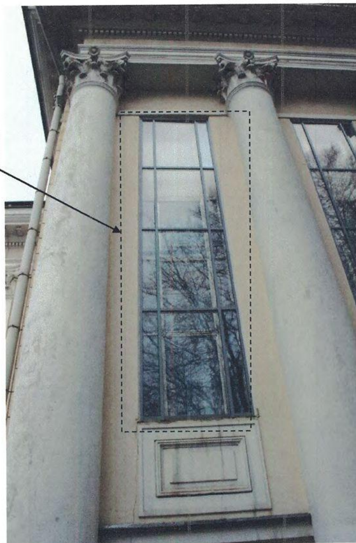
Фото 23. Фрагмент восточного фасада. Вертикальный оконный проем. Фотосъемка 2019 г.
