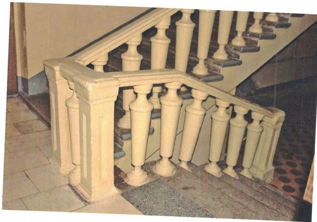
Фото 70. Лестничная клетка. Фотосъемка 2019 г.
