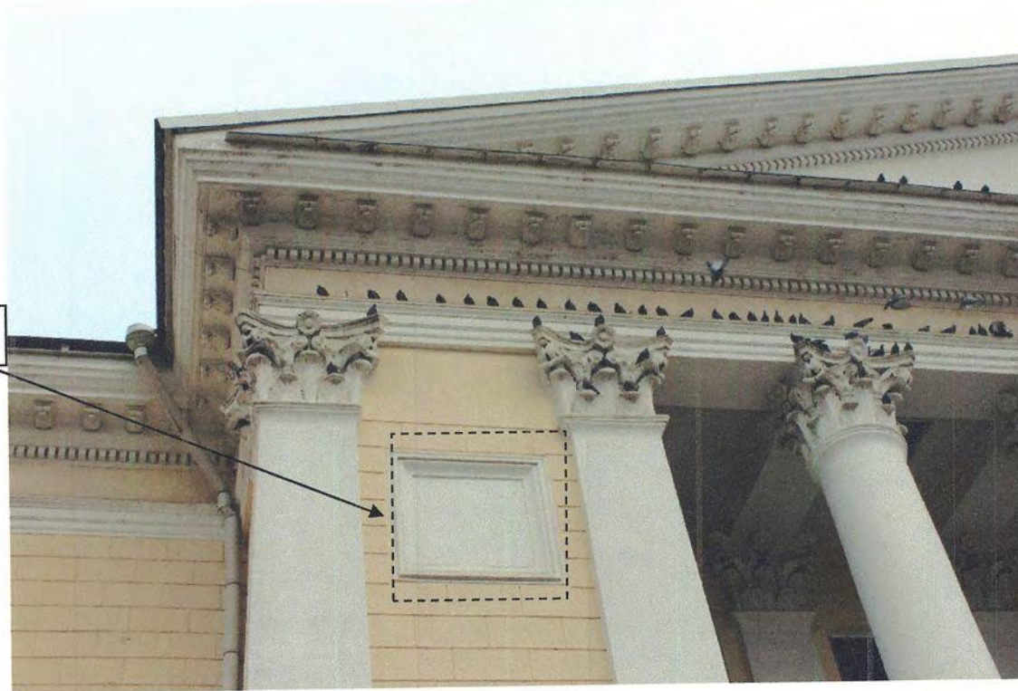
Фото 14.1. Фрагмент южного фасада. Ниша в стене декорированная профилем. Фотосъемка 2019 г.
