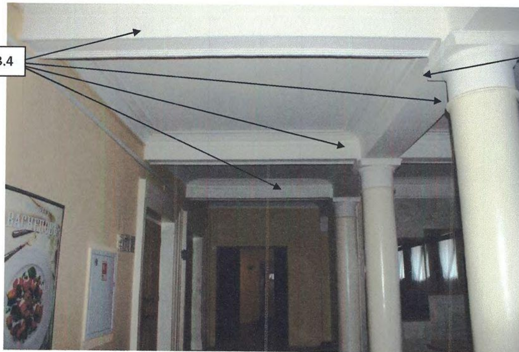
Фото 53. 1 этаж. Фойе. Балки потолка. Профилированный потолочный карниз. Фотосъемка 2019 г.
