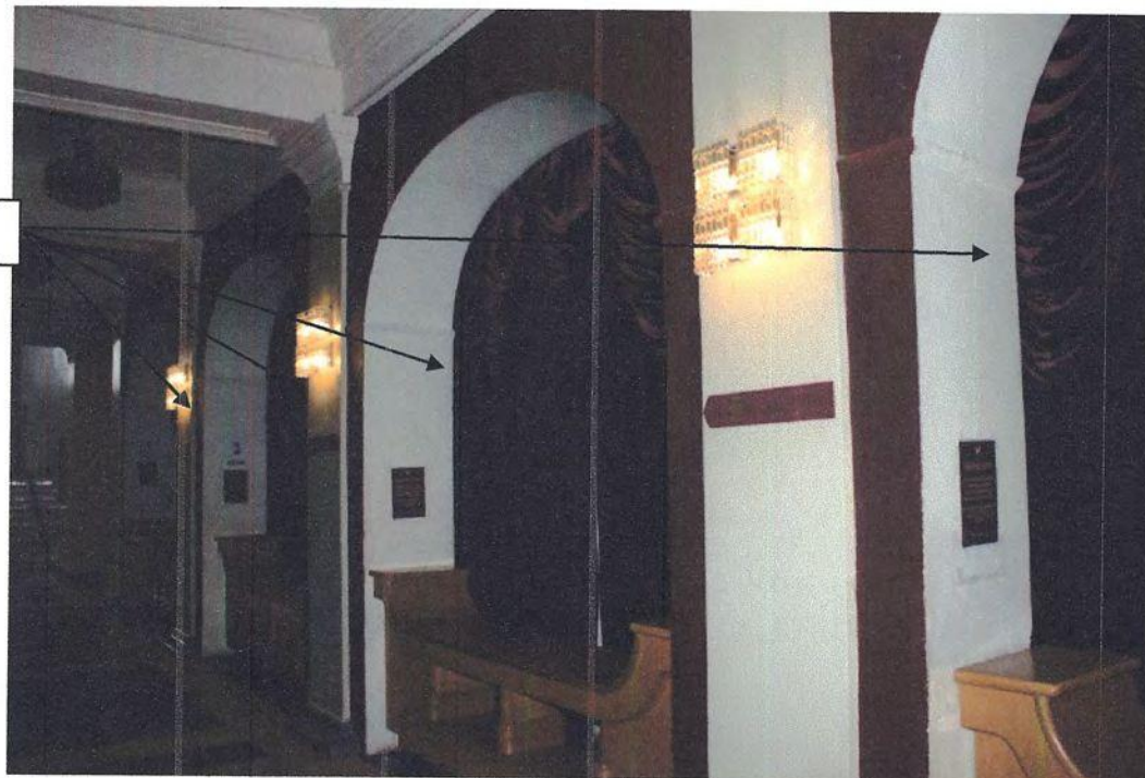
Фото 50. 1 этаж. Вестибюль. Арочные проемы. Фотосъемка 2019 г.
