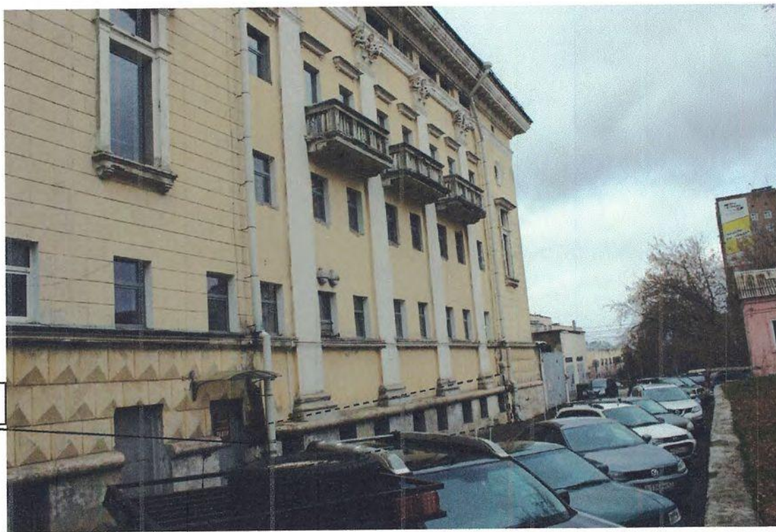
Фото 26. Фрагмен восточного фасада. Оконные проемы цокольного этажа. Фотосъемка 2019 г.
