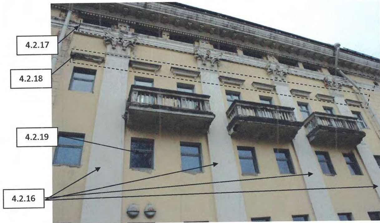
Фото 27. Фрагмент восточного фасада. Пилястры с капителями. Фотосъемка 2019 г.
