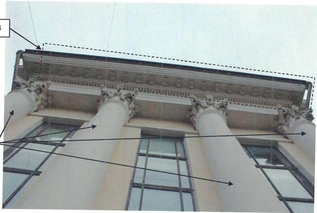
Фото 42. Фрагмент западного фасада. Карниз и колонны с капителями. Фотосъемка 2019 г.
