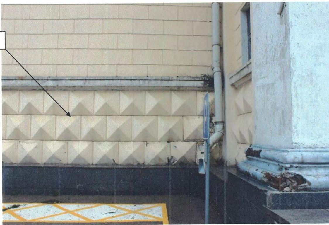
Фото 8. Фрагмент южного фасада. Фотосъемка 2019 г.
