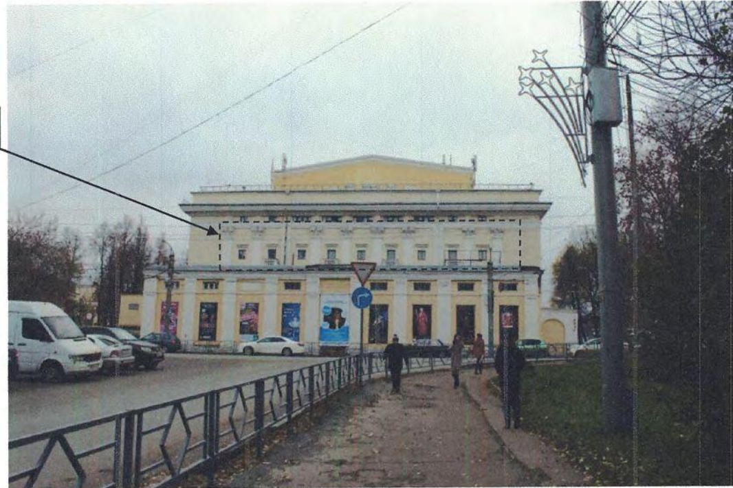
Фото 29. Северный фасад. Общий вид. Фотосъемка 2019 г.
