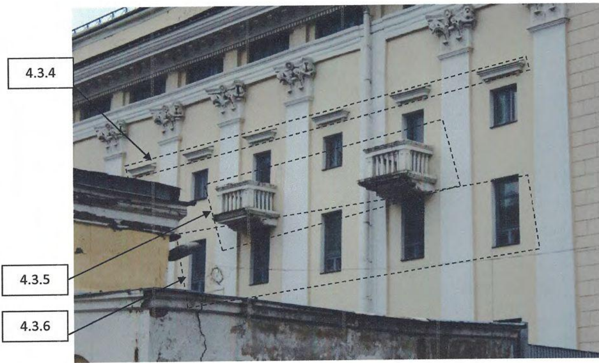
Фото 31. Фрагмент северного фасада. Фотосъемка 2019 г.
