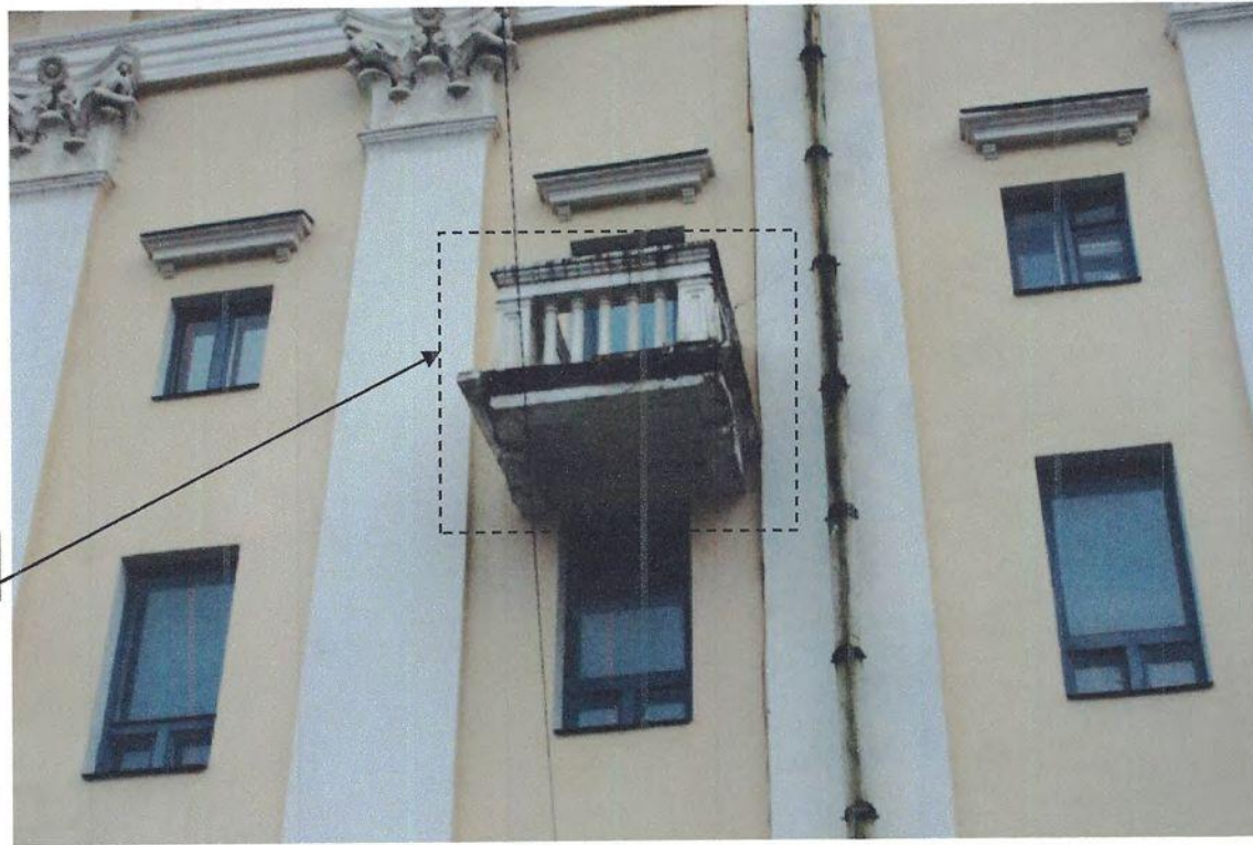
Фото 35. Фрагмент северного фасада. Фотосъемка 2019 г.
