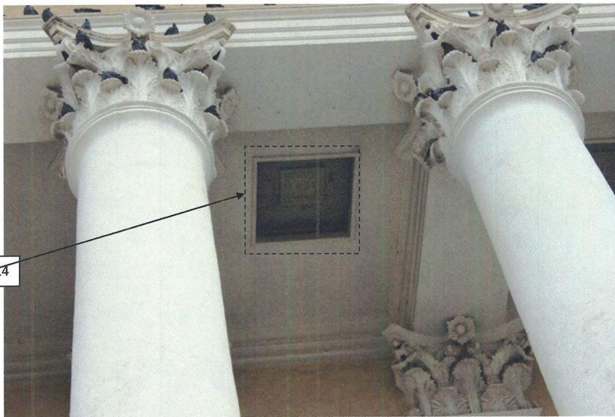
Фото 10. Фрагмент южного фасада. Фотосъемка 2019 г.
