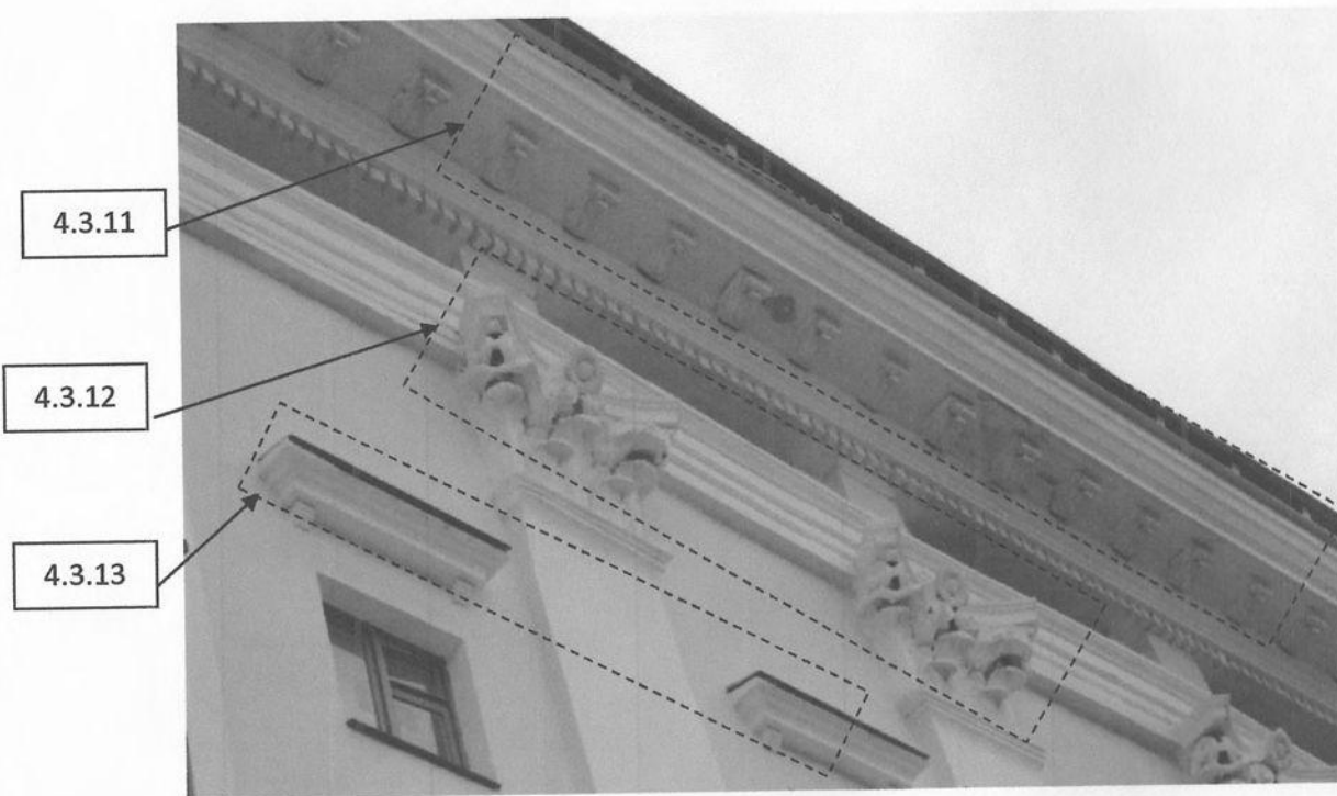
Фото 34. Фрагмент северного фасада. Карниз и капители пилястр. Фотосъемка 2019 г.
