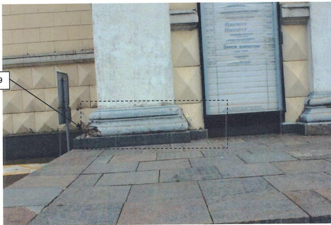
Фото 6. Фрагмент южного фасада. Фотосъемка 2019 г.
