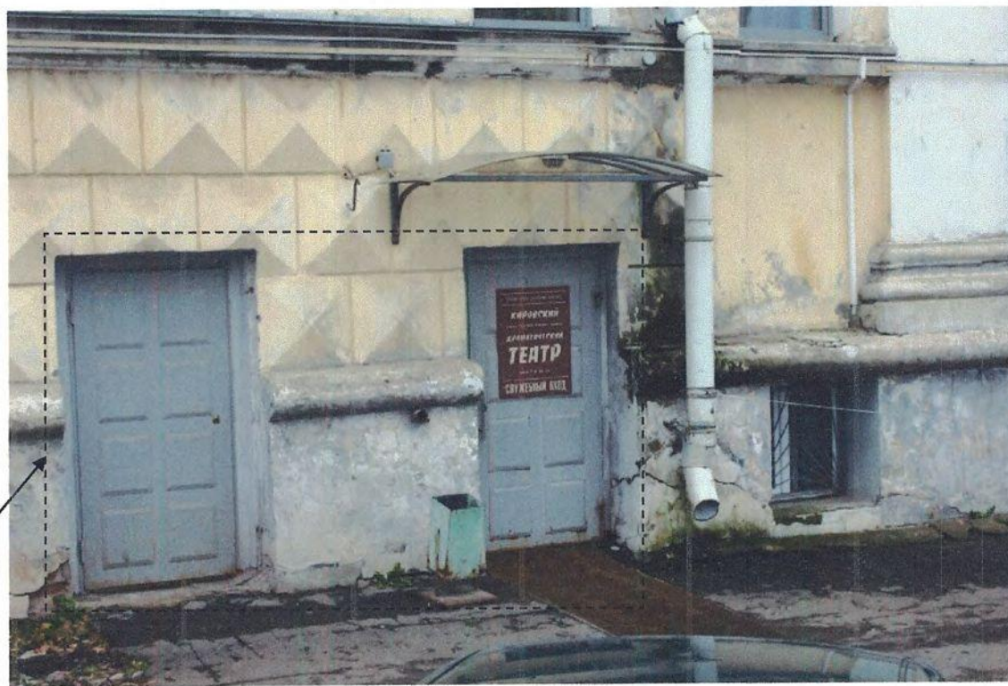
Фото 25. Фрагмент восточного фасада. Двери цокольного этажа. Фотосъемка 2019 г.
