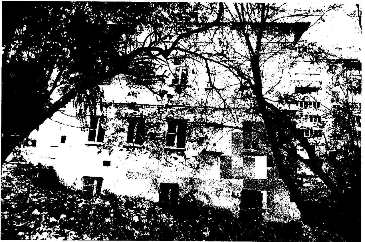
Фото 11. Южный (дворовый) фасад.
