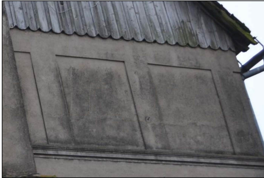
Прямоугольные фальшокна на уровне третьего этажа северного фасада
