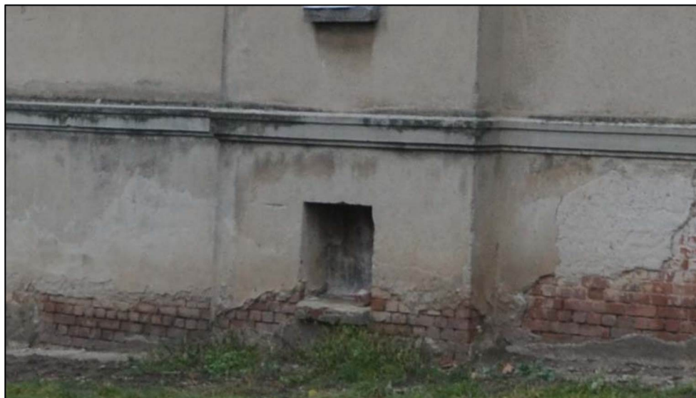
Цокольный карниз южного фасада
