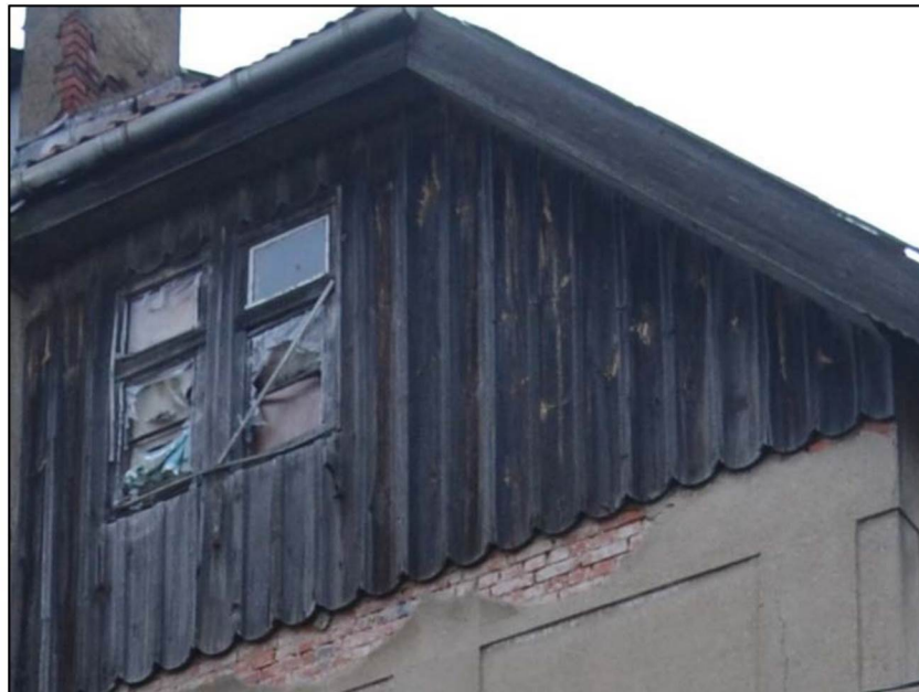
Тесовая обшивка в форме «бобровый хвост» на щипце южного фасада
