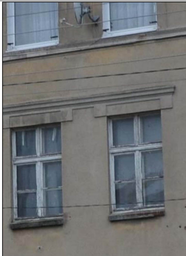
Сандрики оконных проемов второго этажа восточного фасада
