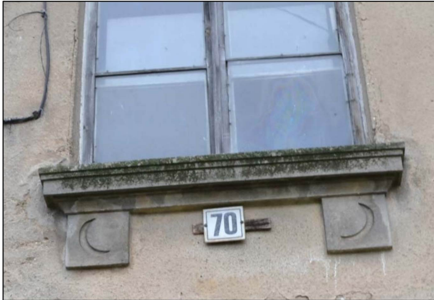
Карниз на консолях под оконным проемом первого яруса на раскреповке восточного фасада
