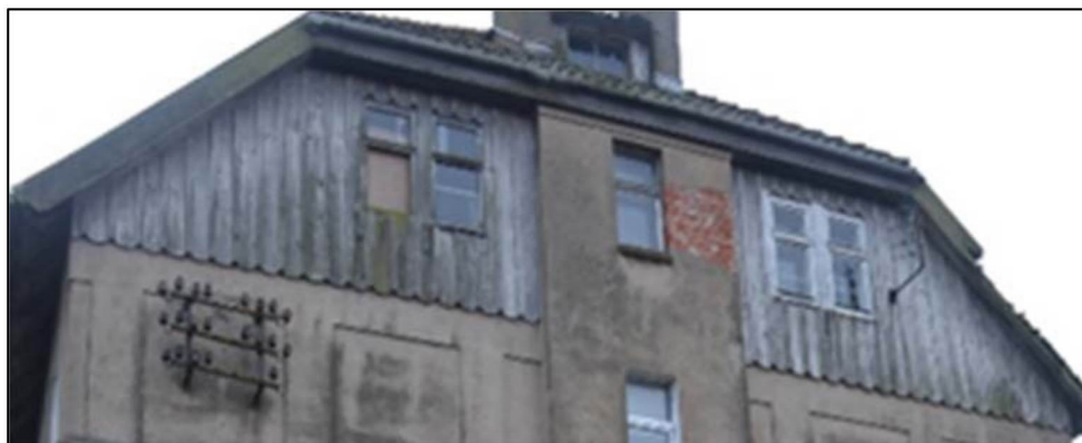
Северный (боковой) фасад (обшивка мансардного этажа)
