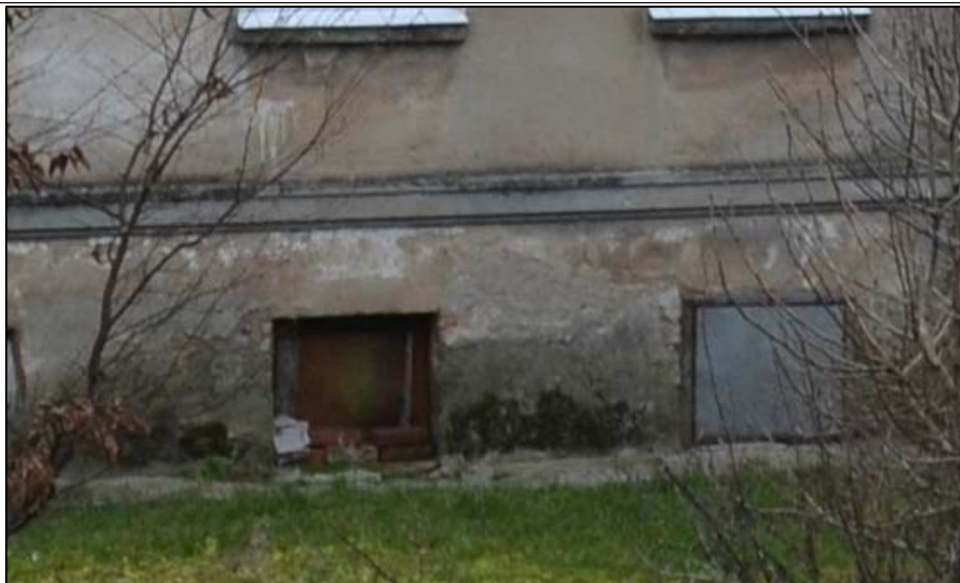
Цокольный карниз восточного фасада
