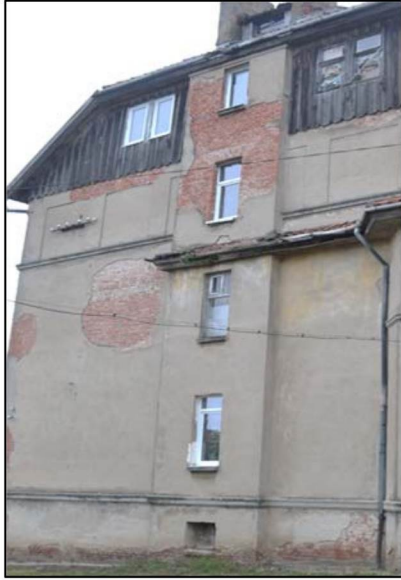
Оконные проемы южного фасада
