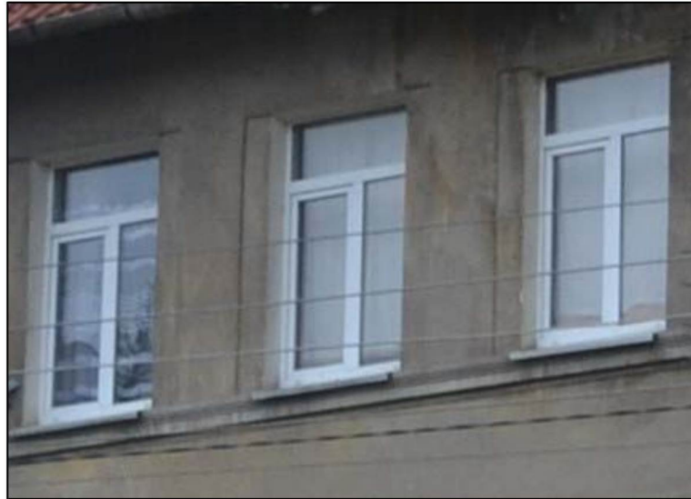
Подоконный карниз третьего этажа восточного фасада.
