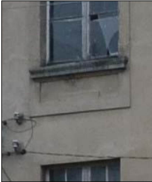
Прямоугольная филенка под оконным проемом второго яруса раскреповки восточного фасада
