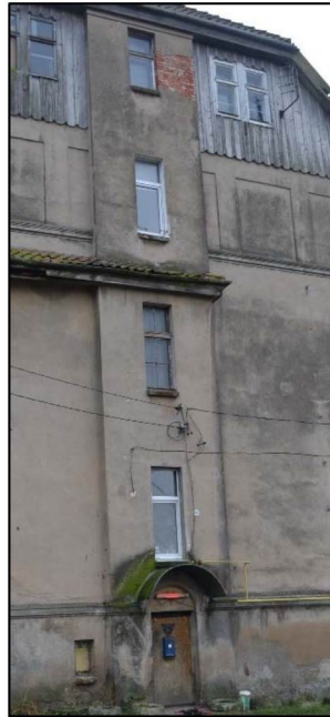
Раскреповка северного фасада
