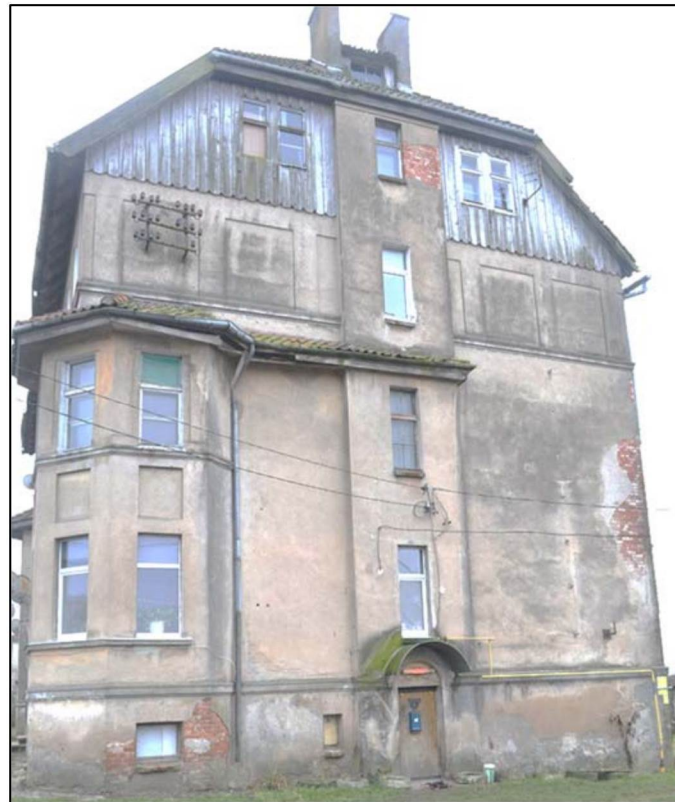
Оконные проемы северного фасада
