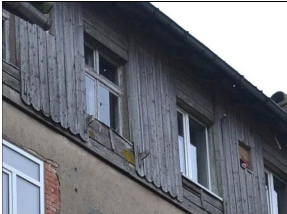
Тесовая обшивка в форме «бобровый хвост» на мансарде западного фасада
