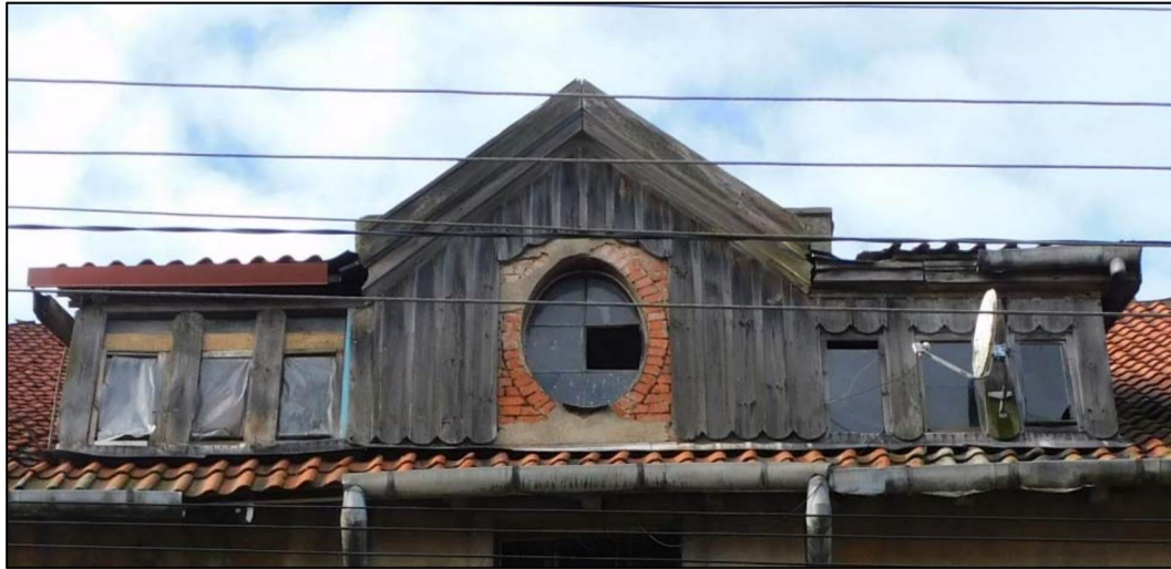
Оконные проемы мансарды (восточный фасад)
