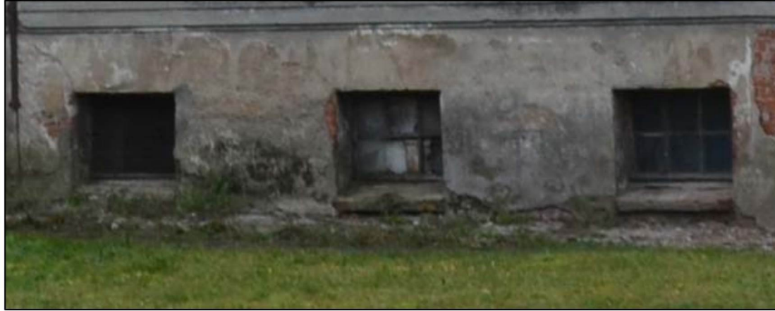
Оконные проемы цоколя в северной части восточного фасада
