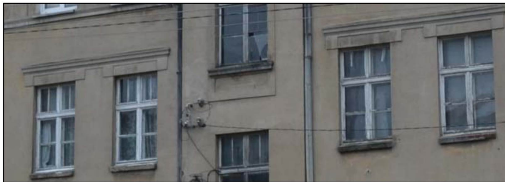
Оконные проемы второго этажа (восточный фасад)
