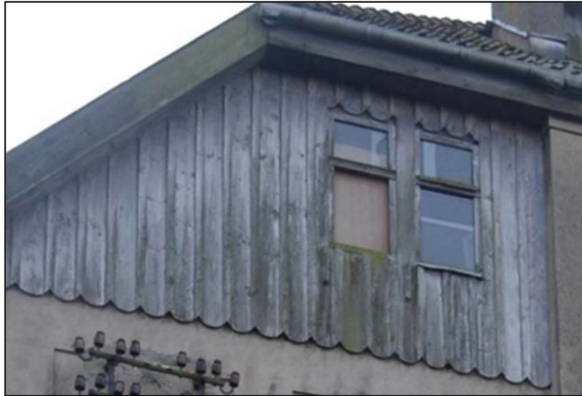
Тесовая обшивка в форме «бобровый хвост» на щипце северного фасада
