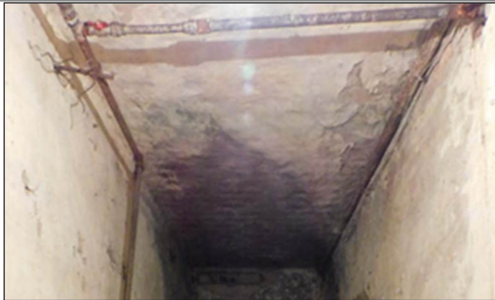
Армокирпичные плоские потолки в подвалах
