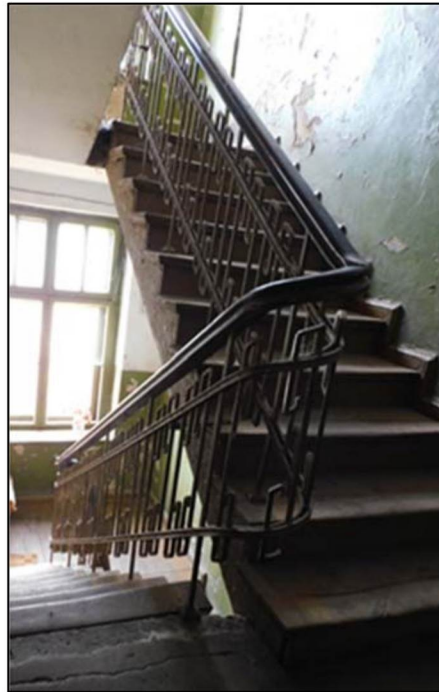
Двухмаршевые бетонные межэтажные лестницы
