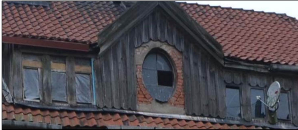
Тесовая обшивка в форме «бобровый хвост» на мансарде восточного фасада
