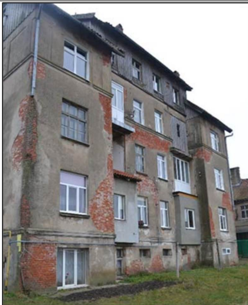
Западный (дворовой) фасад.
