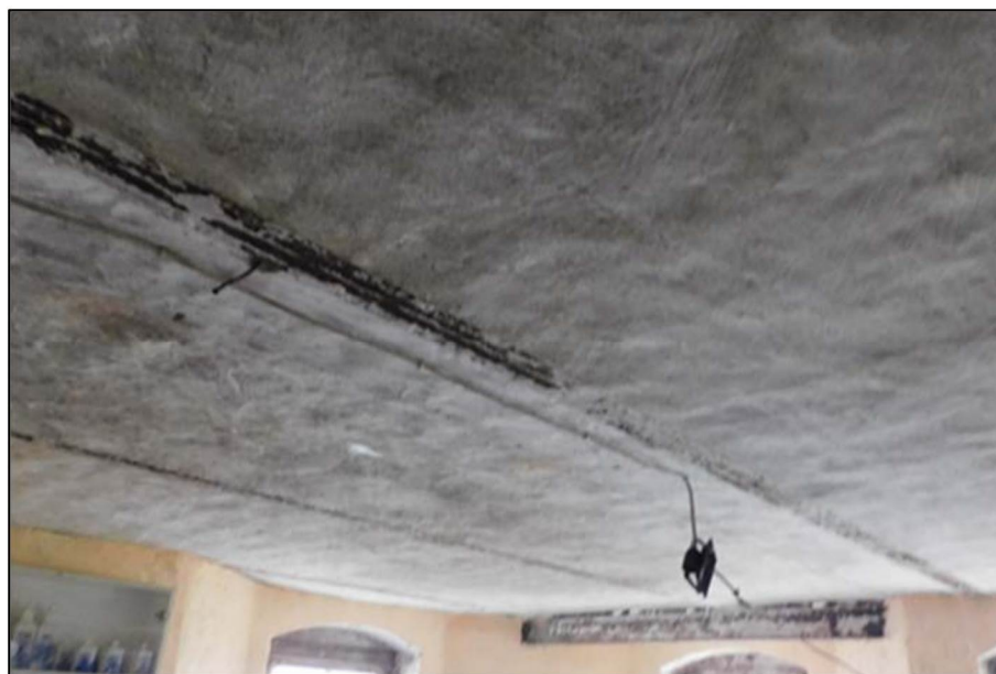
Потолки со сводами монье в подвалах
