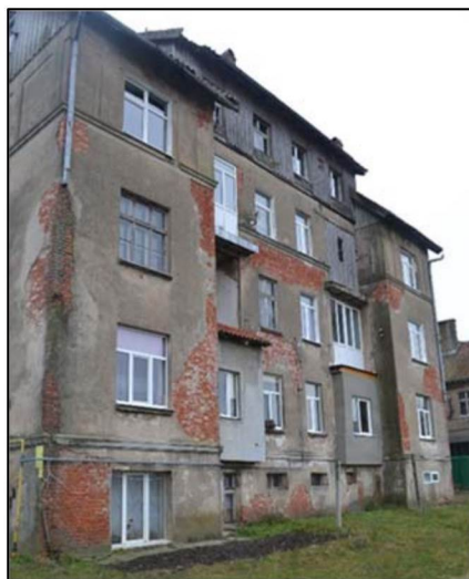
Западный (дворовой) фасад
