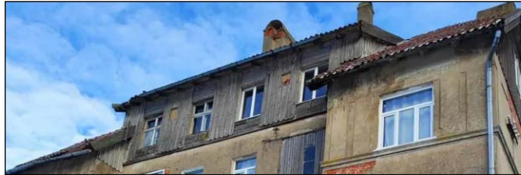
Западный скат крыши
