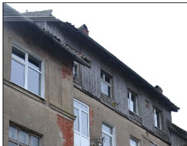
Западный (дворовой) фасад (обшивка мансардного этажа)
