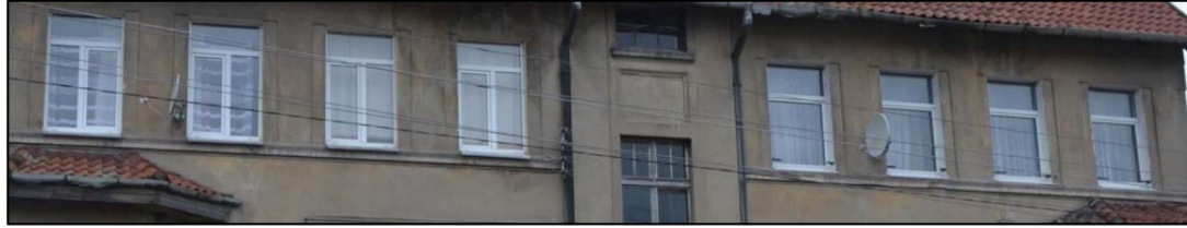
Оконные проемы третьего этажа (восточный фасад)
