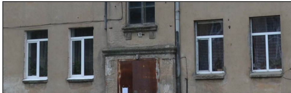
Оконные проемы первого этажа (восточный фасад)
