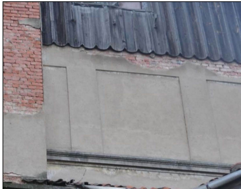
Прямоугольные фальшокна на уровне третьего этажа южного фасада
