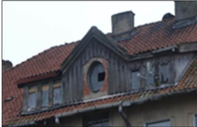
Восточный (главный) фасад (обшивка мансардного этажа)
