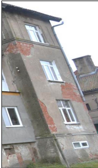
Оконные проемы южного ризалита западного фасада
