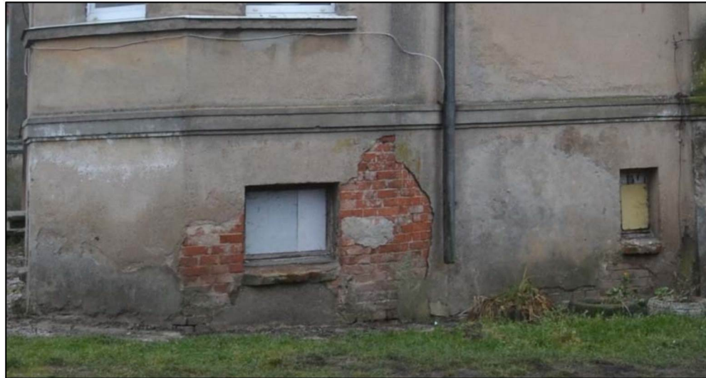
Цокольный карниз северного фасада
