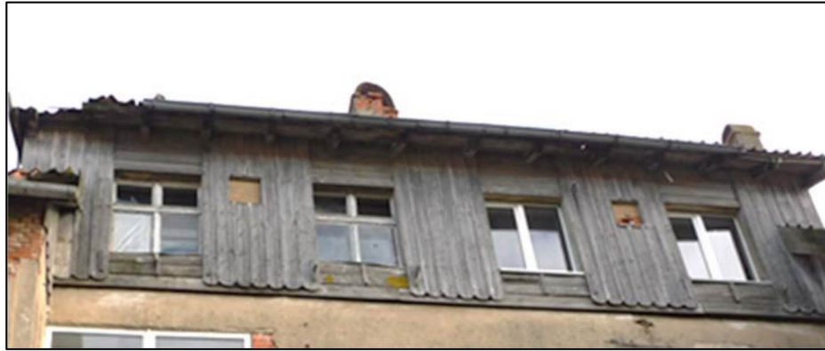
Оконные проемы на мансардном этаже западного фасада
