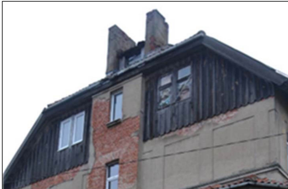
Южный (боковой) фасад (обшивка мансардного этажа)
