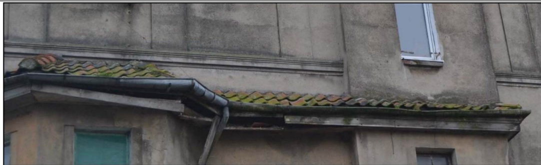
Козырек с деревянной подшивкой и черепичной кровлей на уровне свеса крыши эркера на северном фасаде
