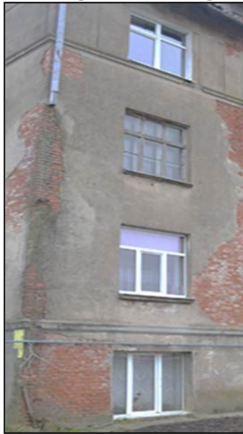
Оконные проемы на северном ризалите западного фасада
