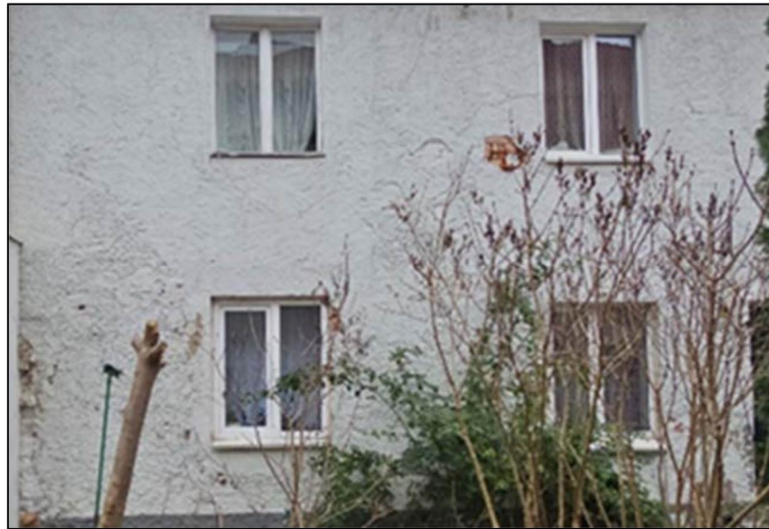
Оконные проемы дворового фасада
