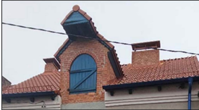
Скат крыши со стороны главного фасада
