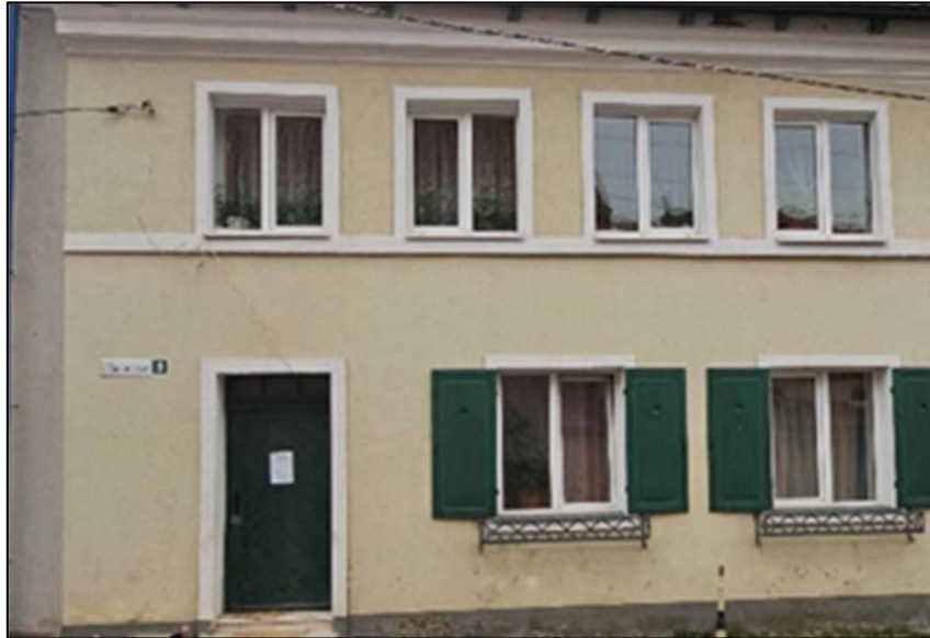
Главный (восточный) фасад
