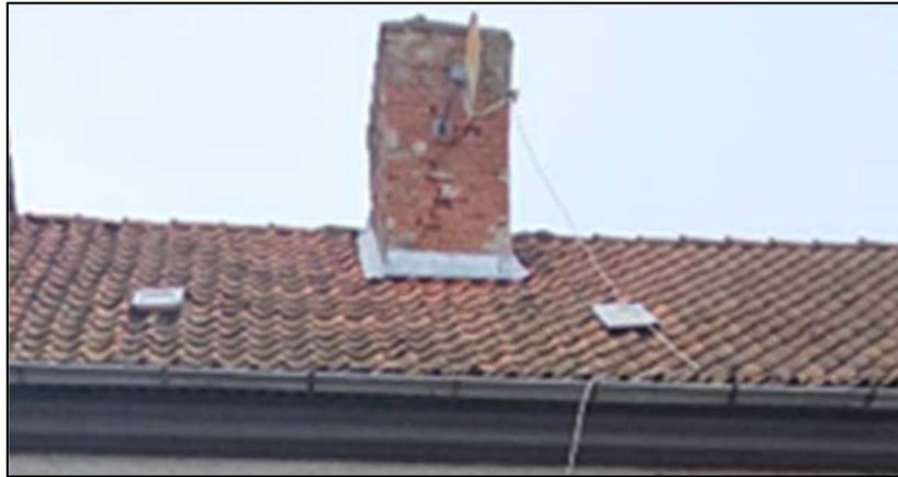
Скат крыши по главному фасаду
