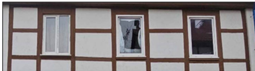
Оконные проемы второго этажа дворового фасада
