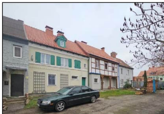
Общий вид на ансамбль со стороны двора.
