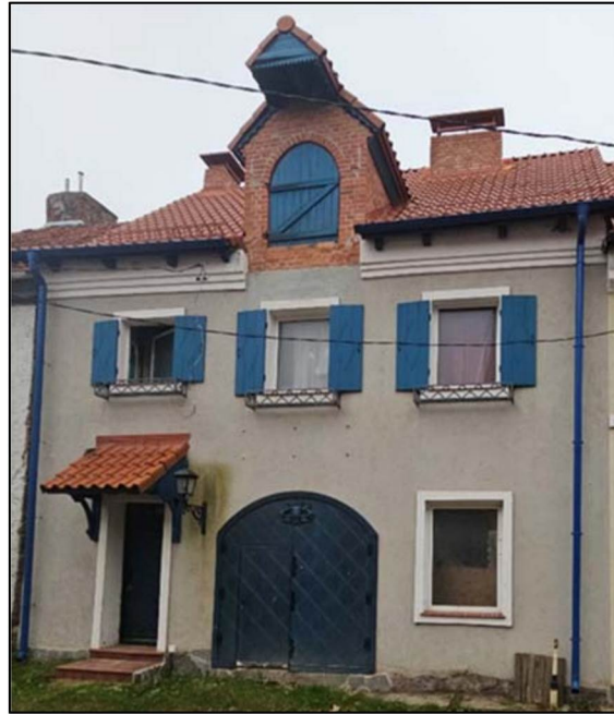
Главный (восточный) фасад
