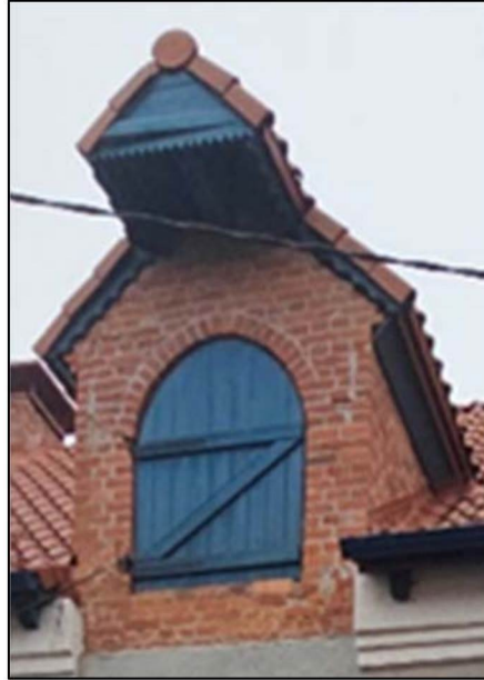
Надстройка хозяйственного люка с выступающим подъемником
