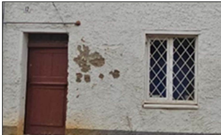
Оконный и дверной проемы на главном фасаде (первый этаж)
