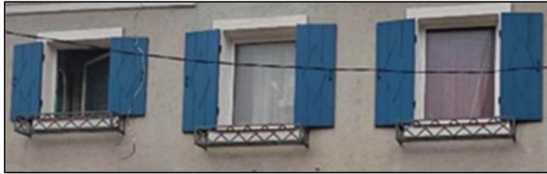
Оконные проемы второго этажа главного фасада
