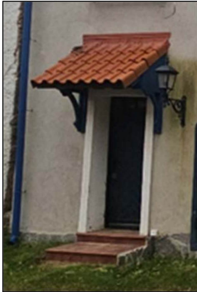
Дверной проем главного входа
