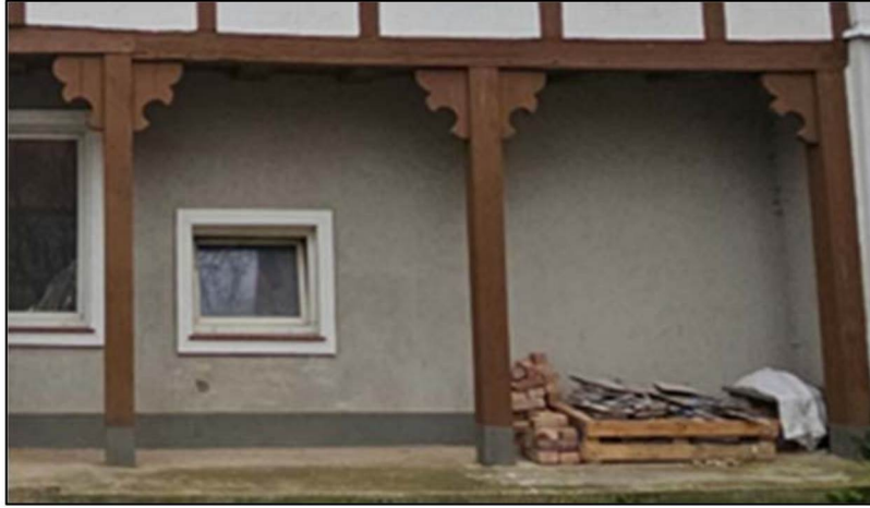
Квадратные деревянные столбы с консолями опор этажного выступа
