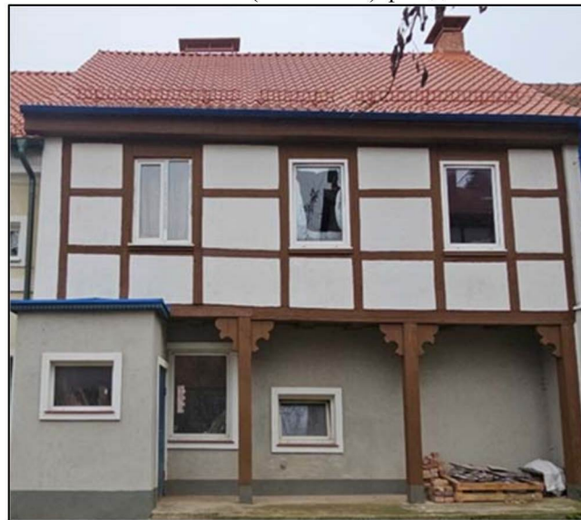
Дворовой (западный) фасад
