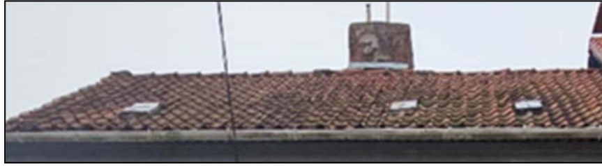
Скат крыши по главному фасаду
