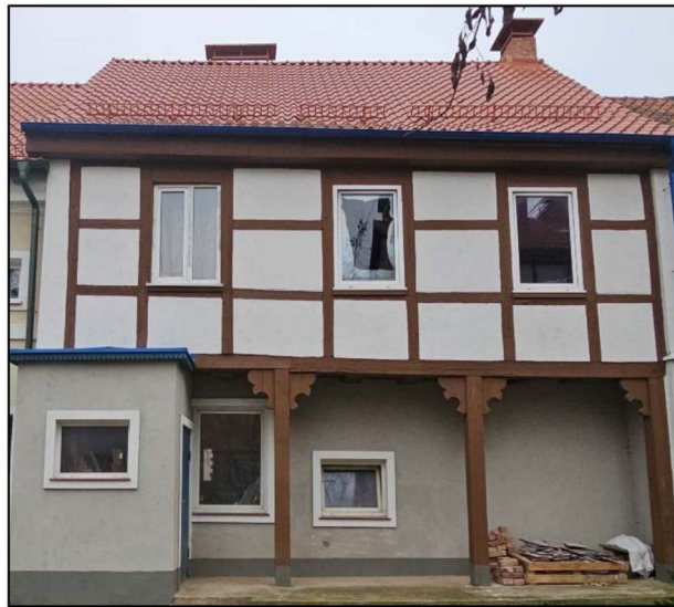
Дворовой (западный) фасад с этажным выступом на деревянных квадратных столбах
