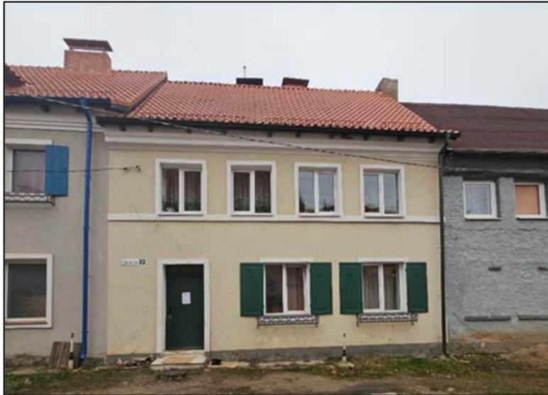
Главный (восточный) фасад
