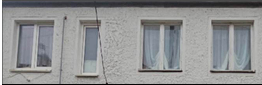
Оконные проемы второго этажа главного фасада
