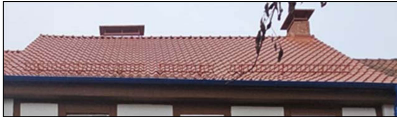
Скат крыши со стороны дворового фасада
