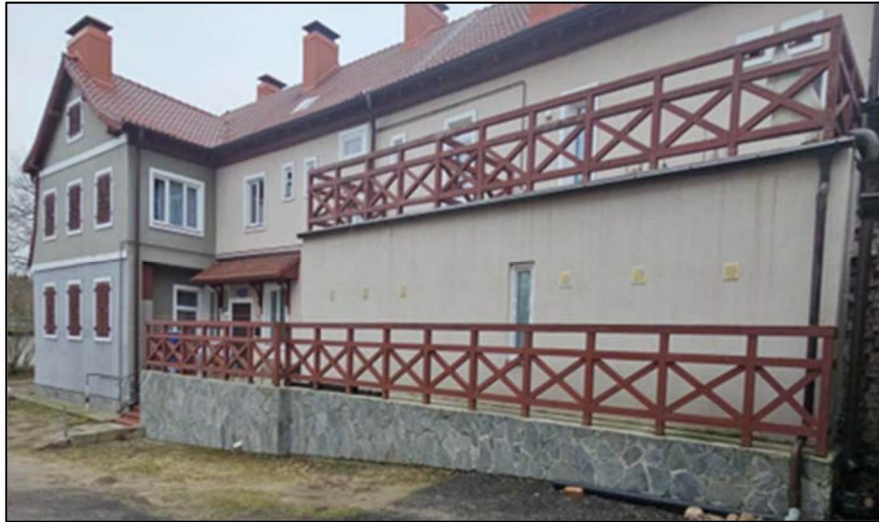
Оконные проемы западного фасада
