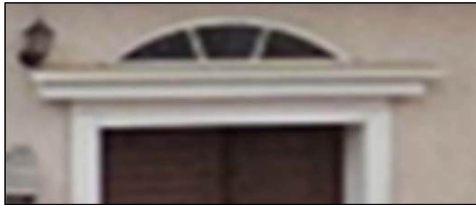
Сандрик над дверным проемом восточного фасада
