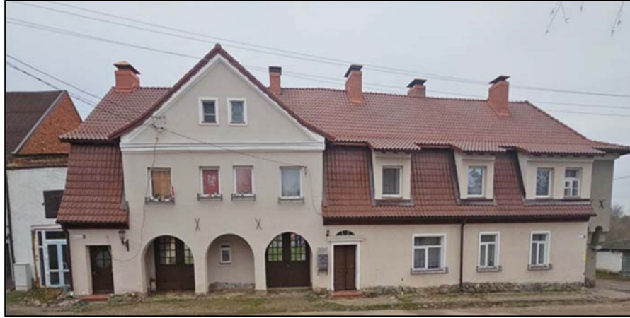
Оконные и дверные проемы восточного фасада
