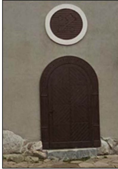
Дверной проем северного фасада
