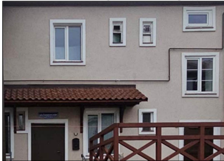
Наличники оконных и дверных проемов западного фасада
