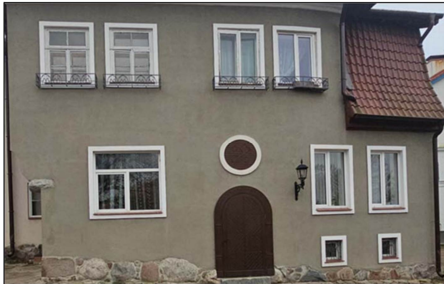
Оконные и дверной проемы северного фасада
