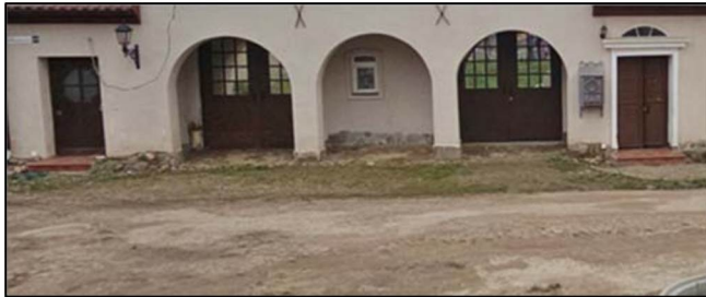
Дверные проемы восточного фасада
