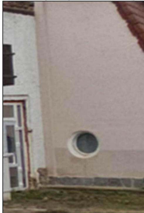
Оконный проем южного фасада
