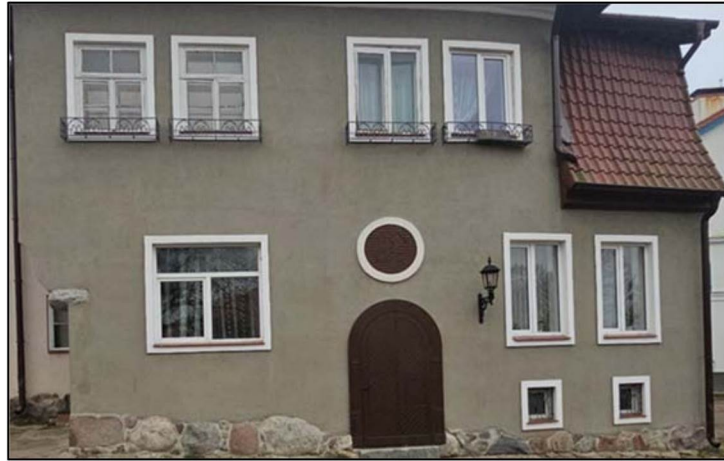
Наличники оконных проемов северного фасада.
