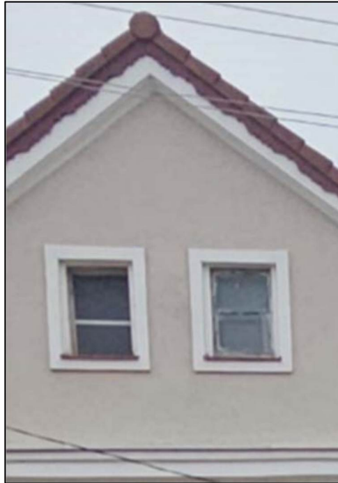
Наличники оконных проемов восточного фасада
