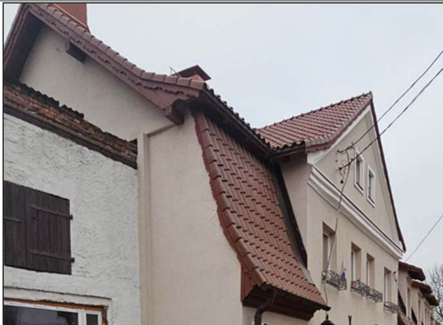
Вид на скаты крыши с юга
