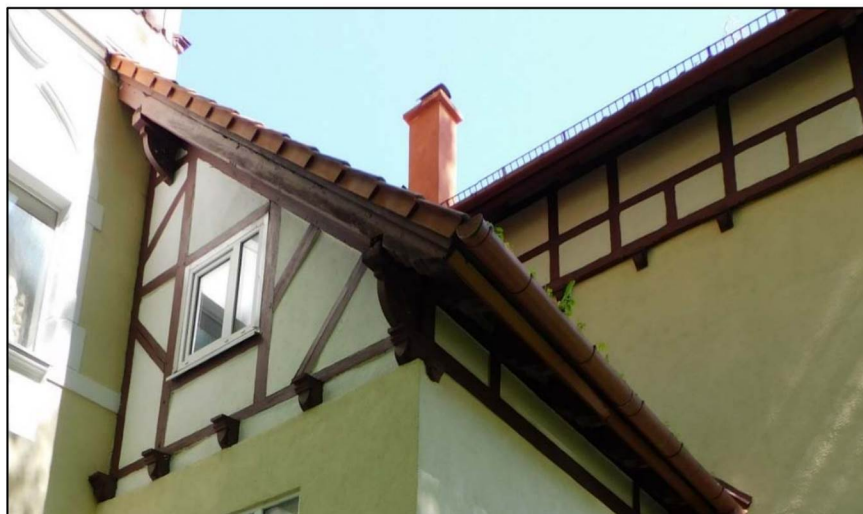
Фото 6. Вид фахверка на западном фасаде основного объема и боковой западной стене восточного ризалита.
