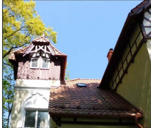
Фото 10. Вид южного ската крыши.
