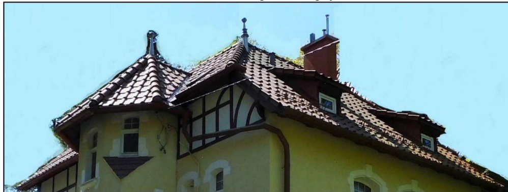
Фото 8. Вид крыши с северо-востока. Северный и восточный скаты.
