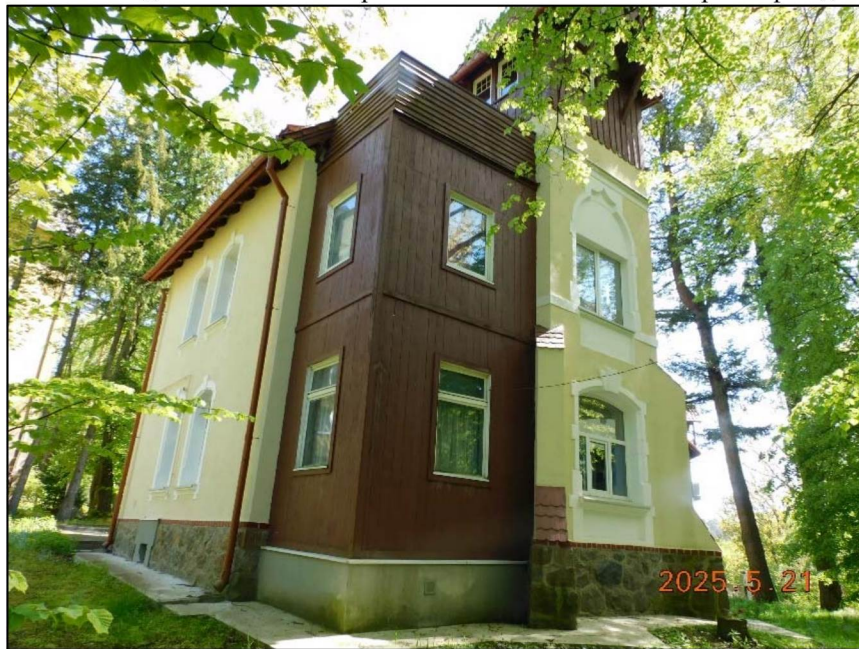
Фото 2. Вид Памятника с северо-запада. Северный и западный фасады.
