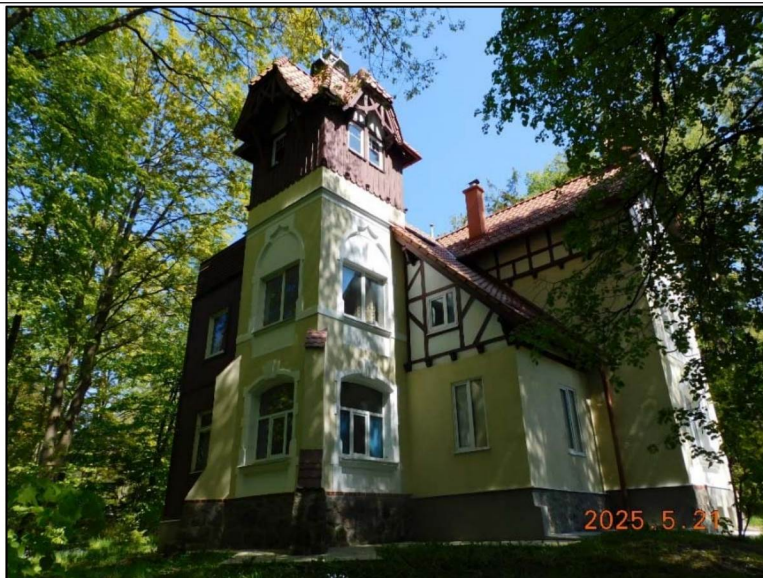
Фото 5. Вид Памятника с юго-запада. Южный и западный фасады.
