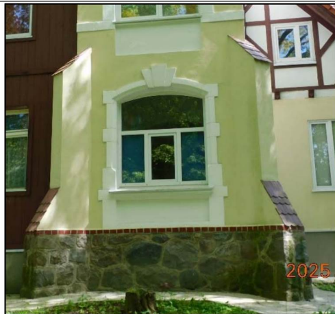
Фото 3. Вид контрфорсов башни-ризалита.
