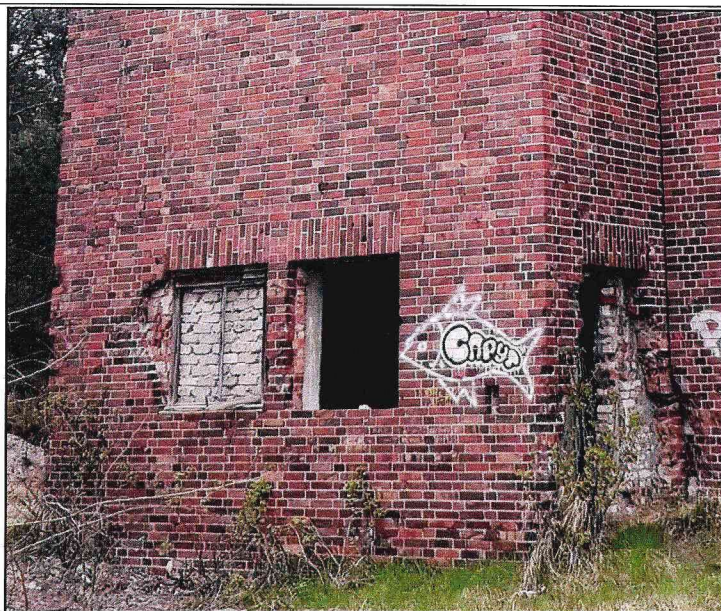
Оконный и дверной проемы в юго-западной башне.
