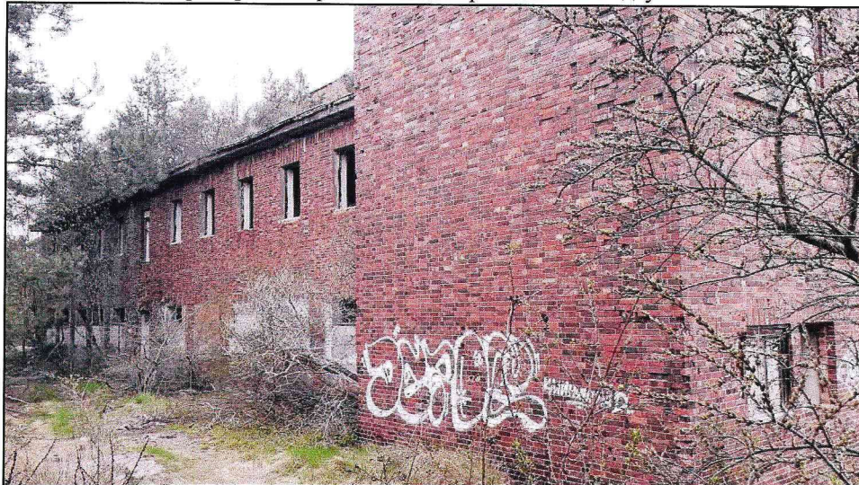
Вид фрагмента юго-западного фасада Памятника, двухэтажная пристройка и нижняя часть башни (справа).
