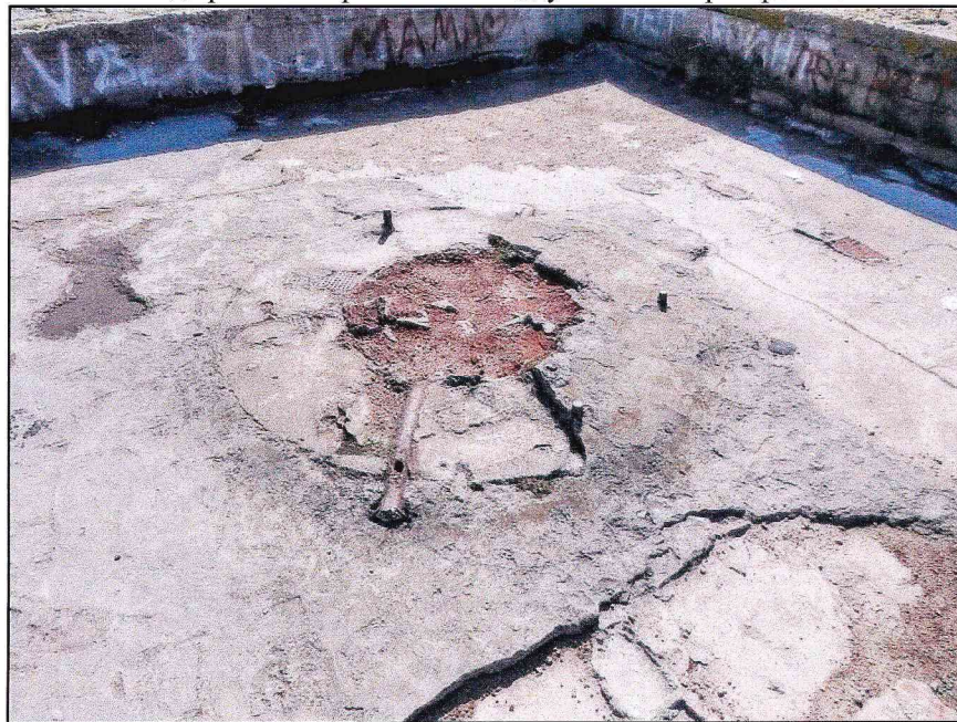
Вид крыши северо-восточной башни. В центре цоколь крепления зенитного автомата.
