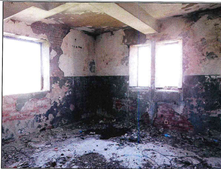
Вид помещения на третьем этаже северо-восточной башни.
