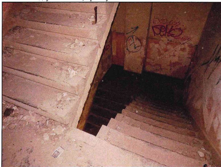
Междуэтажная лестница в северо-восточной башне.
