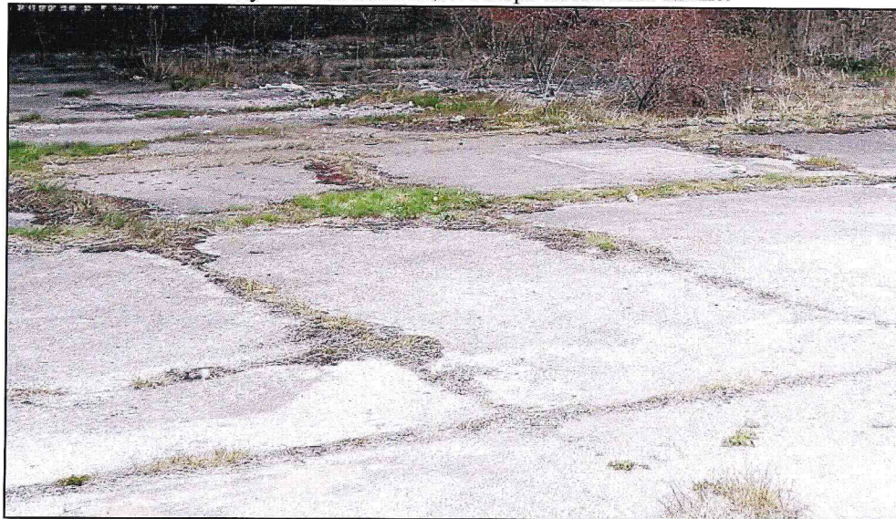
Пол ангара покрытый железобетоном.
