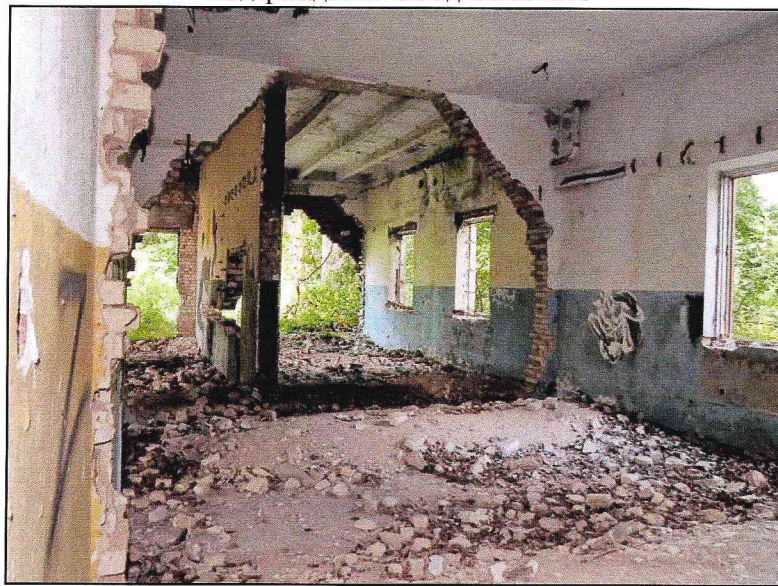
Помещения на первом этаже северо-восточной двухэтажной пристройки.
