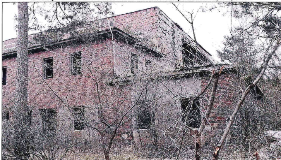
Вид с востока. Примыкание северо-восточной двухэтажной пристройки и одноэтажного блока северо-западной пристройки.
