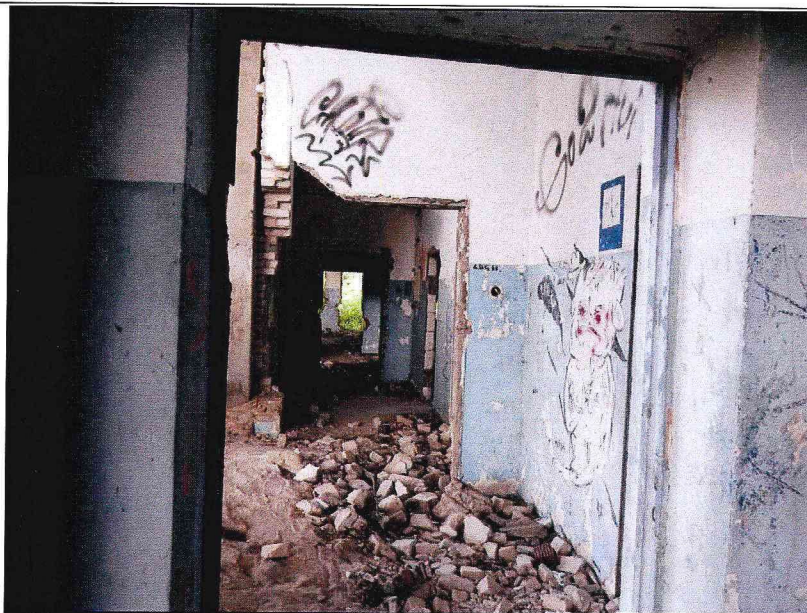
Продольный коридор на первом этаже северо-восточного двухэтажного объема.
