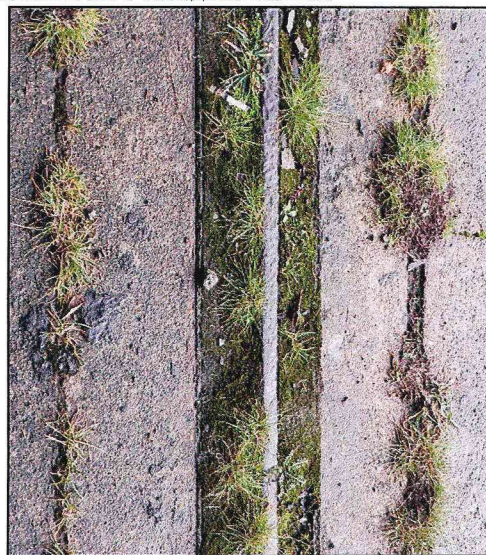
Фрагмент фасадной арки ангара и участка площадки с направляющими для перемещения створок ворот.
