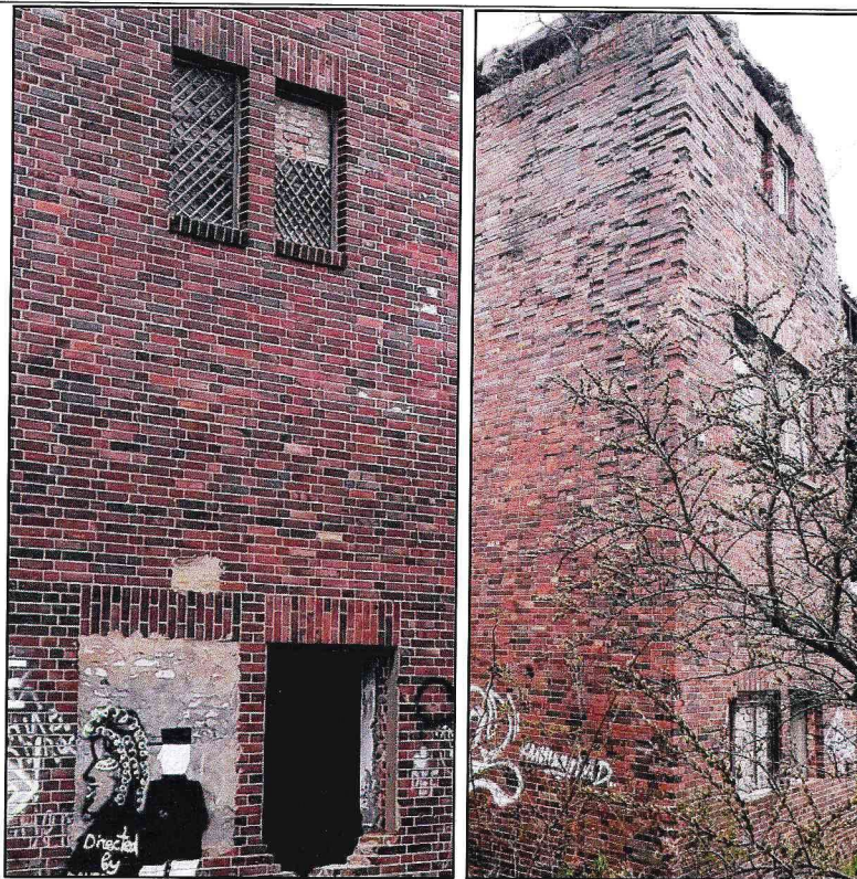
Вид оконных проемов северо-восточной и юго-западной башен.
