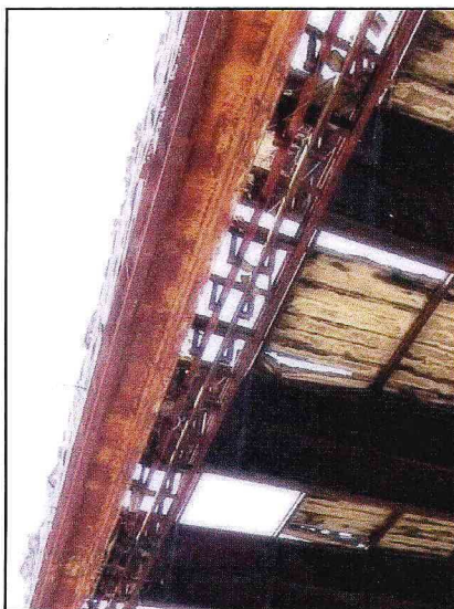
Фрагмент фасадной арки ангара и участка площадки с направляющими для перемещения створок ворот.
