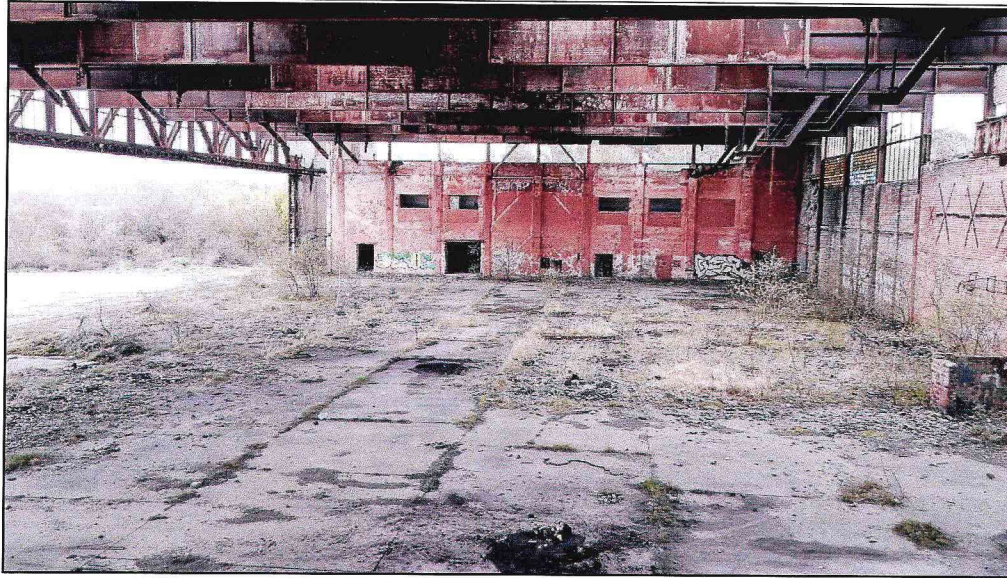
Вид внутри ангара с северо-востока.
