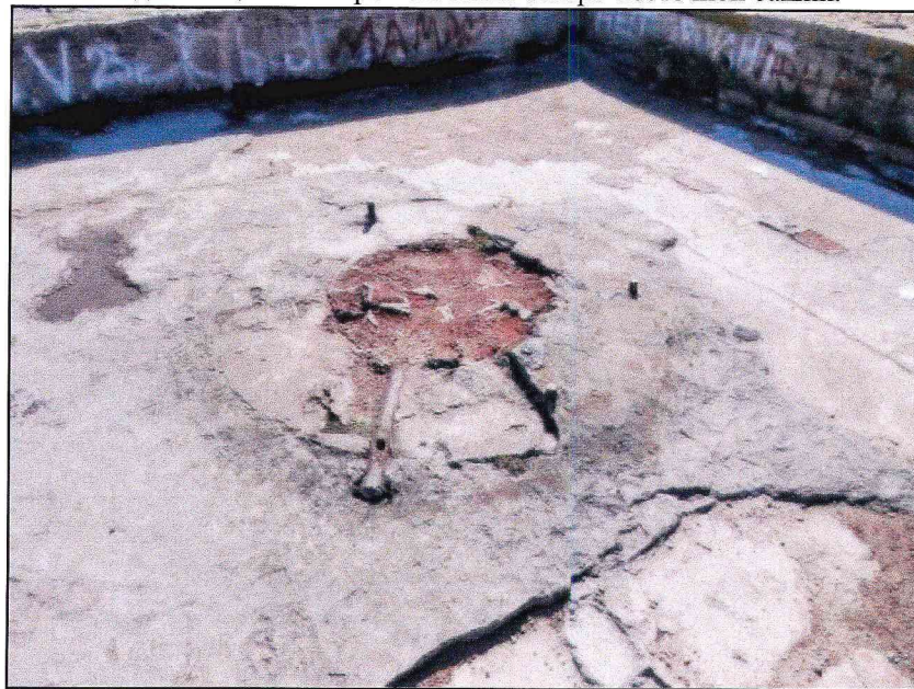
Вид бетонной площадки с ограждением, завершающей северо-восточную башню.
