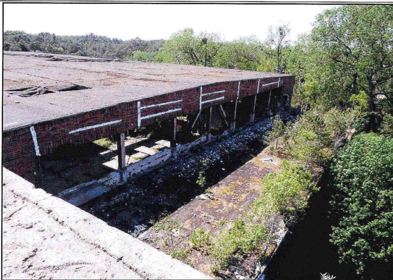
Вид крыши северо-восточной двухэтажной пристройки.
