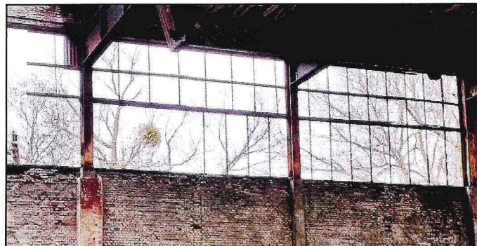
Световые проемы на юго-восточном и северо-западном фасадах ангара.
