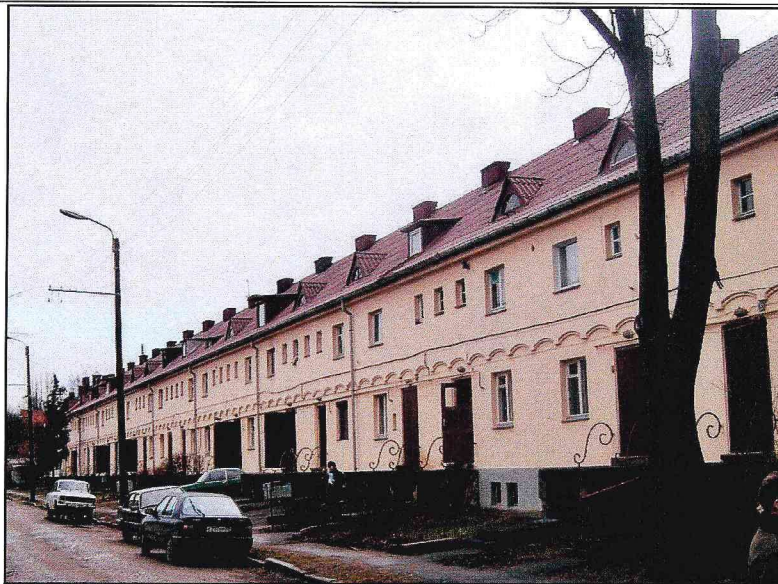
Фото 1. Вид с северо-запада. Северный главный фасад.
