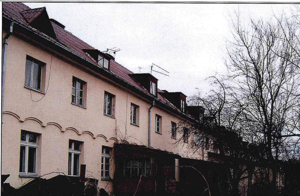
Фото 7. Южный скат крыши.
