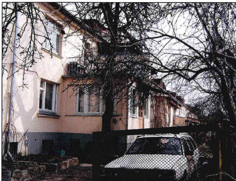
Фото 2. Вид с юго-запада. Южный дворовый фасад.
