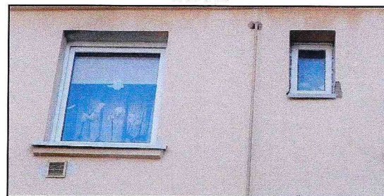
Фото 3. Оконные проемы на фасадах.
