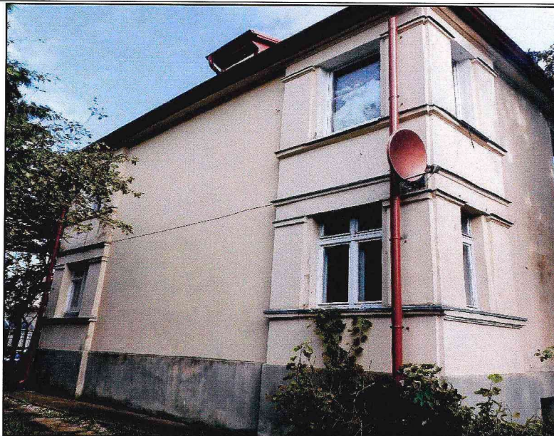
Фото 3. Вид с юго-запада. Западный боковой фасад Памятника.
