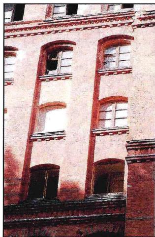
Фото 3. Оконные проемы в нише на южном дворовом фасаде.
