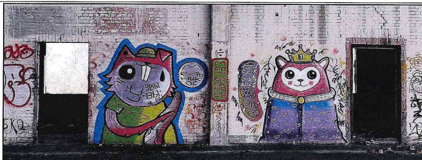
Вид дверных проемов внутри ангара.
