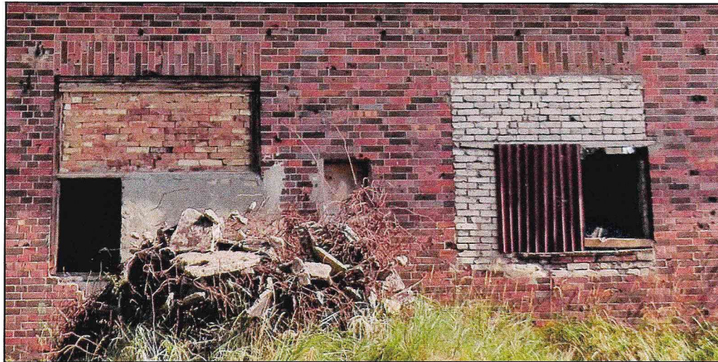
Вид оконных проемов западного фасада западной одноэтажной пристройки.
