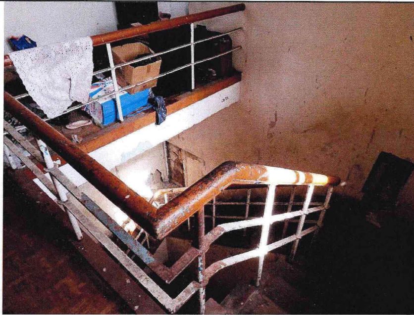
Вид междуэтажной лестницы южной части двухэтажного объема.
