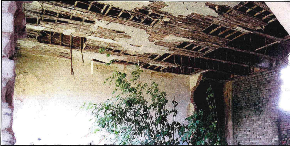
Вид перекрытия в помещении первого этажа.
