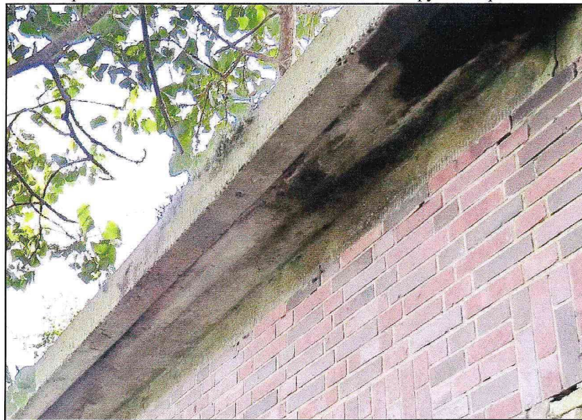
Вид карнизного свеса железобетонной крыши северной одноэтажной пристройки к основному объему ангара.
