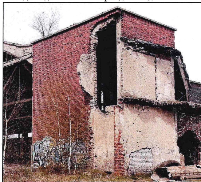
Вид восточного и южного фасадов восточной башни.
