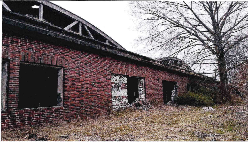
Фрагмент северного фасада северной одноэтажной пристройки к основному объему.
