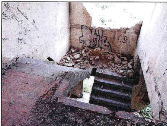
Междуэтажная лестница и аварийный второй этаж в двухэтажной восточной пристройке.
