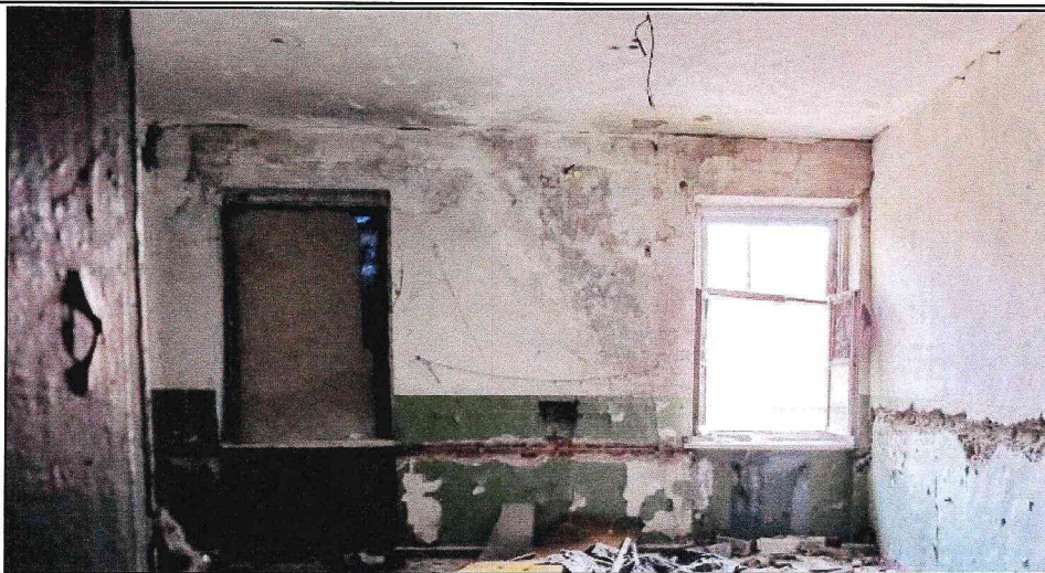
Вид перекрытия в помещении второго этажа.
