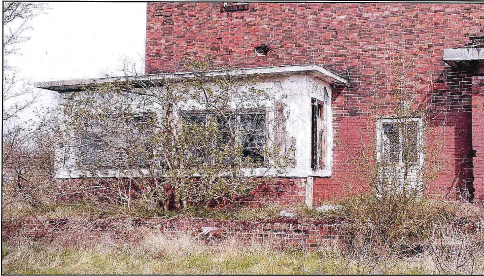
Вид южного фасада веранды и невысокой подпорной стенки, огибающей фасад башни.
