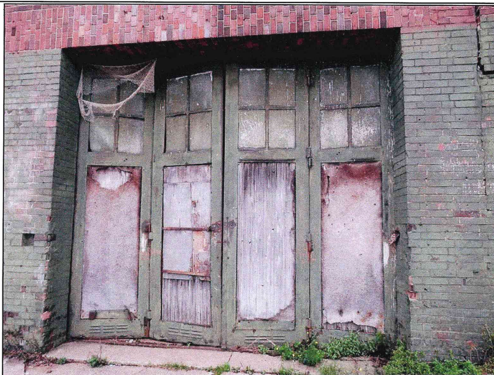
Вид воротных проемов на фасаде двухэтажного объема.
