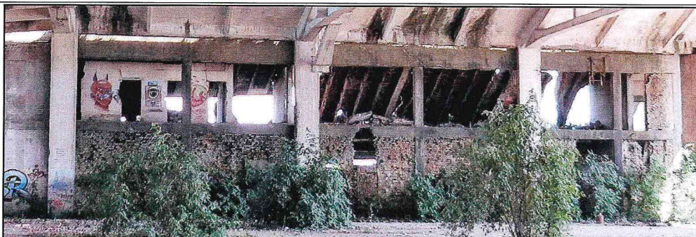
Вид смежной стены восточной двухэтажной пристройки и основного объема.
