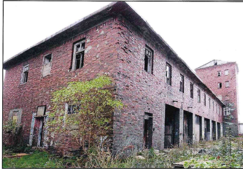
Вид двухэтажного объема и башни Памятника с северо-запада.
