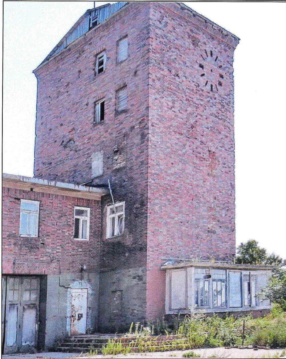
Северный и западный фасады башни.
