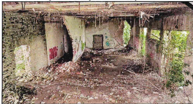
Вид помещений на первом этаже в двухэтажной восточной пристройке.
