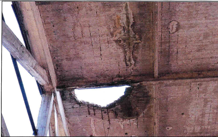
Фрагмент монолитной железобетонной конструкции крыши.
