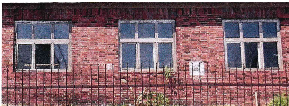
Вид оконных проемов западного фасада западной башни.
