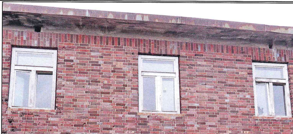
Вид карнизного свеса железобетонной крыши северной одноэтажной пристройки к основному объему ангара.
