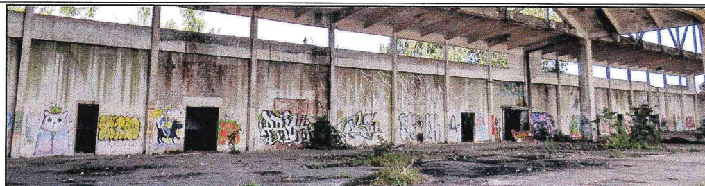
Вид смежной стены северной одноэтажной пристройки и основного объема.
