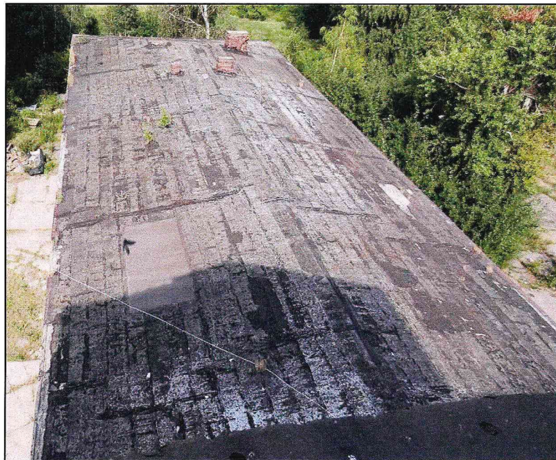
Вид с юга на крышу двухэтажного объема.
