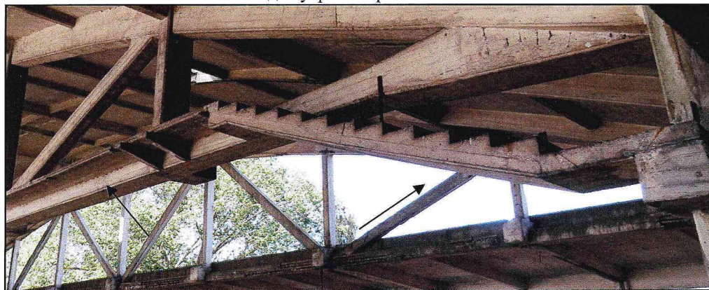
Фрагмент фермы арочного перекрытия ангара, горизонтальная площадка (проход) с лестничным маршем.
