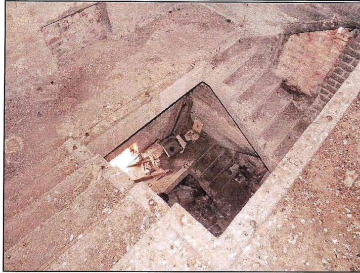
Вид междуэтажной лестницы в башне.
