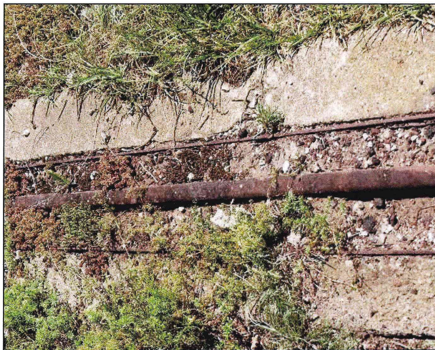
Фрагмент фасадной арки ангара и участка площадки с направляющими для перемещения створок ворот.
