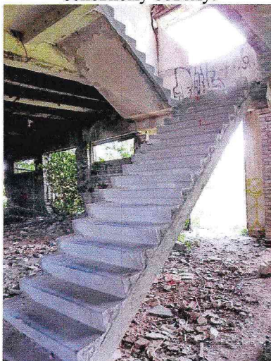
Вид междуэтажной лестницы в двухэтажной восточной пристройке к основному объему.
