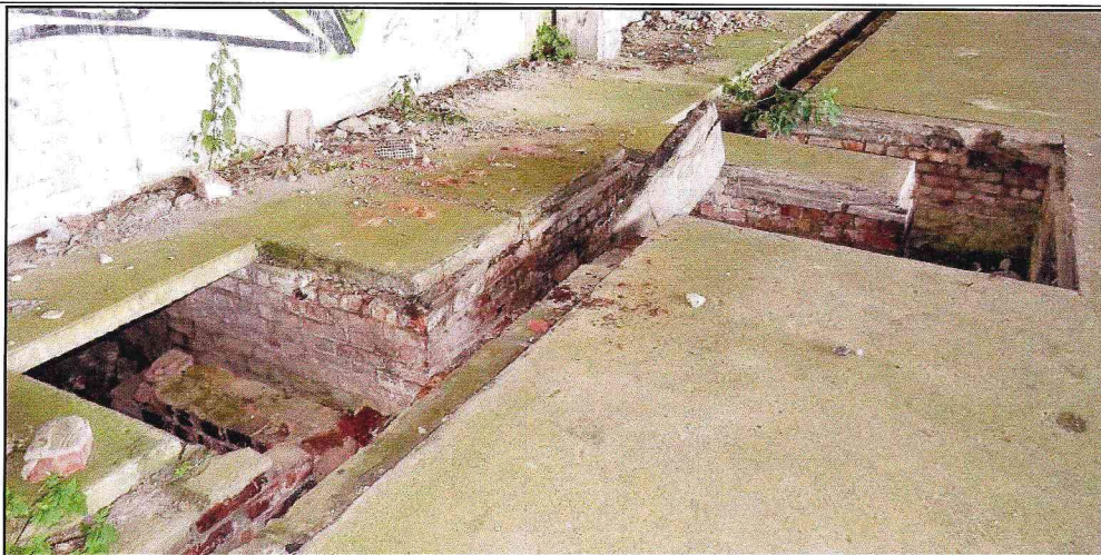
По периметру внутренней площадки ангара устроен прямоугольный в сечении желоб для размещения коммуникаций, желоб покрыт железобетонными плитами (частично утрачены).
