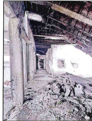
Междуэтажная лестница и аварийный второй этаж в двухэтажной восточной пристройке.
