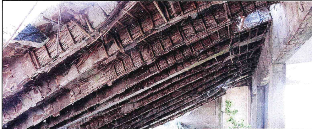
Вид перекрытия совмещенного с крышей в помещении второго этажа двухэтажной восточной пристройки к основному объему Памятника.
