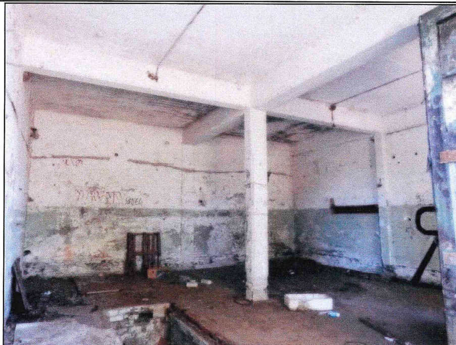
Вид внутри бокса, расположенного в двухэтажном объеме.
