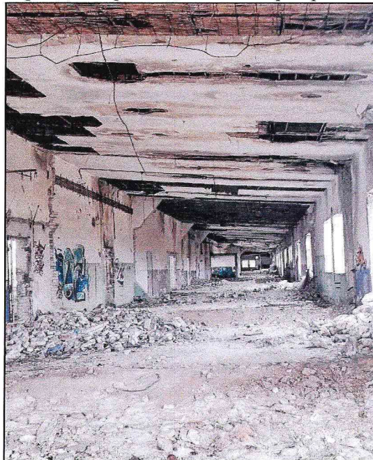
Вид помещений в северной одноэтажной пристройке, перегородки разобраны.
