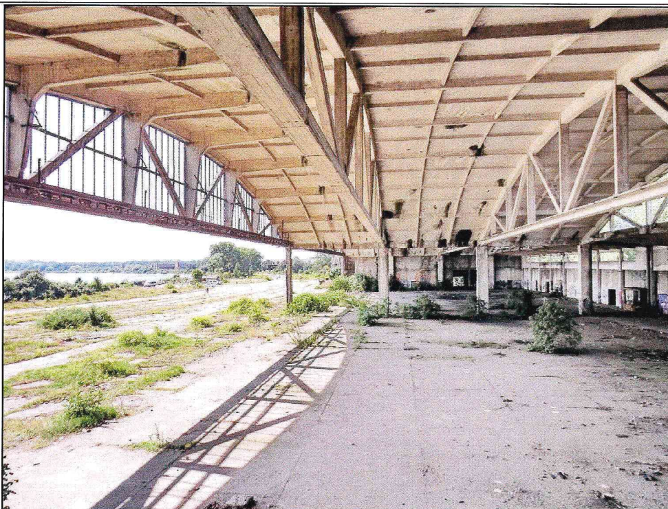
Вид внутри ангара с востока.
