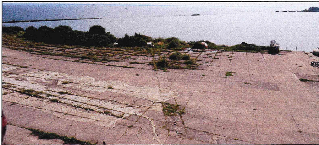
Бетонная площадка стоянки гидросамолетов, справа слип спуска самолетов на воду, на горизонте сохранившееся ограждение бухты.
