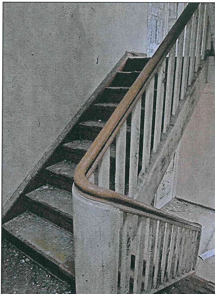
Фото 64. Второй этаж. Конструкции межэтажной лестницы, межэтажная площадка.
