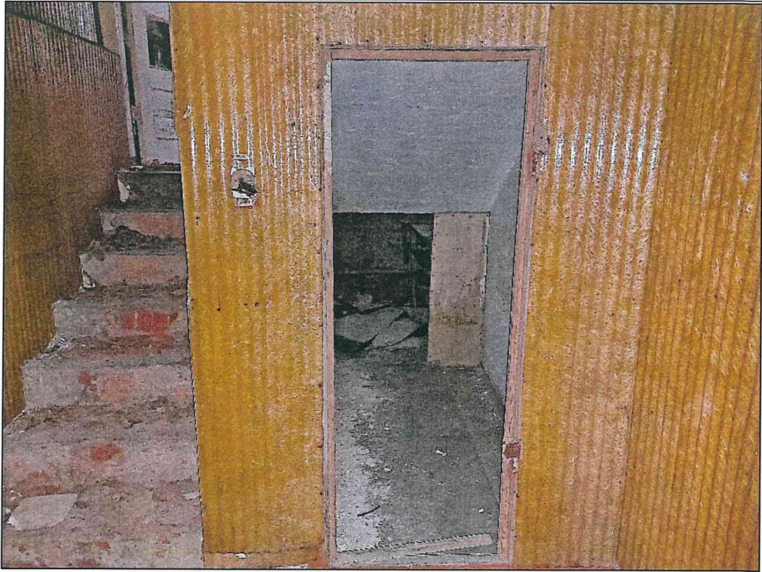
Фото 44. Подвал. Конструкции лестницы в подвал. Конструкции стен, перекрытий.
