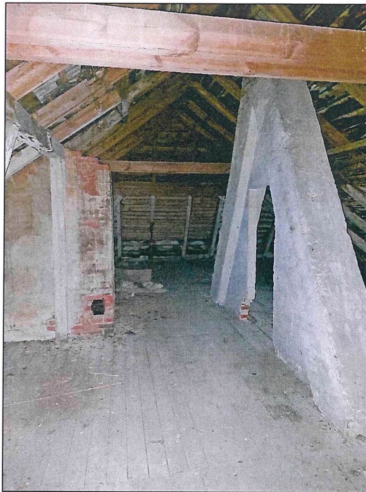
Фото 72. Чердак. Конструкции стропильной системы крыши. Конструкции вентиляционных, печных каналов.
