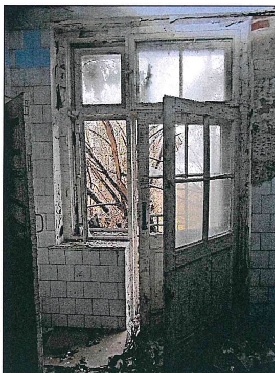
Фото 61. Второй этаж. Конструкции стен, перекрытий. Дверной проем на фасаде № 3 в уровне второго этажа – выход на балкон второго этажа. Конструкция оконных заполнений, дверного заполнения выхода на балкон.
