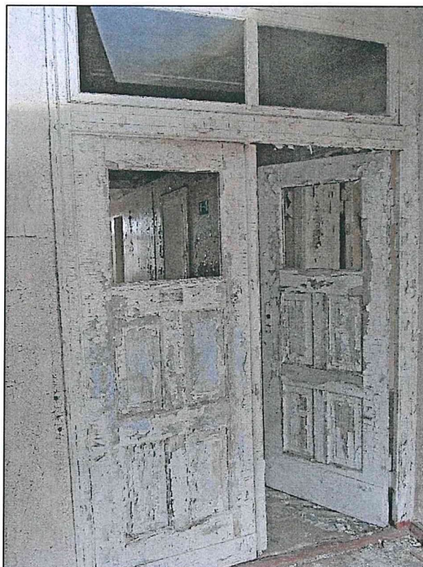
Фото 66. Третий этаж – мансарда. Конструкции стен, перекрытий. Дверной проем входа во внутренние помещения третьего этажа. Конструкция дверного заполнения.
