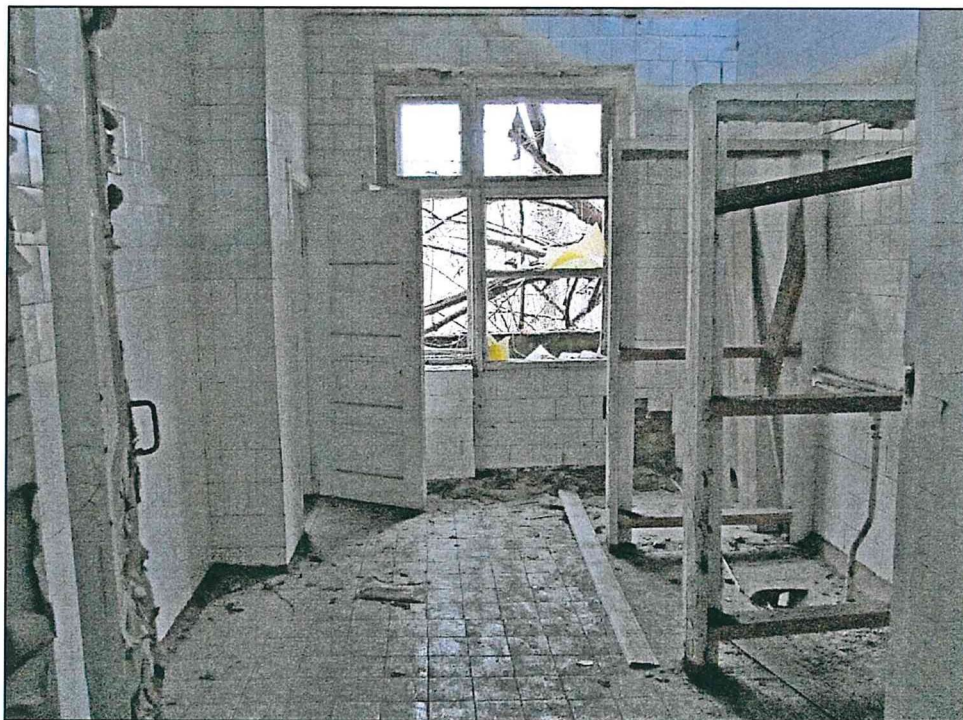
Фото 55. Первый этаж. Конструкции стен, перекрытий. Измененный выход на балкон.
