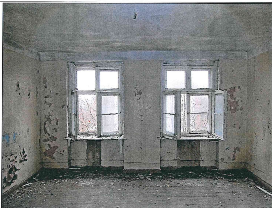
Фото 68. Третий этаж – мансарда. Конструкции стен, перекрытий.
