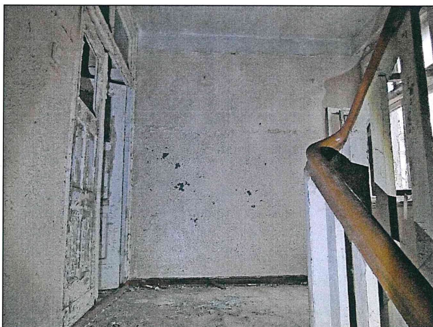
Фото 65. Третий этаж – мансарда. Конструкции стен, перекрытий. Конструкция дверного заполнения.
