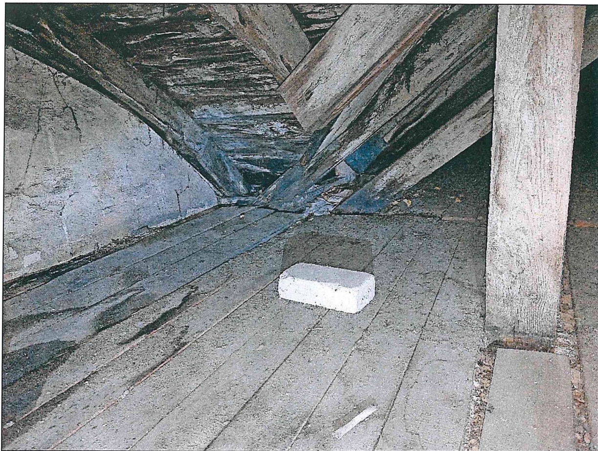
Фото 76. Чердак. Конструкции стропильной системы крыши.
