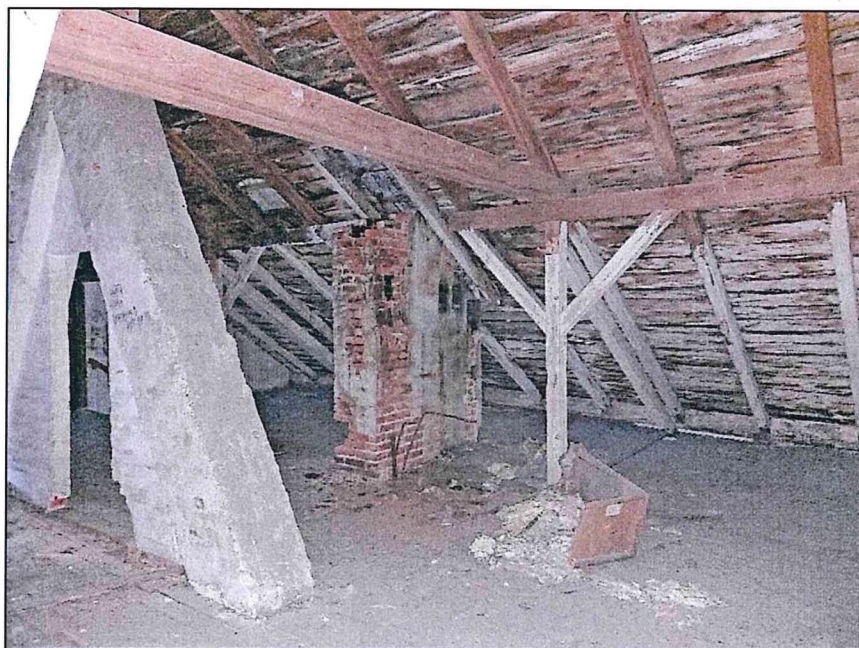
Фото 73. Чердак. Конструкции стропильной системы крыши. Конструкции вентиляционных, печных каналов.
