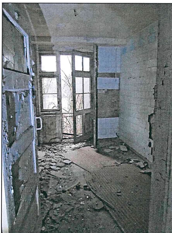
Фото 67 Третий этаж – мансарда. Конструкции стен, перекрытий. Дверной проем на фасаде № 3 в уровне третьего этажа – выход на балкон третьего этажа.
