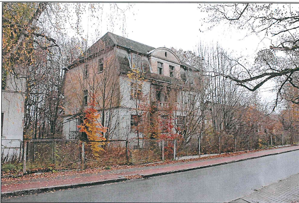
Фото 2. Общий вид. Проход.
