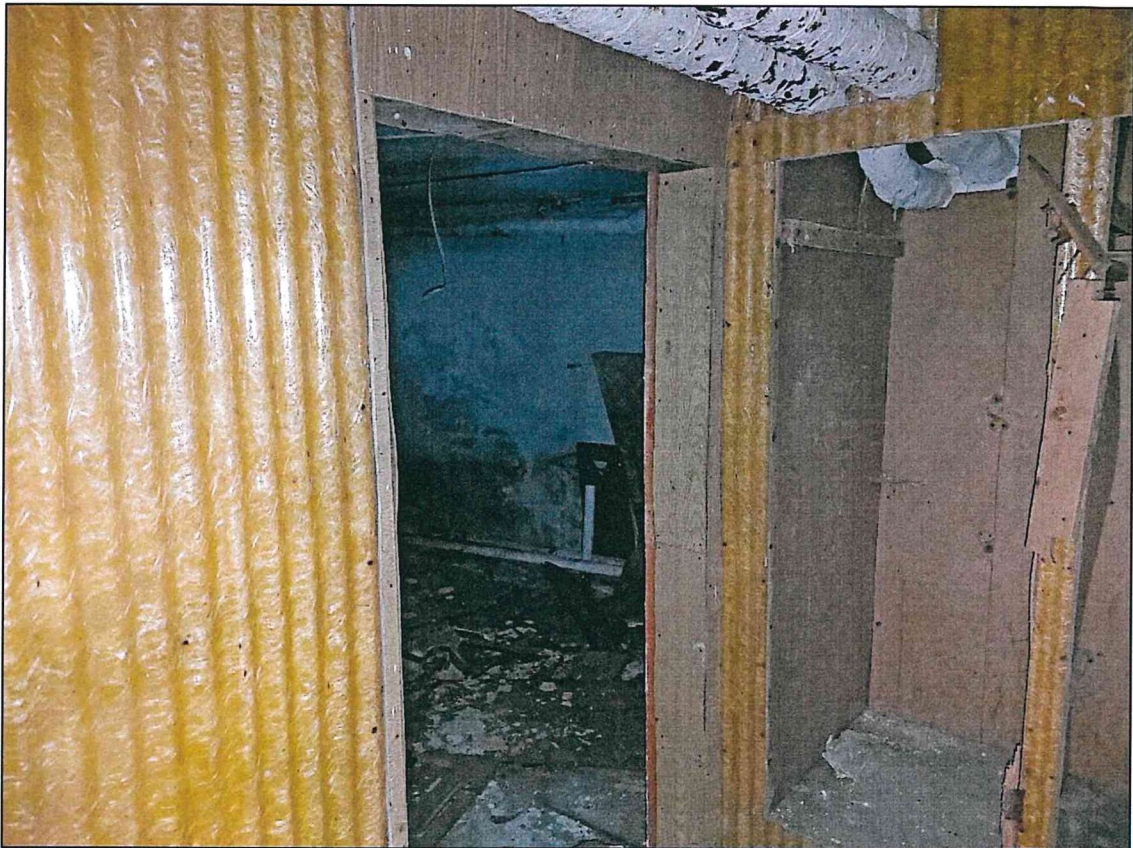
Фото 45. Подвал. Конструкции стен, перекрытий.
