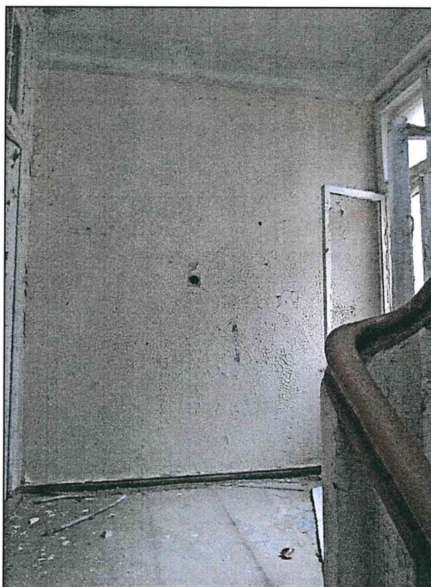
Фото 59. Второй этаж. Конструкции стен, перекрытий.
