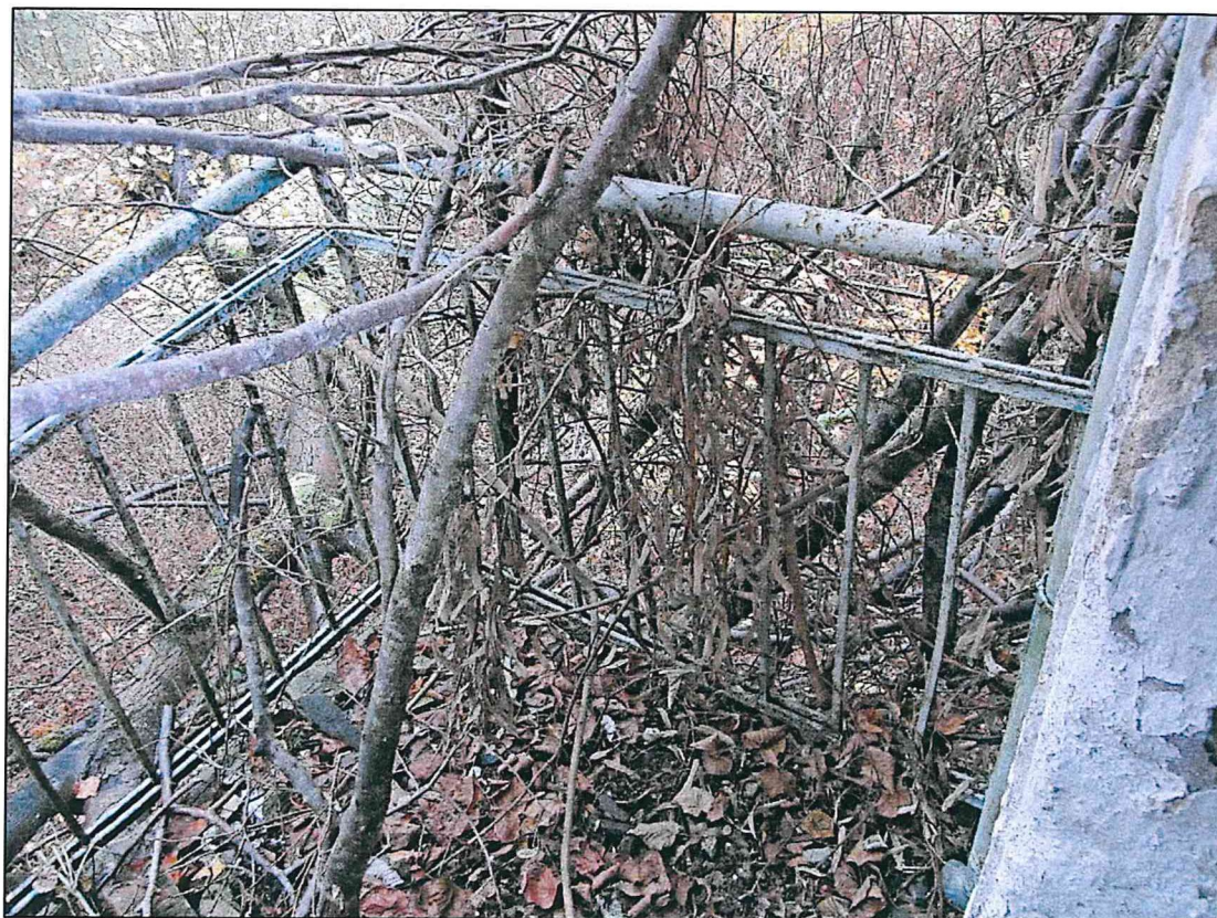
Фото 35. Фасад № 3. Фрагмент. Второй этаж. Балкон. Ограждение.
