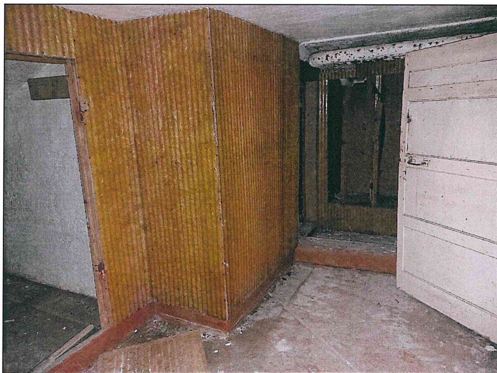
Фото 43. Подвал. Конструкции стен, перекрытий.
