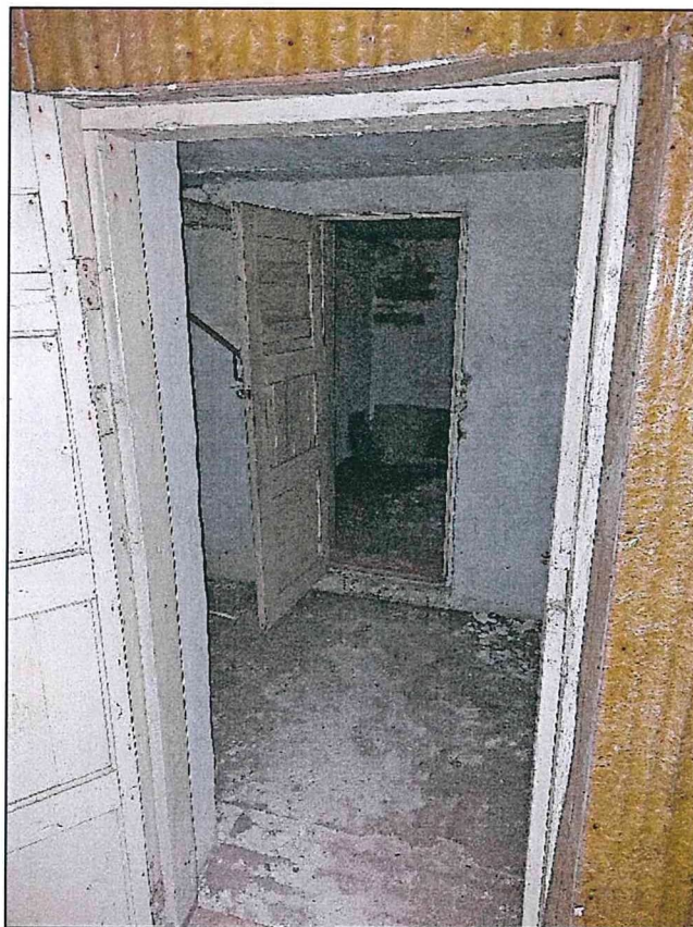
Фото 47. Подвал. Конструкции стен, перекрытий.
