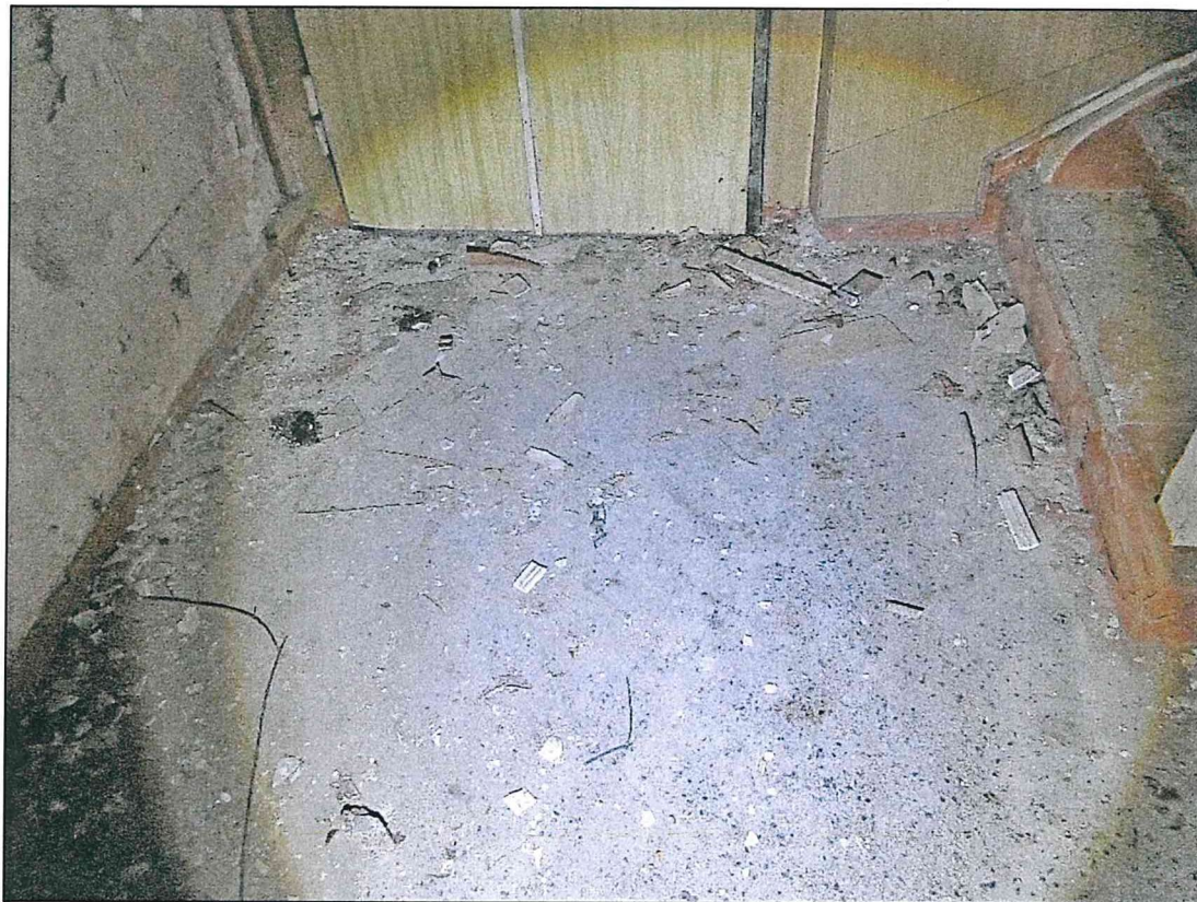
Фото 52. Первый этаж. Конструкции пола лестничной клетки.
