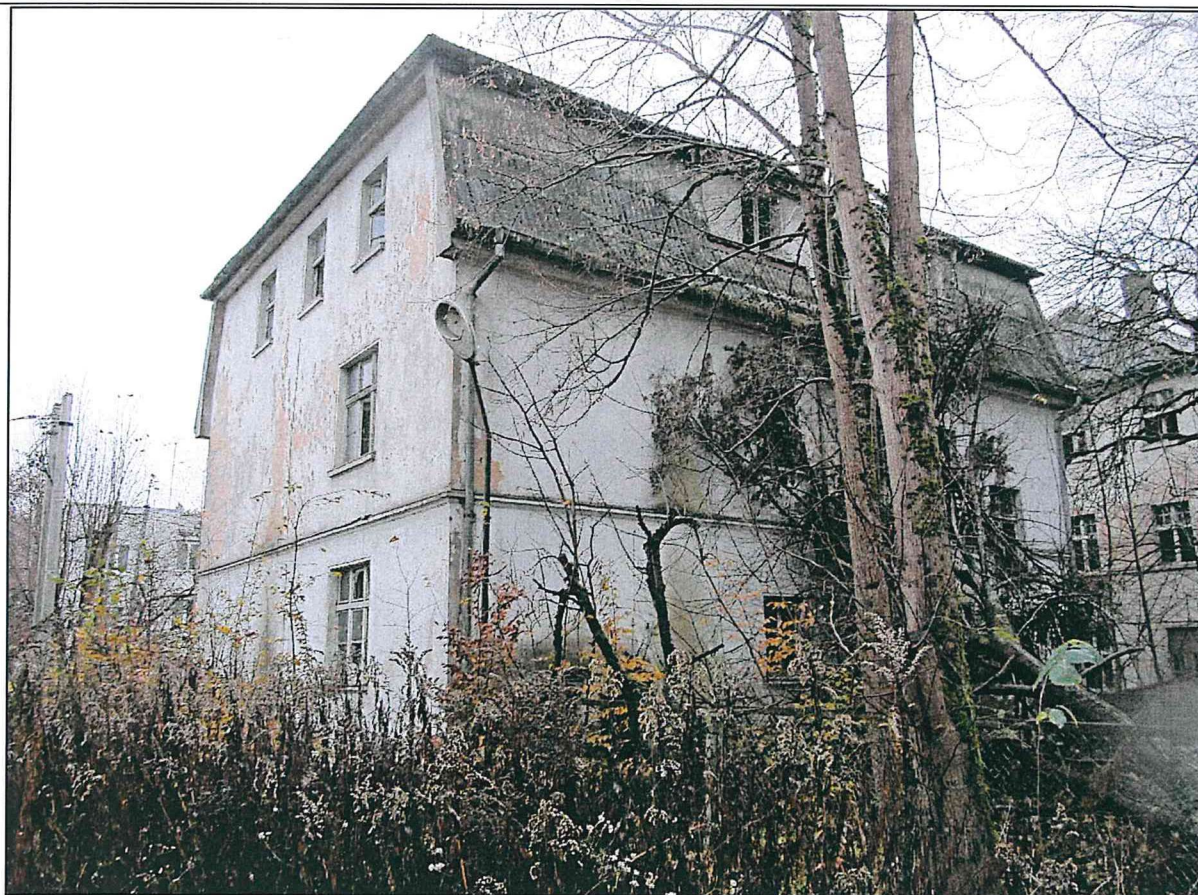
Фото 5. Общий вид. Внутренний двор.
