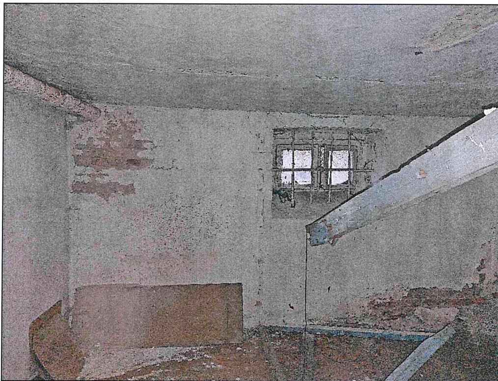
Фото 48. Подвал. Конструкции стен, перекрытий. Конструкции дверных проемов.
