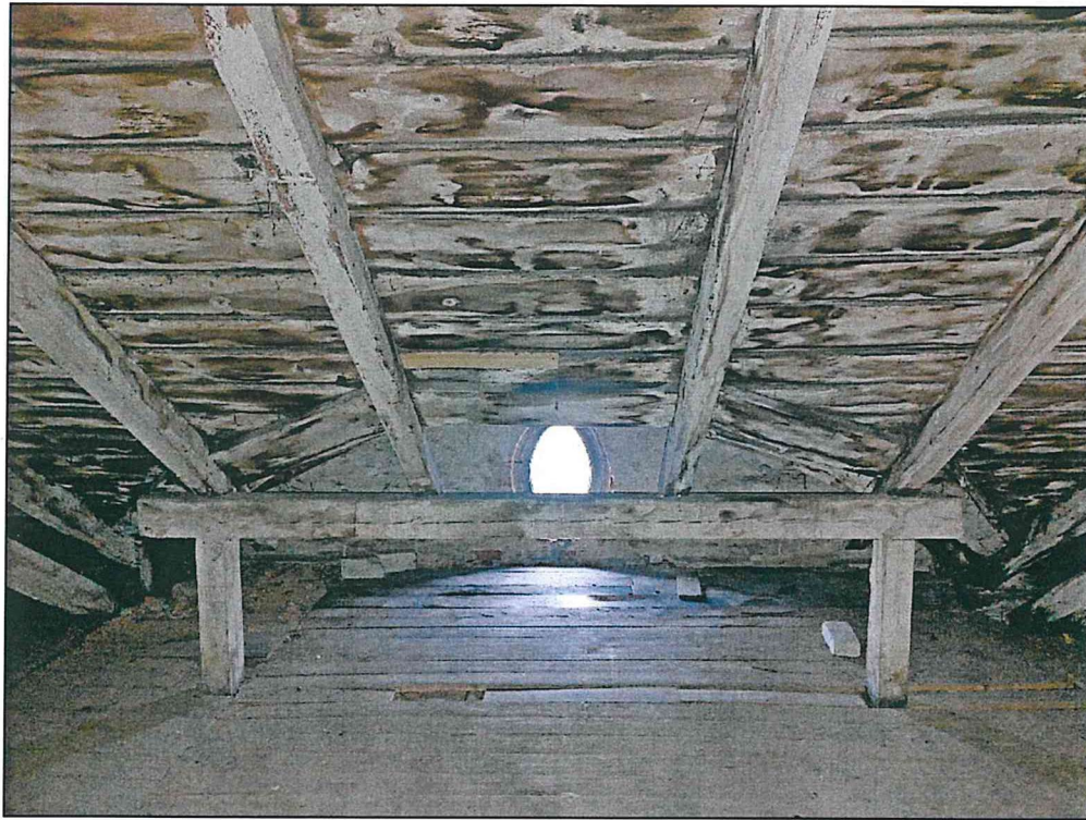
Фото 74. Чердак. Конструкции стропильной системы крыши. Конструкции оконных проемов.
