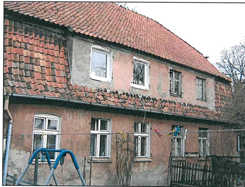
Вид с северо-запада, западный фасад Памятника.
