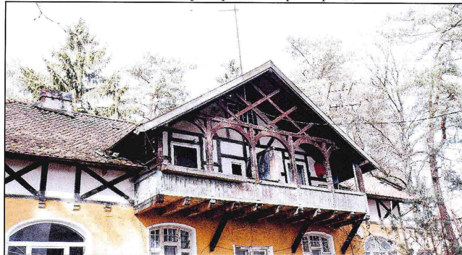
Фото 4. Вид фахверка на южном фасаде.
