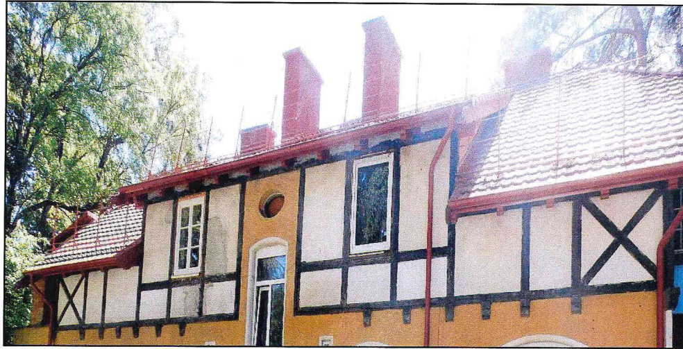
Фото 3. Вид фахверка на северном фасаде.
