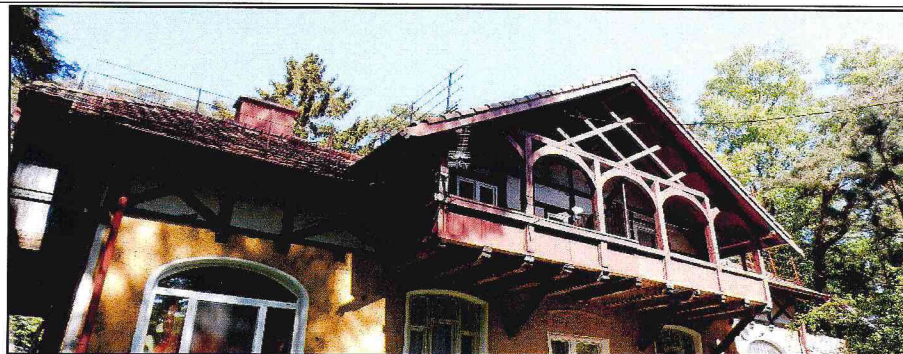
Фото 8. Южный скат крыши.
