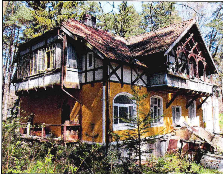
Фото 2. Вид Памятника с юго-запада. Южный и западный фасады.
