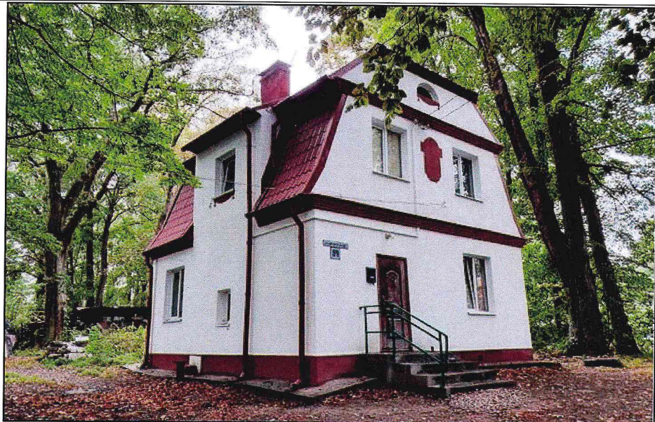
Фото 2. Общий вид Памятника с северо-востока. Северный главный и восточный боковой фасады Памятника.
