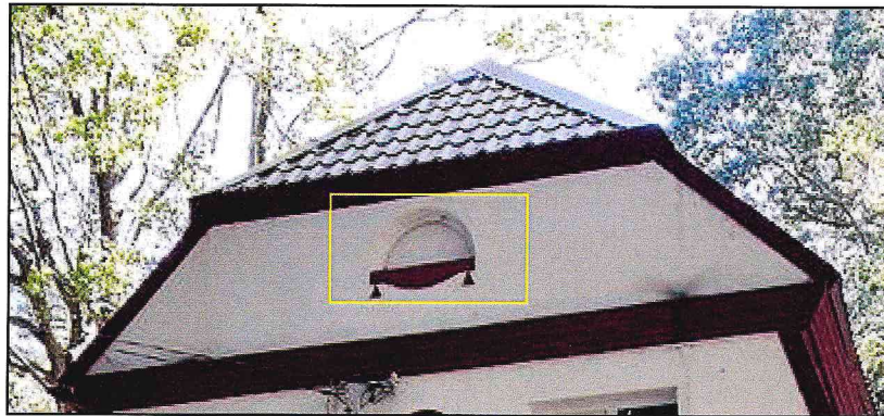
Фото 1. Декоративное оформление полуциркулярных слуховых оконных проемов. Вид с севера.
