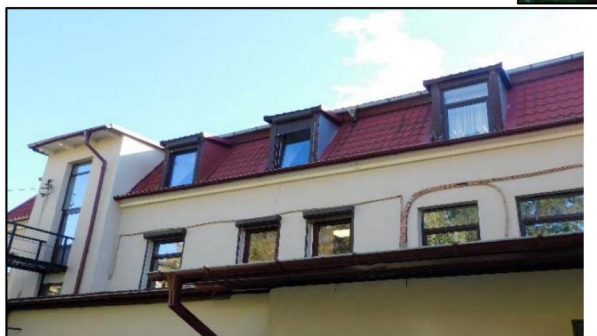
Фото 2. Вид с запада. Дворовый западный фасад Памятника.
