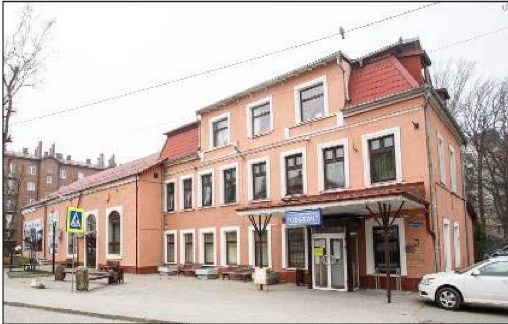
Фото 2 (2021г). Общий вид Памятника с северо-востока. Главный восточный фасад Памятника.
