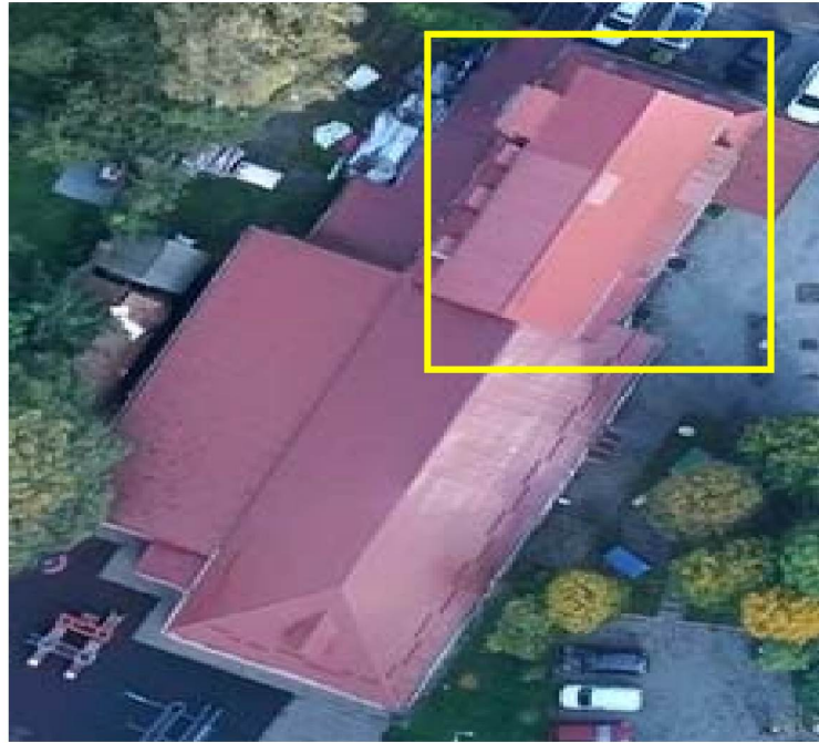
Фото 5. Крыша. Вид сверху.
