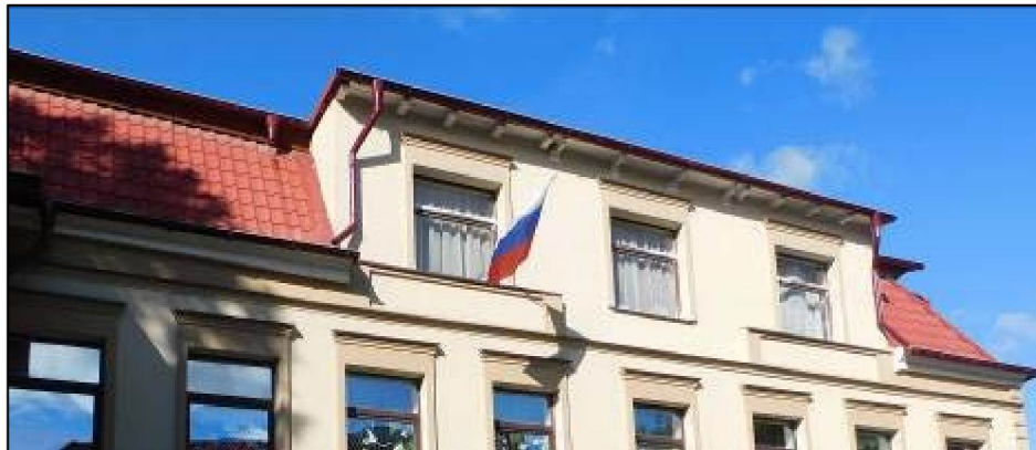
Фото 6. Восточный скат крыши.
