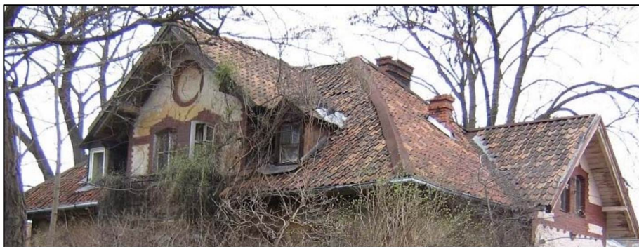
Фото 8. Южный и восточный скаты крыши.
