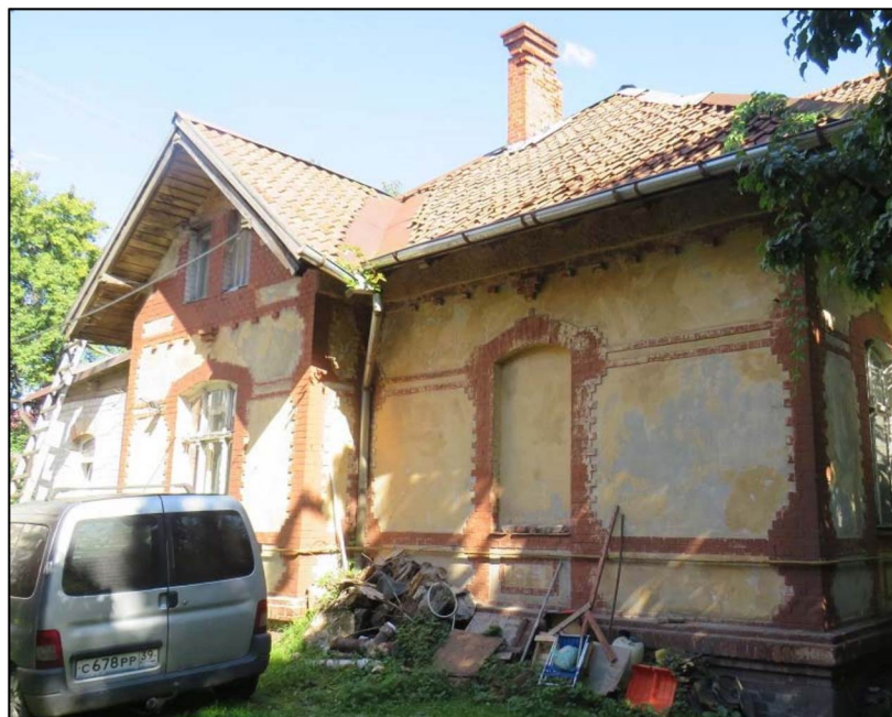
Фото 5. Западный боковой фасад.
