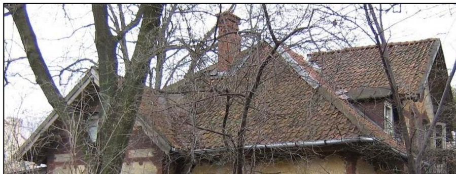
Фото 9. Западный и южный скаты крыши.
