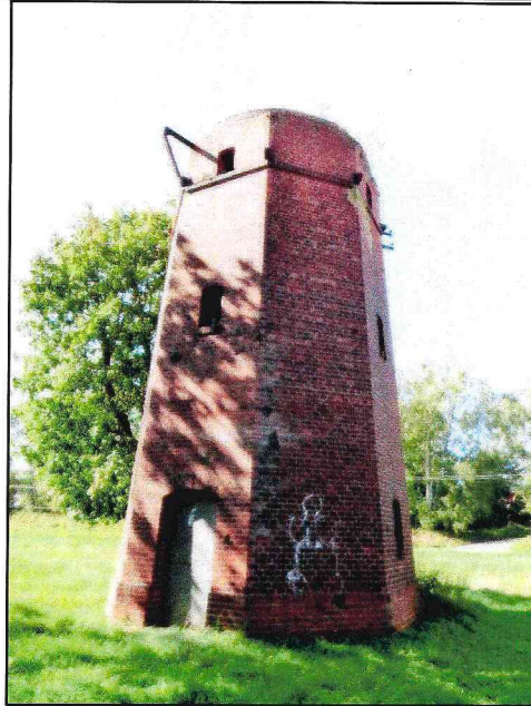
Фото 1. Вид с юга.
