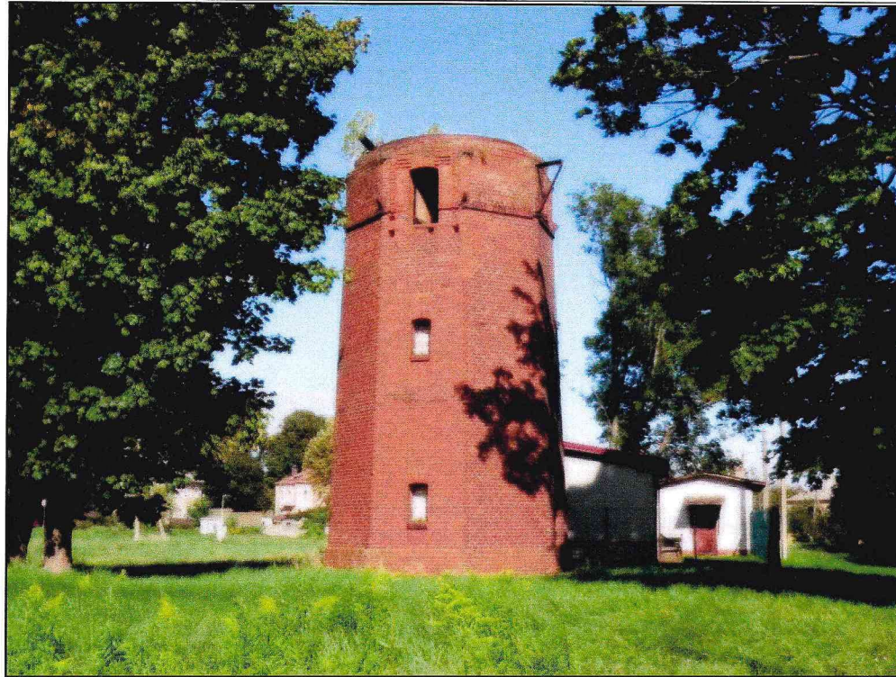
Фото 1. Общий вид водонапорной башни с юга.
