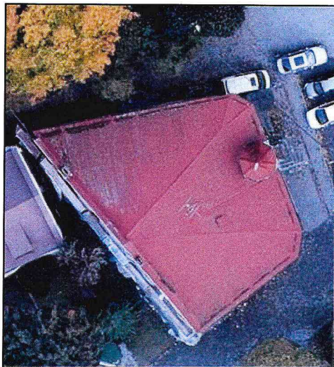
Фото 10. Вид крыши Памятника.
