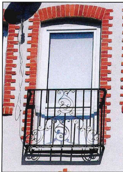
Фото 5. Вход на балкон.
