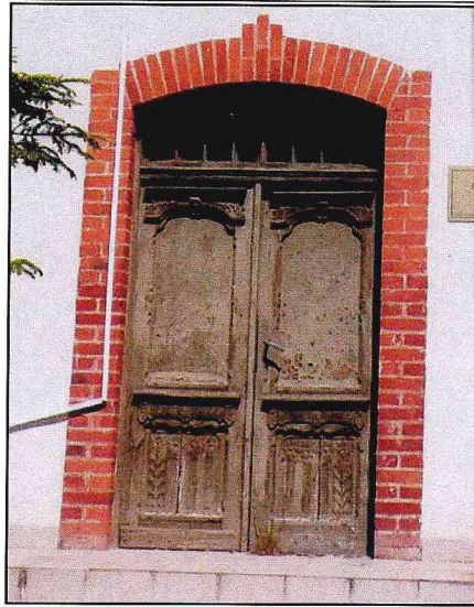
Фото 7. Дверной проем главного входа.
