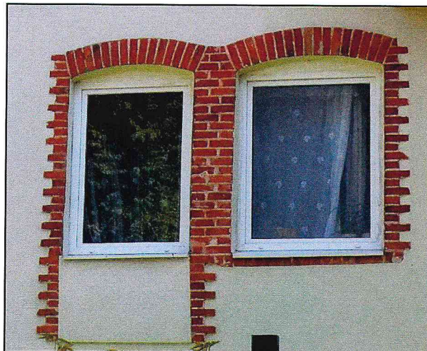
Фото 2. Сдвоенные оконные проемы.
