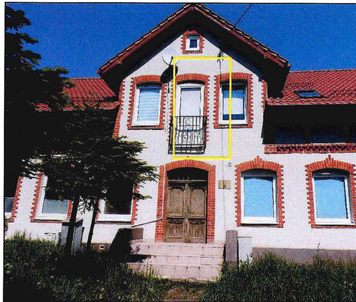
Фото 8. Дверной проем входа на балкон.
