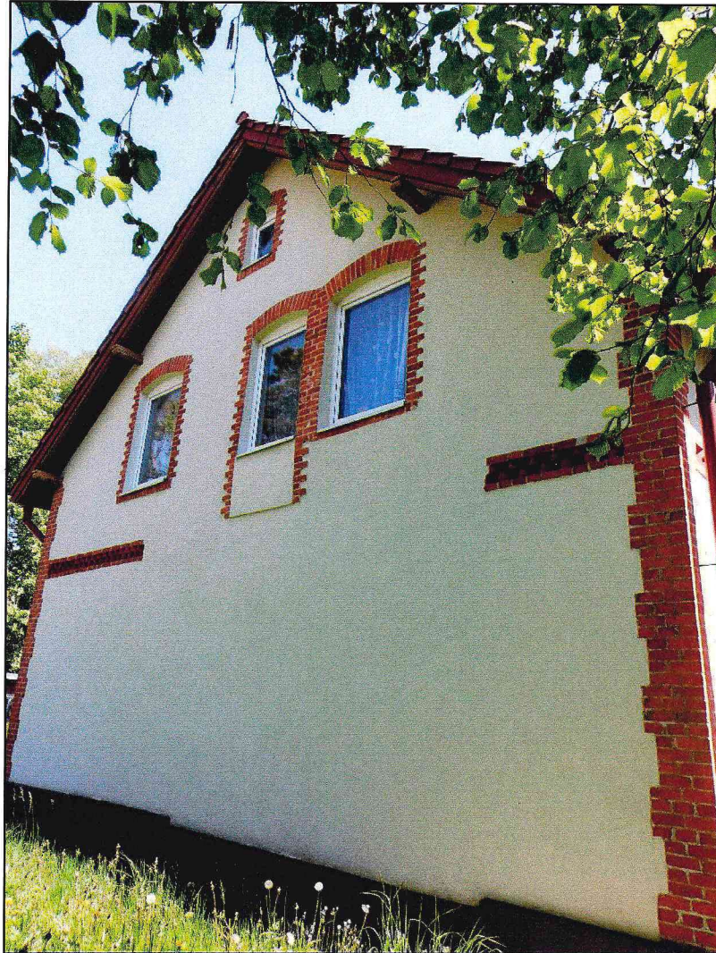
Фото 4. Вид с юго-запада. Западный боковой фасад Памятника.
