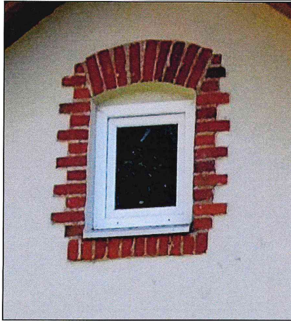
Фото 4. Маломерные оконные проемы на западном и восточном боковых фасадах; на поперечном фронтоне мансарды.
