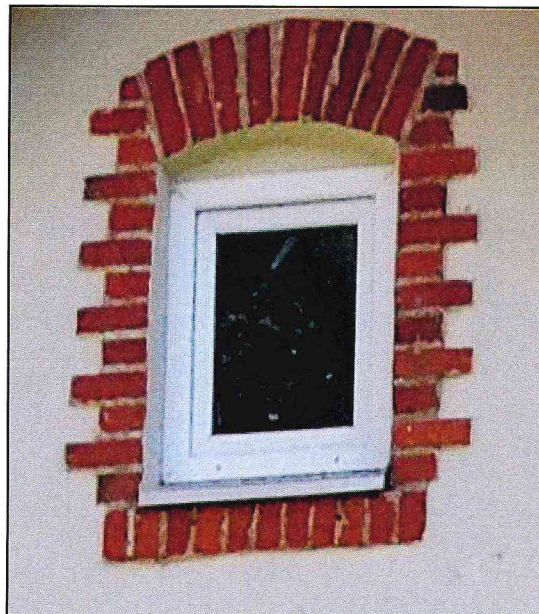
Фото 3. Маломерные оконные проемы.
