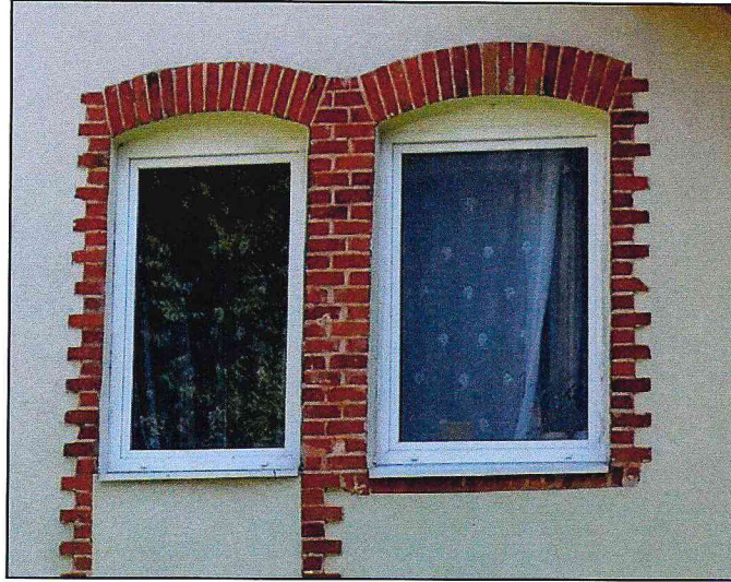
Фото 3. Сдвоенные оконные проемы.
