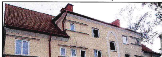
Фото 10. Северный скат крыши.
