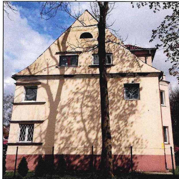
Фото 4. Западный фасад памятника.
