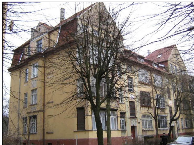
Фото 2. Общий вид Памятника с северо-запада. Фасады № 1, № 2.
