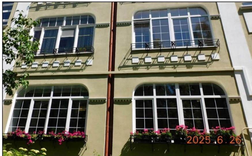
Фото 12. Проемы лоджий в центральной части фасада № 1.
