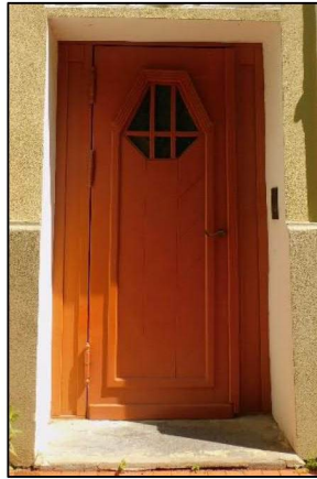
Фото 17. Вид дверного проема входа на фасаде № 1.
