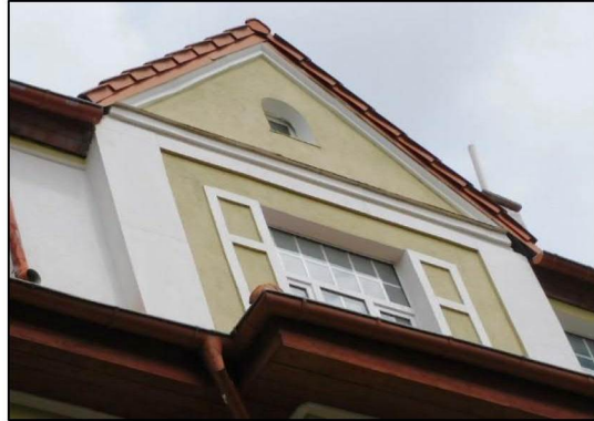
Фото 4. Вид фронтонов на фасадах в № 2, № 8.
