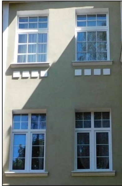
Фото 2. Оконные проемы на фасаде № 1.
