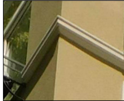
Фото 13. Элемент углового декора ризалитов в уровне третьего этажа.
