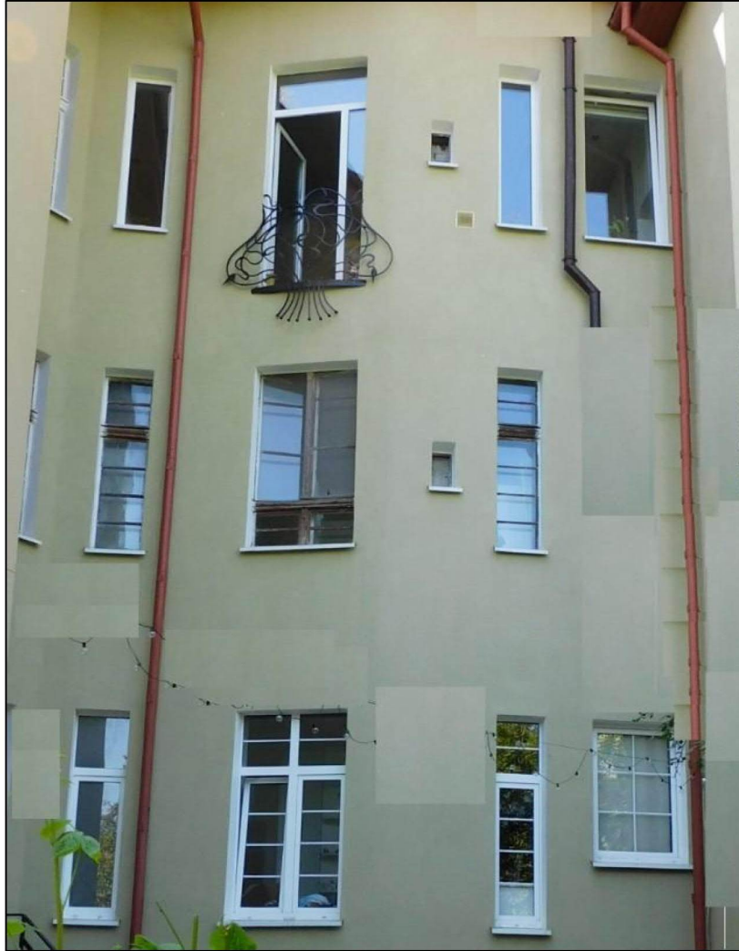
Фото 9. Оконные проемы на фасадах № 3, № 7.
