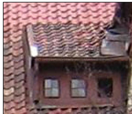
Фото 20. Вид выносного слухового окна мансарды на западном скате крыши.
