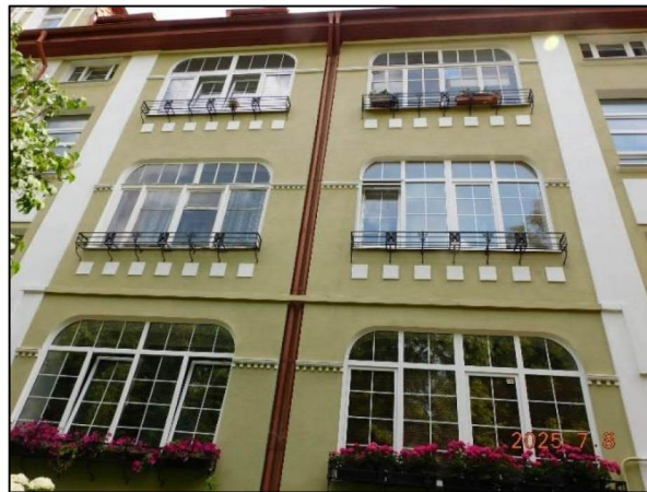
Фото 7. Общий вид подоконных панелей на фасаде № 1.
