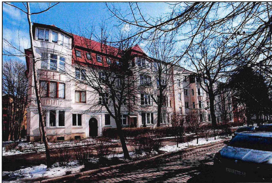
Фото 4. Фасад № 1. Вид с северо-запада.
