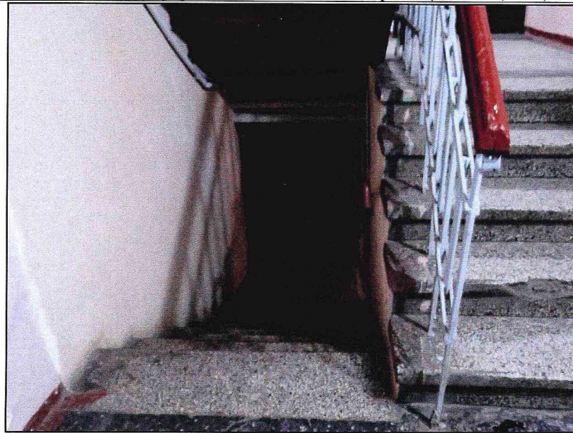
Фото 6. Вид входных лестниц.
