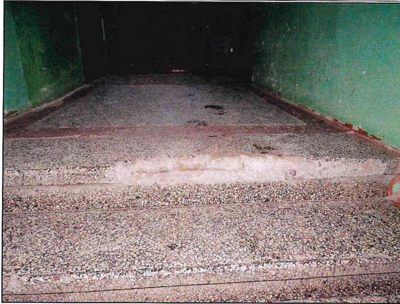
Фото 7. Вид напольного покрытия площадок.
