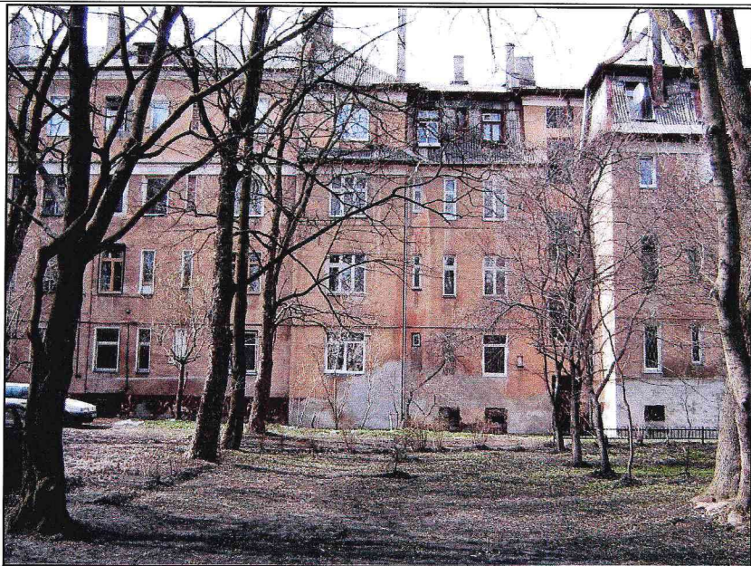
Фото 6. (2006 г.) Фасад № 3, фрагмент, северное боковое крыло.
