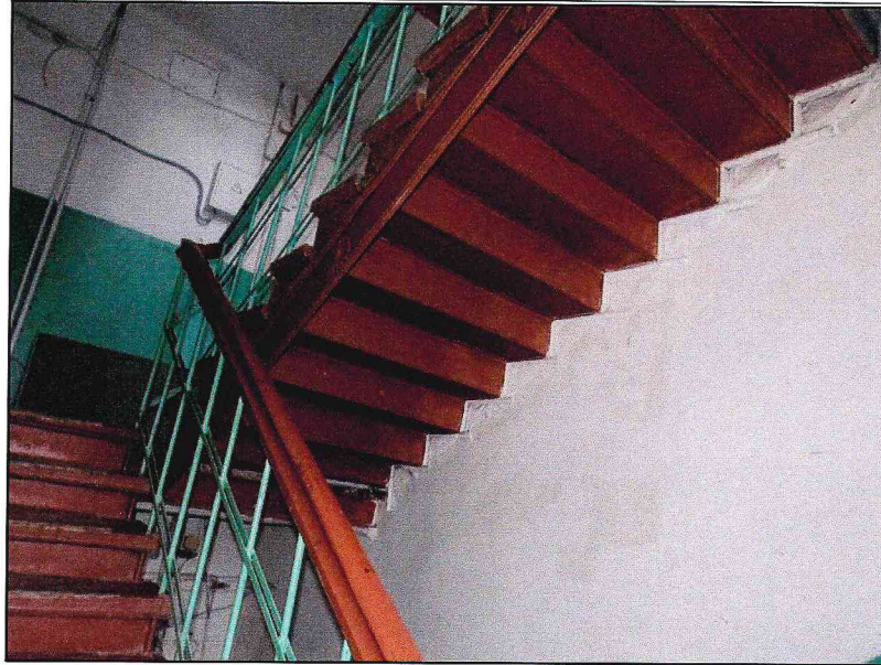
Фото 4. Конструкция межэтажной лестницы (дом № 6).
