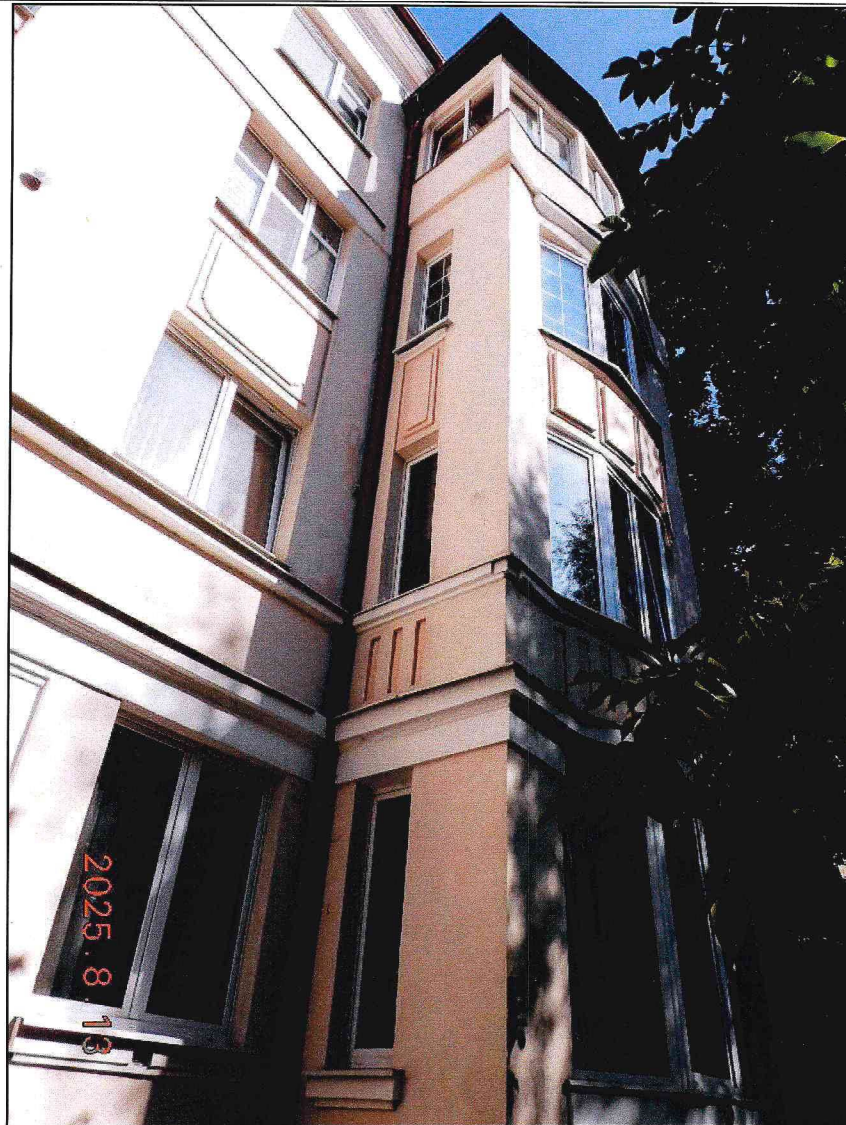
Фото 11. Вид лоджий в боковых северном и южном ризалитах.
