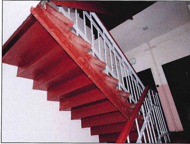
Фото 2. Конструкция межэтажной лестницы (дом № 8).
