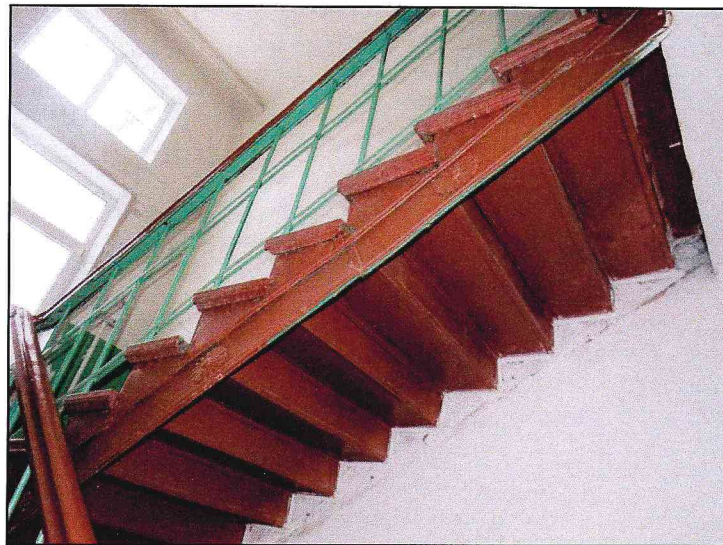
Фото 4а. Перила и поручни межэтажной лестницы (дом № 6).
