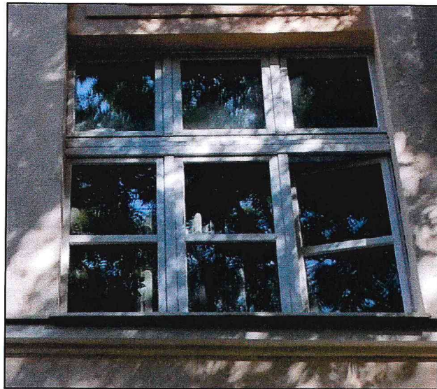
Фото 2. Оконные проемы на фасаде № 1.
