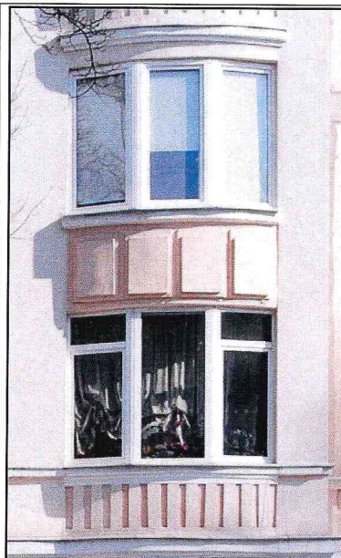
Фото 10. Оконные проемы на фронтальных стенах лоджий центральных ризалитов.
