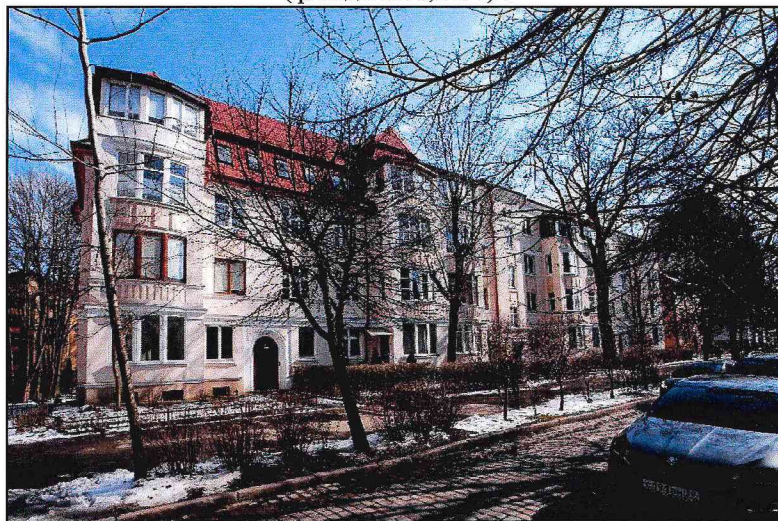
Фото 2. Общий вид Памятника с северо-запада. Западный главный фасад (фасад № 1).
