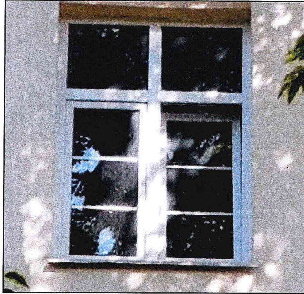
Фото 5. Оконные проемы лестничной клетки на фасаде № 1.
