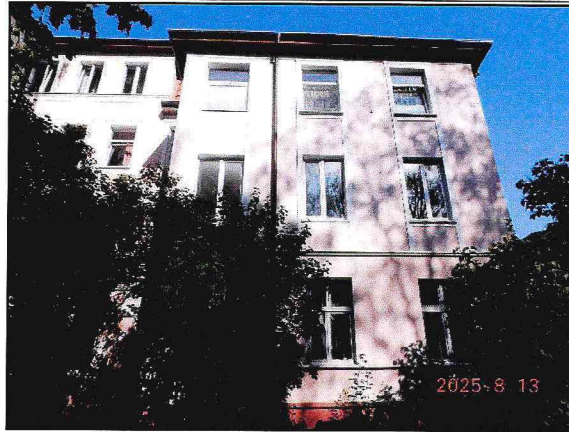
Фото 5. Фасад № 1. Вид бокового южного ризалита с запада.
