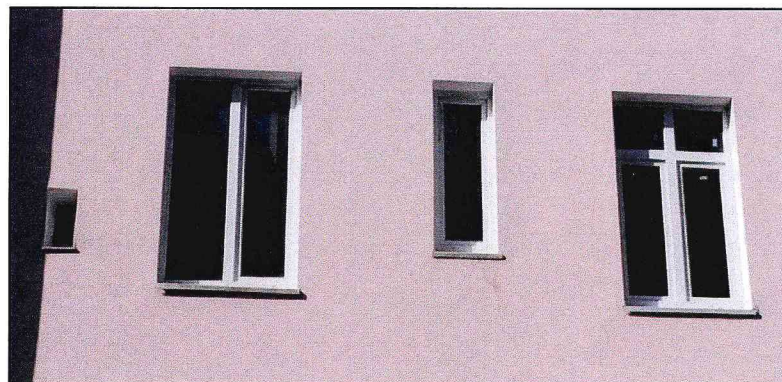
Фото 4. Оконные проемы на фасадах № 2, № 3 № 4.
