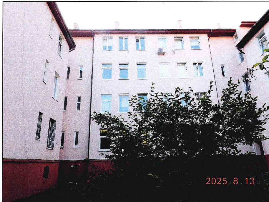
Фото 8. Фасад № 3. Центральная часть фасада, южное и северное боковые крылья.
