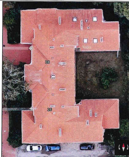
Фото 8. Вид крыши сверху.
