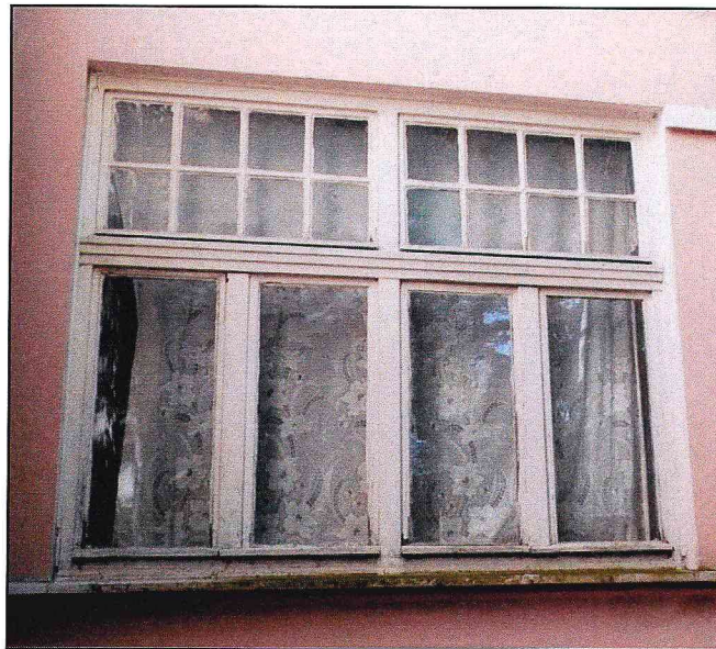
Фото 3. Вид оконных проемов на фасаде № 1.
