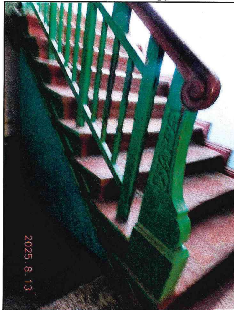
Фото 4. Стартовый столб межэтажной лестницы.
