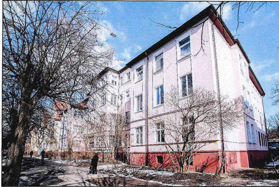
Фото 1. Общий вид Памятника с юго-запада. Западный и южный фасады (фасады № 1, № 4).
