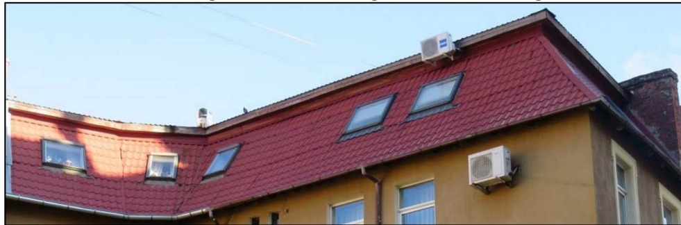
Фото 7. Южные скаты крыши.
