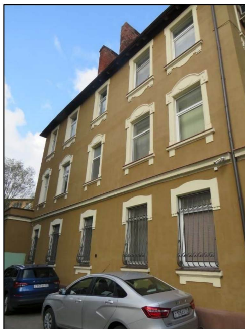
Фото 6. Восточный фасад основного объема.
