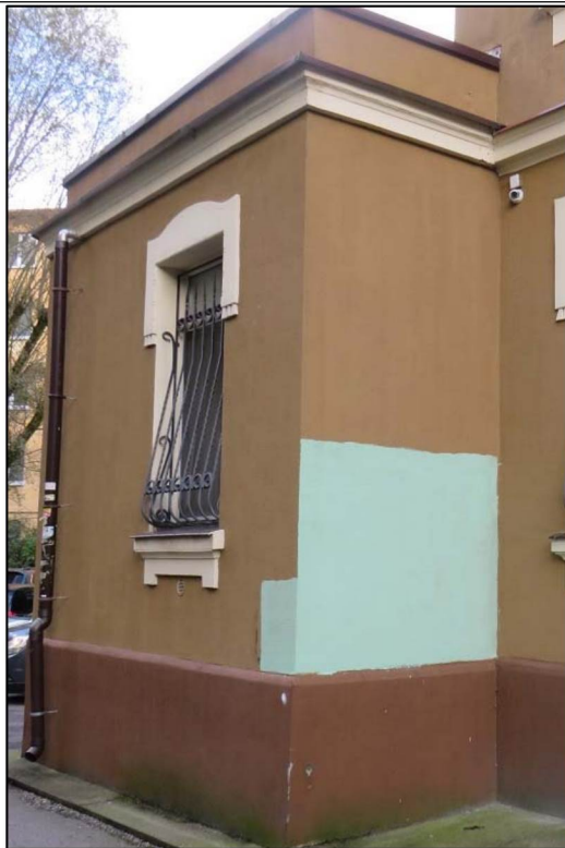
Фото 9. Одноэтажный объем, юго-восточный и северо-восточный фасады.
