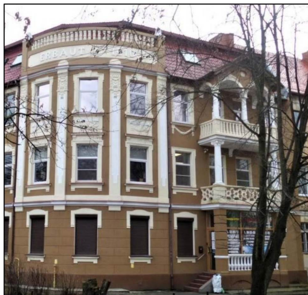
Фото 4. Северо-западный фасад основного объема
