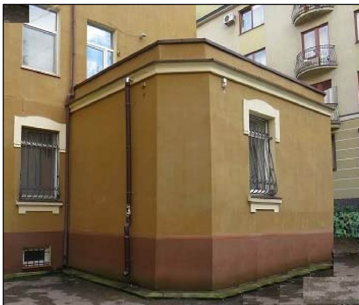
Фото 8. Одноэтажный объем, северо-западный и юго-западный фасад.
