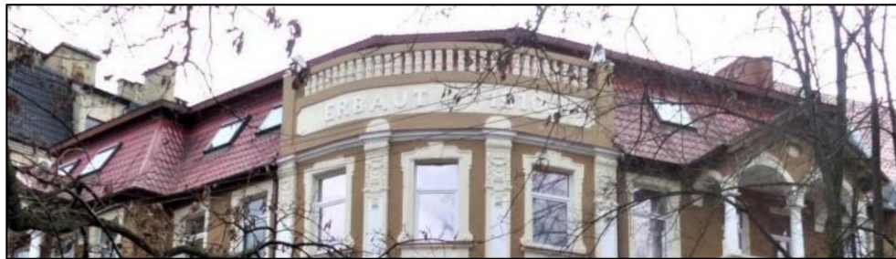
Фото 6. Северо-восточный и северо-западный скаты крыши.
