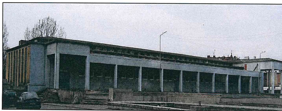
Фото 2006 года. Вид с юго-запада, южный фасад Памятника.
