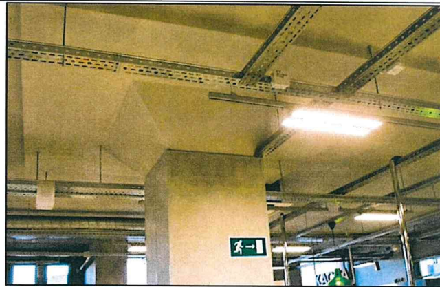
Фото 2. Перекрытие цокольного этажа.
