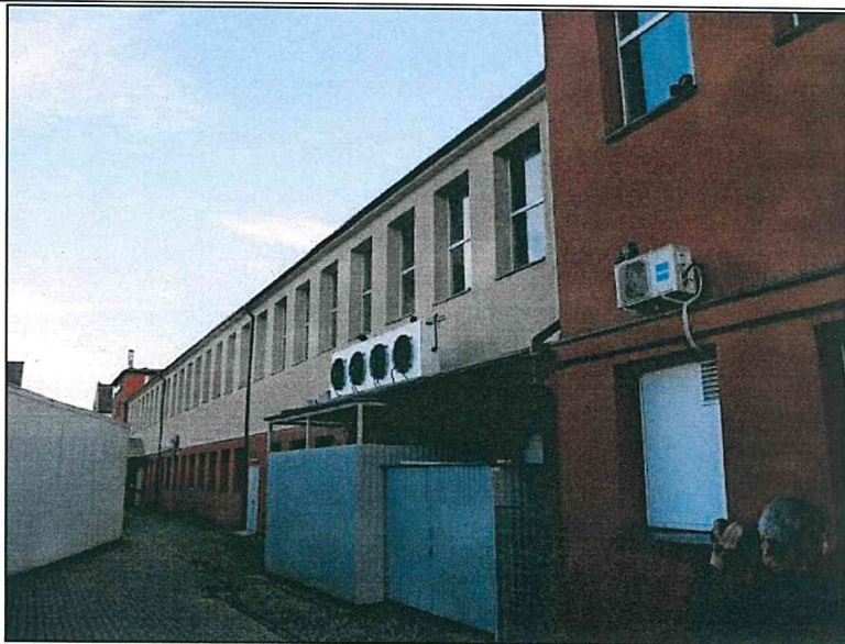
Вид с северо-запада, северный фасад Памятника.
