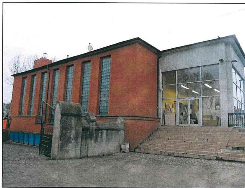
Вид с запада, западный фасад Памятника.
