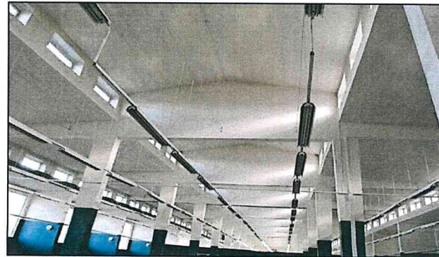
Фото 3. Перекрытие первого этажа.
