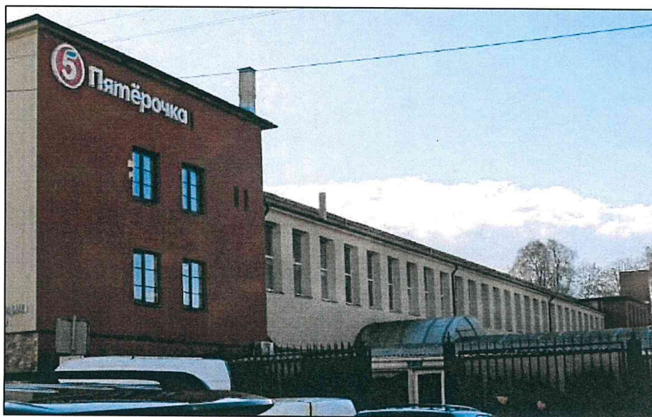
Вид с северо-востока, северный фасад Памятника.
