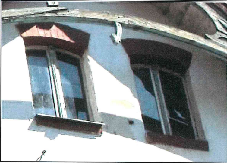
Фото 17. Заполнение оконных проемов.
