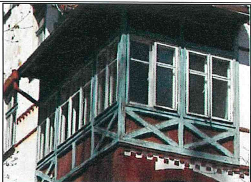
Фото 19. Оконные проемы лоджий в уровне третьего этажа.
