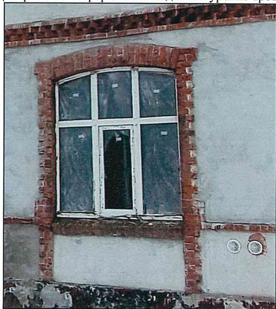
Фото 29. Декоративное оформление оконных проемов первого этажа.
