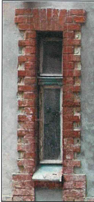
Фото 15. Заполнение оконных проемов первого, второго, третьего этажей.
