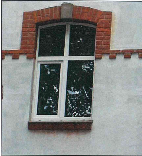
Фото 30. Декоративное оформление оконных проемов второго этажа.
