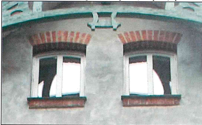
Фото 16. Оконные проемы в уровне чердака на юго-западном и северо-восточном фасадах.
