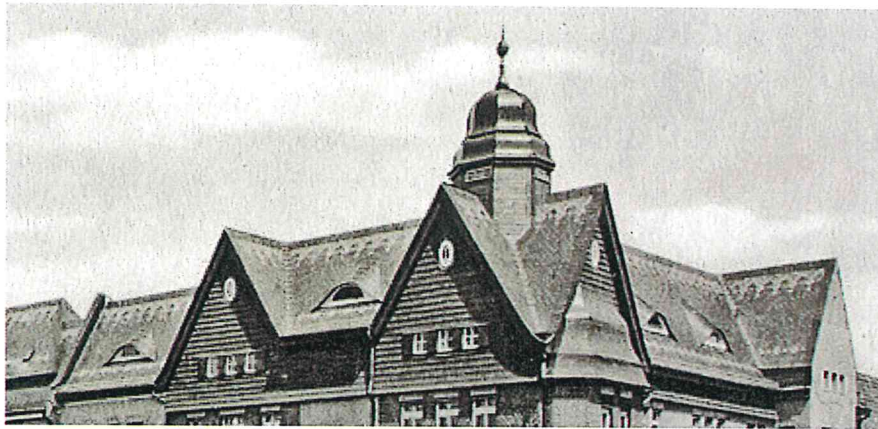
Фото 34. Вид крыши с юга. .
