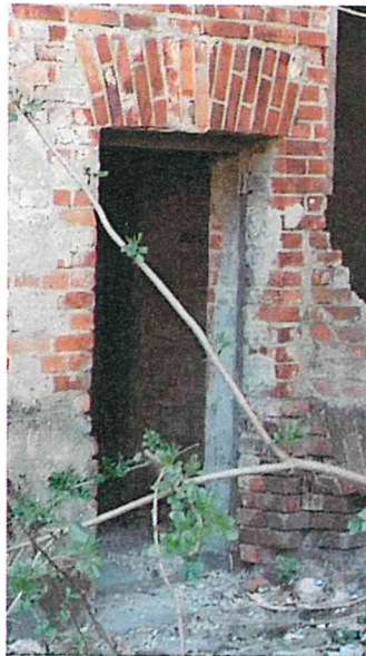
Фото 27. Дверной проем дворового входа на северо-восточном дворовом фасаде.
