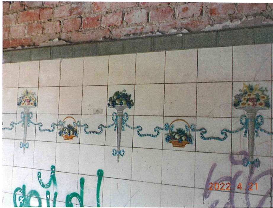
Фото 3. Облицовка стен площадки первого этажа.
