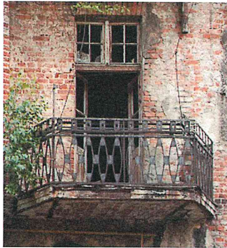
Фото 29. Дверные проемы выходов на балконы на юго-западном и юго-восточном уличных фасадах.
