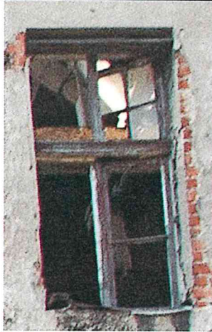
Фото 16. Оконные проемы на юго-западном и юго-восточном уличных фасадах.
