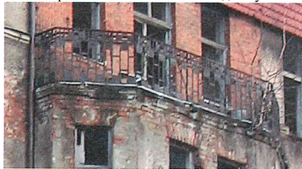
Фото 31. Открытый балкон, завершающий эркер на юго-западном уличном фасаде.
