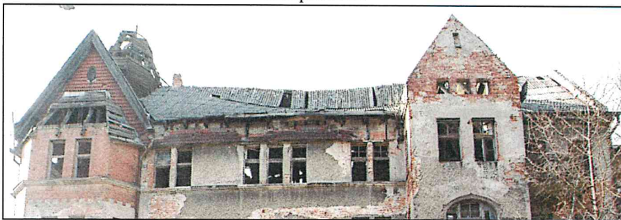
Фото 12. Фрагмент верхней части юго-восточного уличного фасада. Характер отделки фасадной поверхности.
