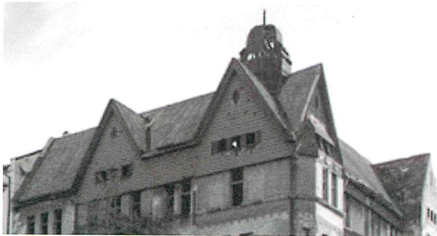
Фото 35. Вид крыши с юга. .
