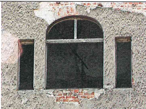
Фото 14. Тройной оконный проем третьего этажа на юго-восточном уличном фасаде.
