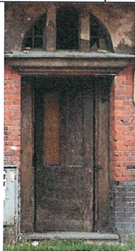
Фото 26. Дверной проем главного входа на юго-западном уличном фасаде.
