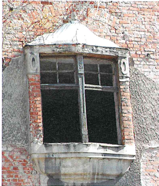
Фото 16. Парный оконный проем (эркерное окно) на юго-западном уличном фасаде.
