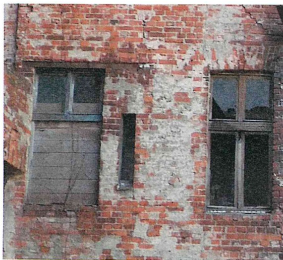
Фото 23. Оконные проемы на северо-западном дворовом фасаде.
