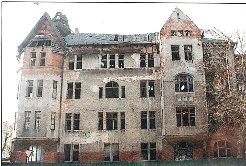
Фото 11. Юго-восточный уличный фасад. Характер отделки фасадной поверхности.
