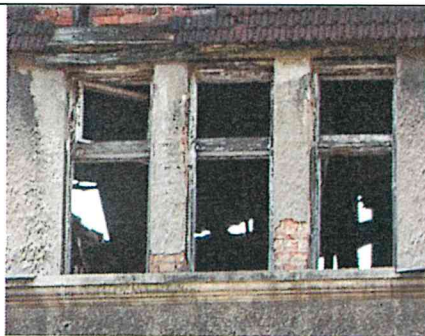
Фото 15. Тройной оконный проем четвертого этажа на юго-восточном уличном фасаде; юго-западном уличном фасаде.
