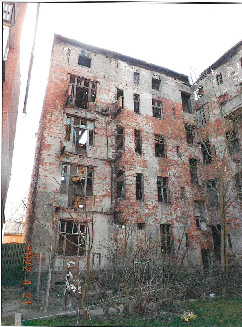
Фото 6. Северо-восточный дворовый фасад Памятника.
