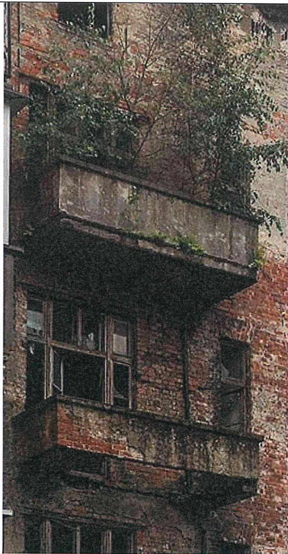
Фото 33. Открытые балконы на северо-восточном и северо-западном дворовых фасадах.
