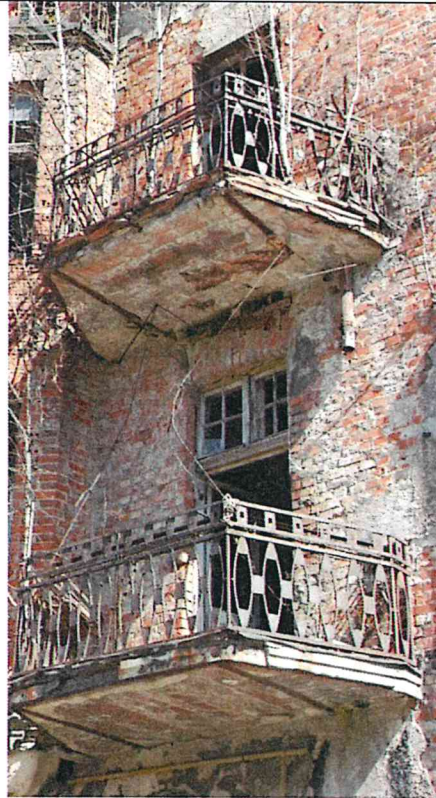
Фото 30. Ось открытых балконов на юго-западном уличном фасаде.
