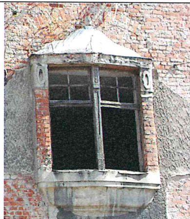
Фото 18. Парный оконный проем (эркерное окно) на юго-западном уличном фасаде.
