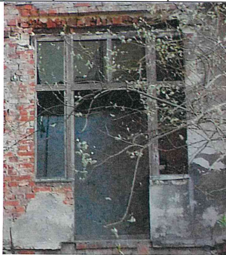
Фото 28. Совмещенный оконно-дверной балконный блок на северо-восточном и северо-западном дворовых фасадах.
