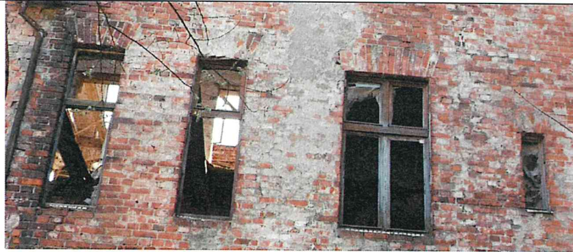
Фото 24. Оконные проемы на северо-восточном дворе фасаде.
