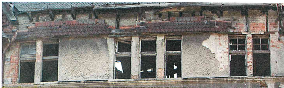
Фото 9а. Фрагмент стены юго-восточного уличного фасада в уровне мансарды.
