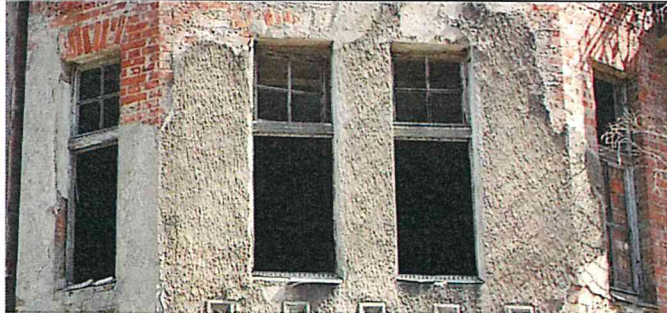
Фото 17. Оконные проемы эркера на юго-западном уличном фасаде.
