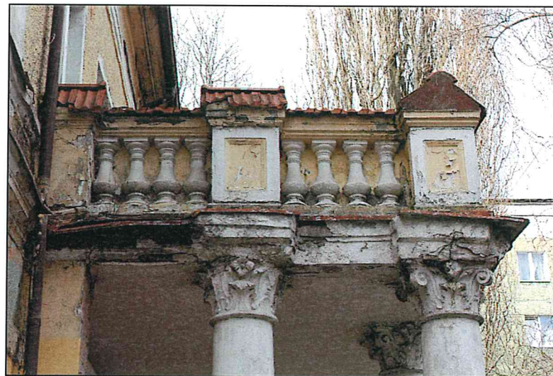
Рисунок 66. Южный фасад объекта. Фрагмент.
