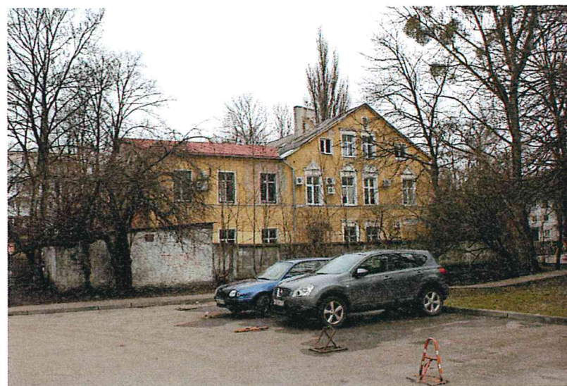
Рисунок 11. Южный дворовый фасад объекта.
