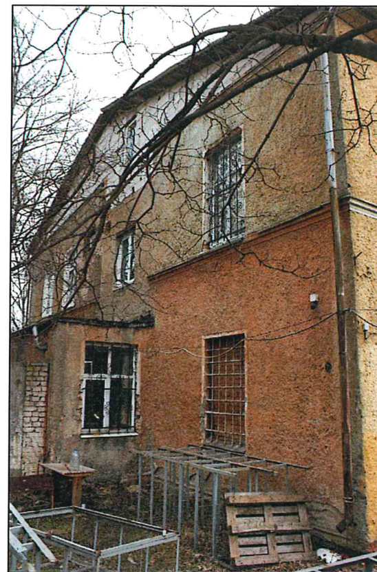
Рисунок 50. Западный фасад объекта. Фрагмент.
