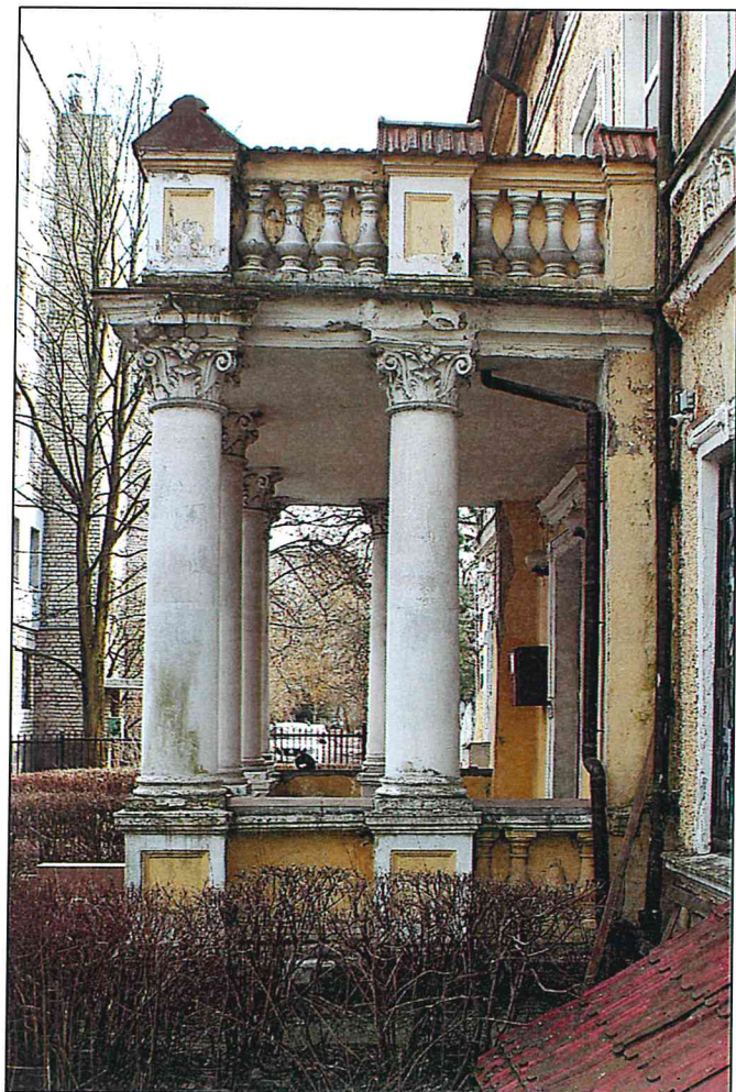
Рисунок 30. Северный фасад объекта. Фрагмент.
