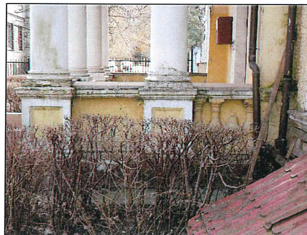
Рисунок 32. Северный фасад объекта. Фрагмент.
