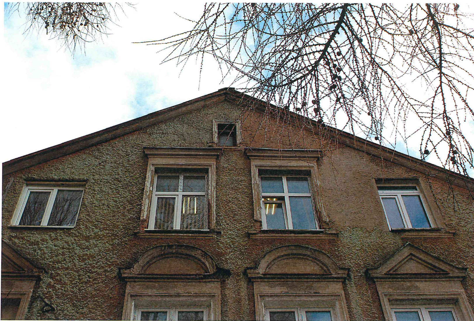
Рисунок 46. Северный фасад объекта. Фрагмент.
