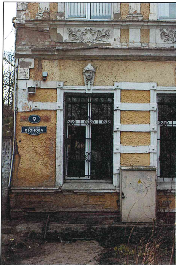
Рисунок 16. Восточный фасад объекта. Фрагмент.
