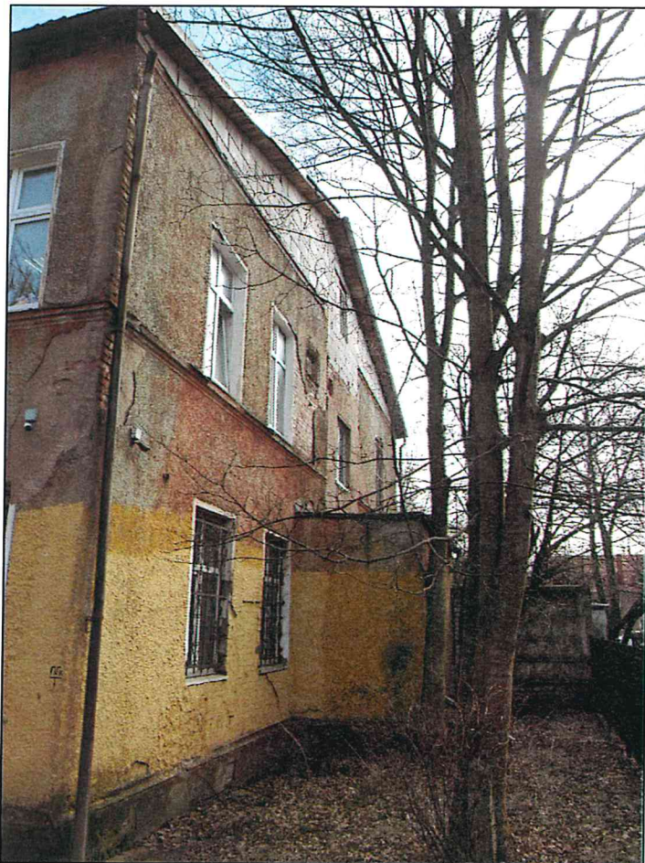
Рисунок 52. Западный фасад объекта. Фрагмент.
