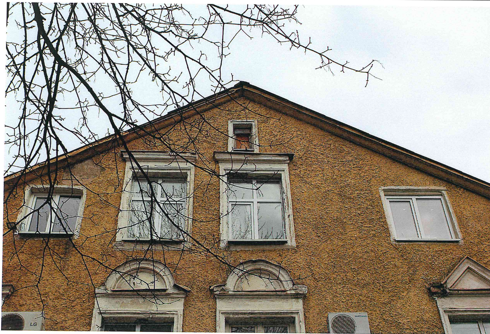
Рисунок 73. Южный фасад объекта. Фрагмент.
