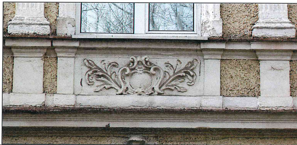
Рисунок 25. Восточный фасад объекта. Фрагмент.
