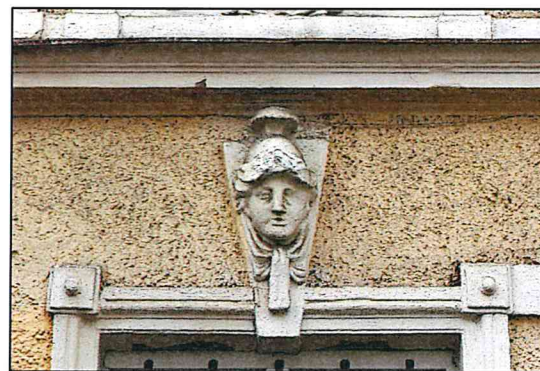
Рисунок 18. Восточный фасад объекта. Фрагмент.
