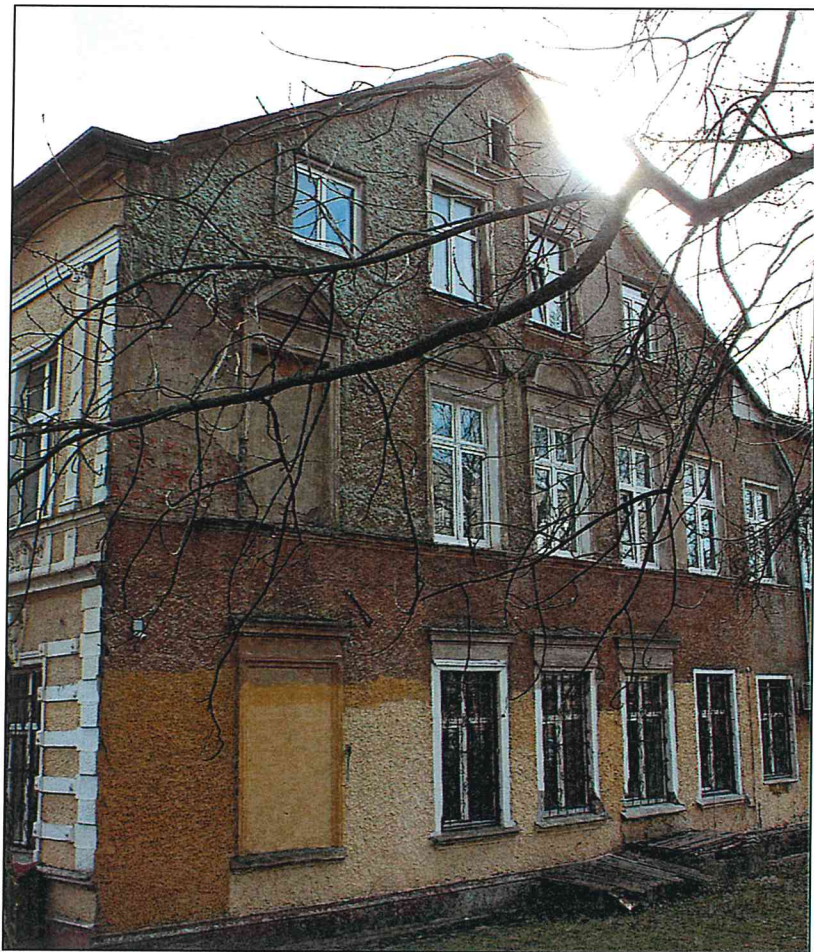
Рисунок 27. Северный фасад объекта. Фрагмент.
