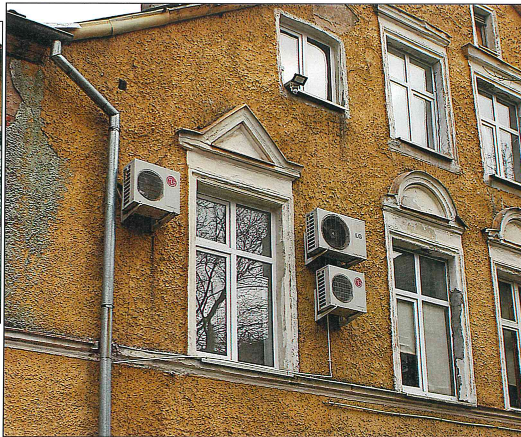
Рисунок 70. Южный фасад объекта. Фрагмент.
