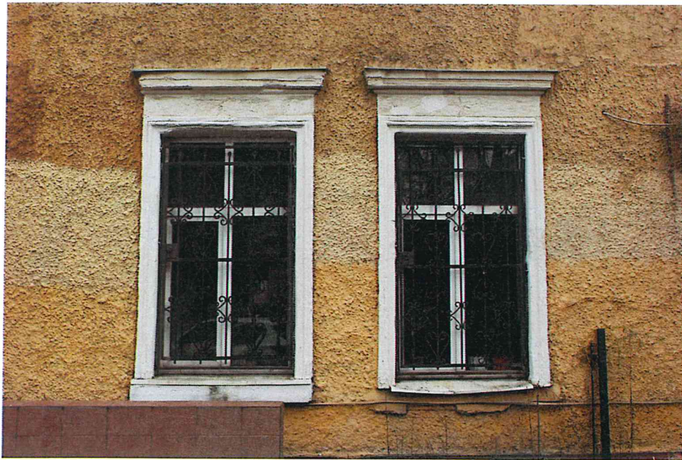
Рисунок 62. Южный фасад объекта. Фрагмент.
