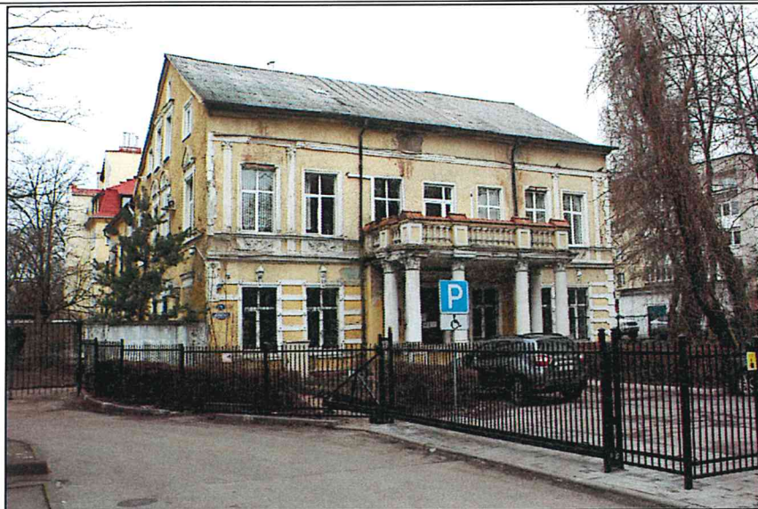
Рисунок 4. Восточный фасад объекта.
