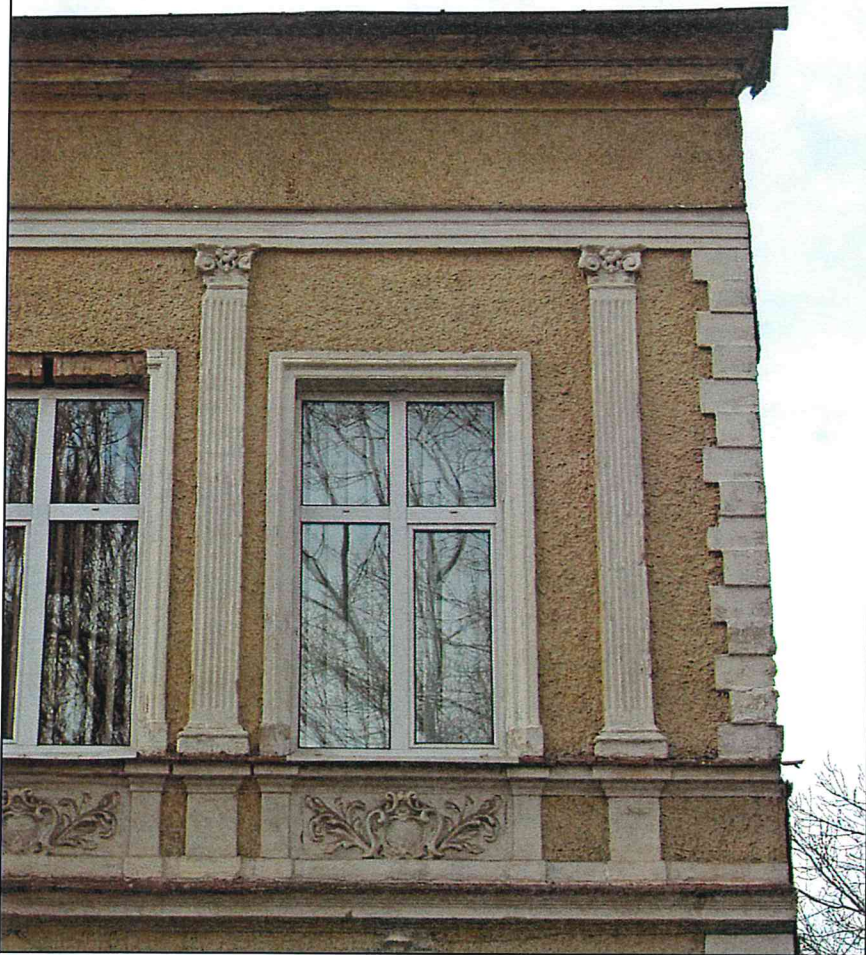
Рисунок 23. Восточный фасад объекта. Фрагмент.
