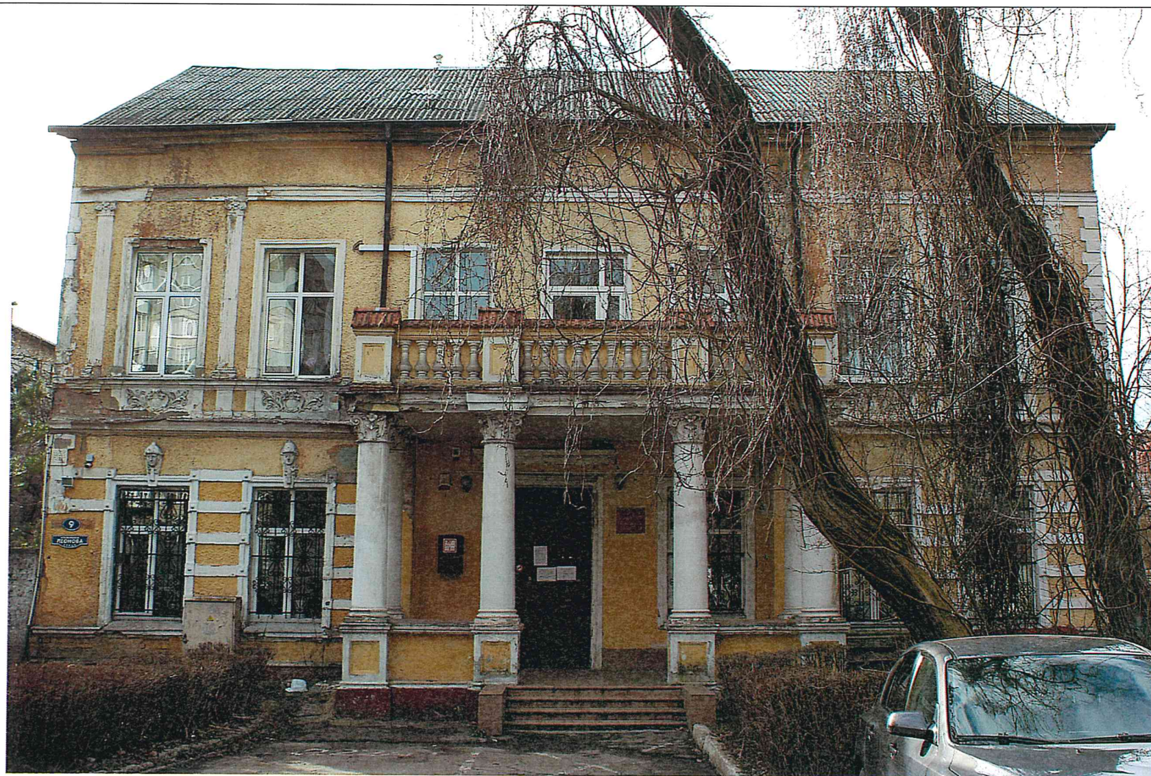
Рисунок 12. Восточный фасад объекта.
