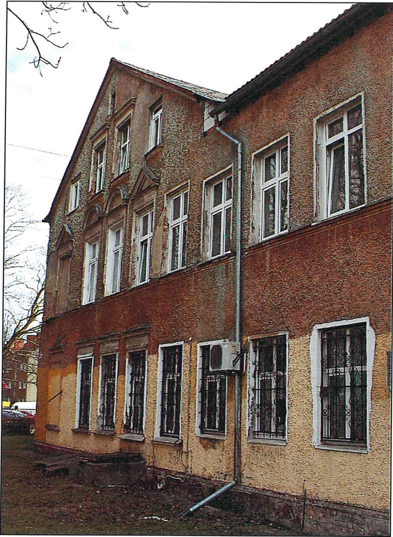
Рисунок 37. Северный фасад объекта. Фрагмент.
