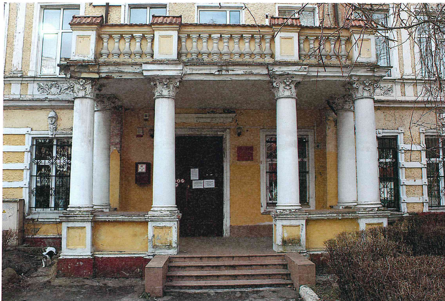
Рисунок 14. Восточный фасад объекта. Фрагмент.
