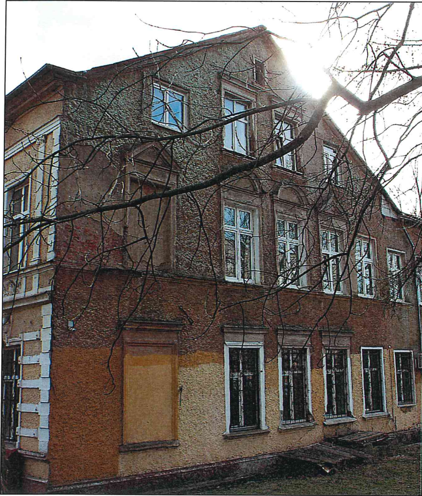
Рисунок 34. Северный фасад объекта. Фрагмент.
