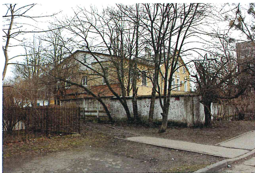
Рисунок 10. Западный фасад объекта. Южный фасад объекта.
