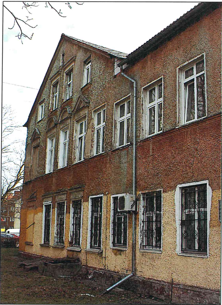
Рисунок 43. Северный фасад объекта. Фрагмент.
