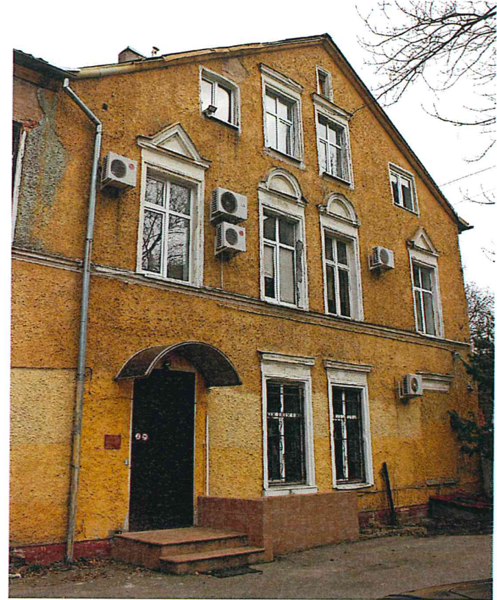
Рисунок 57. Южный фасад объекта. Фрагмент.
