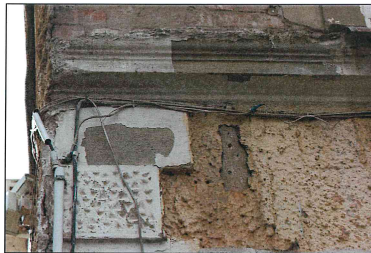
Рисунок 17. Восточный фасад объекта. Фрагмент.
