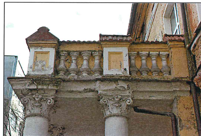
Рисунок 31. Северный фасад объекта. Фрагмент.
