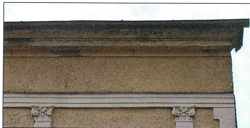
Рисунок 24. Восточный фасад объекта. Фрагмент.
