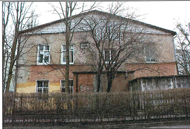
Рисунок 9. Западный фасад объекта.
