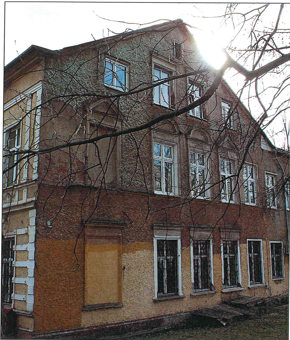
Рисунок 40. Северный фасад объекта. Фрагмент.
