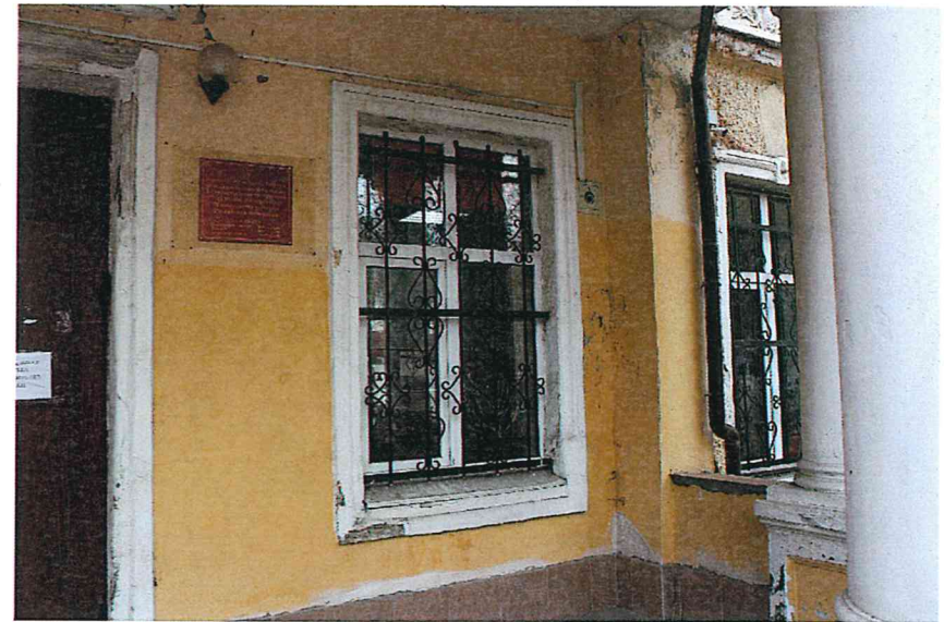
Рисунок 21. Восточный фасад объекта. Фрагмент.
