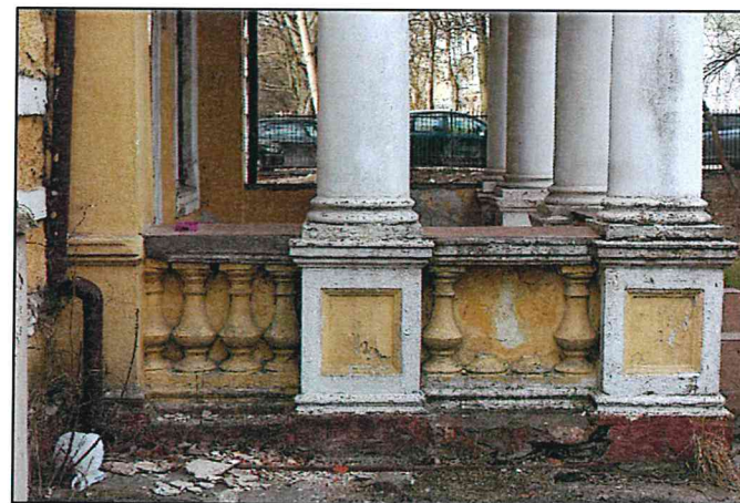
Рисунок 67. Южный фасад объекта. Фрагмент.
