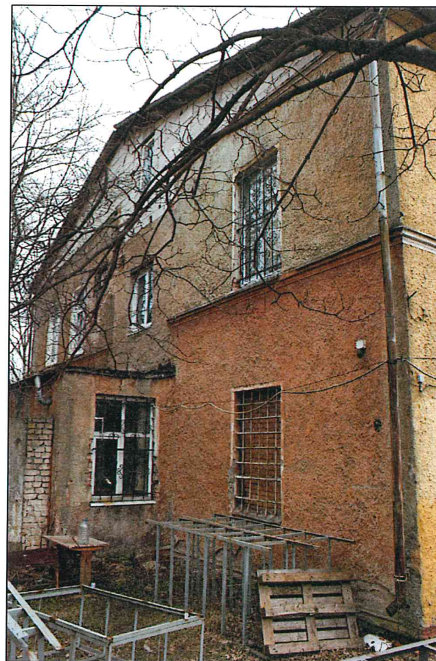
Рисунок 53. Западный фасад объекта. Фрагмент.
