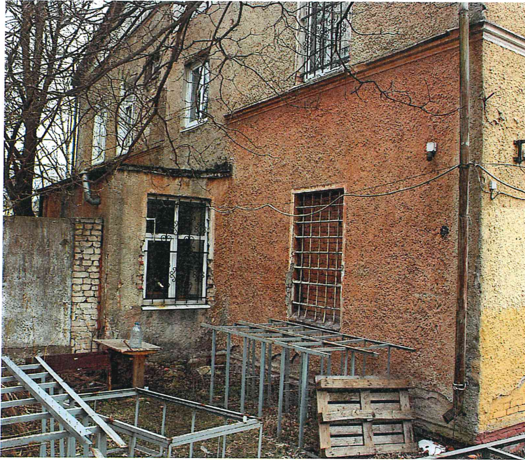
Рисунок 59. Южный фасад объекта. Фрагмент.
