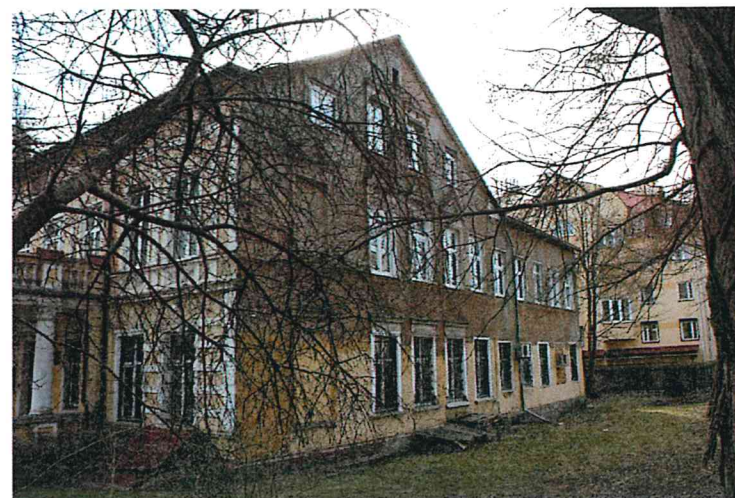
Рисунок 7. Северный фасад объекта.
