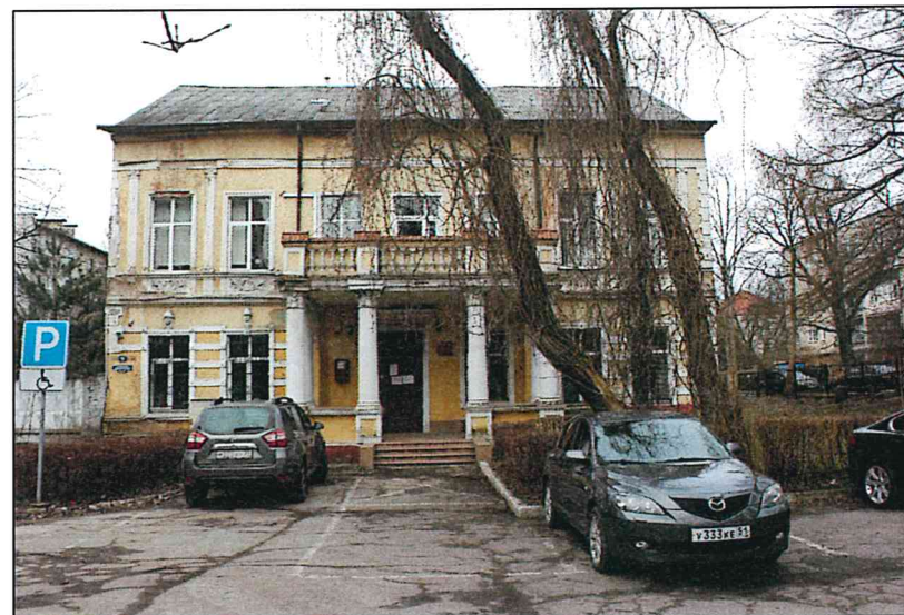
Рисунок 5. Восточный фасад объекта.
