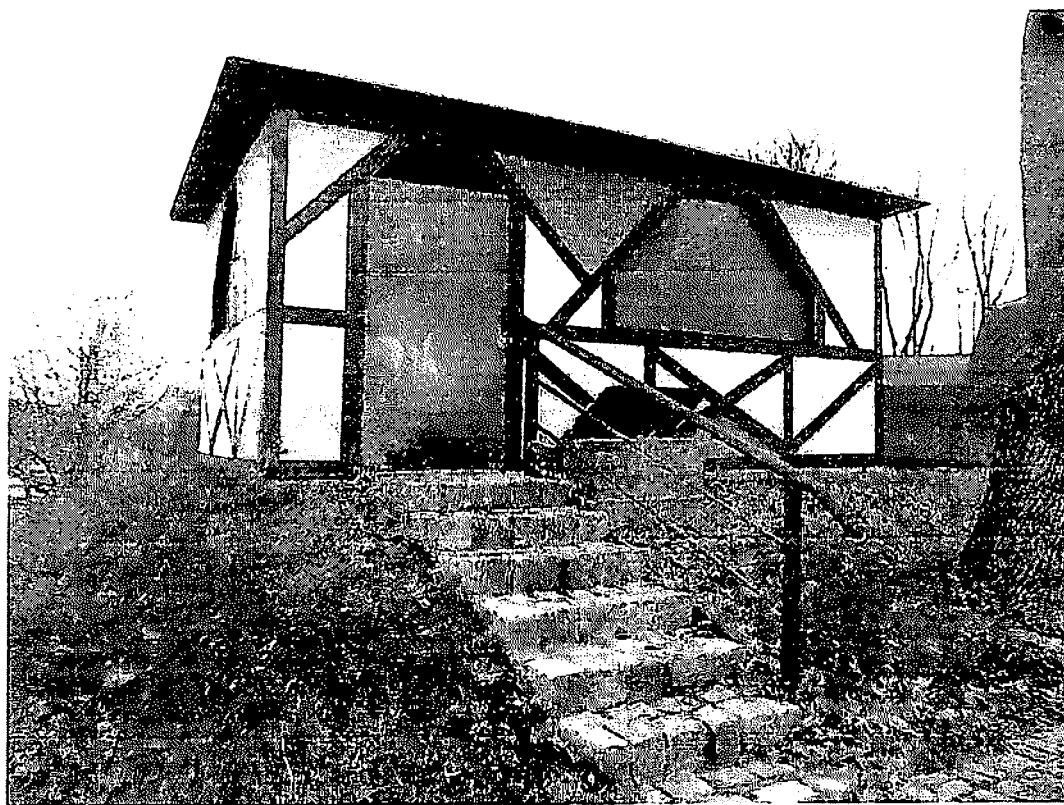
Вид с востока: земляная насыпь по бетонной подушке, в настоящее время над казематированным траверсом построена беседка, к которой ведёт каменная лестница.
