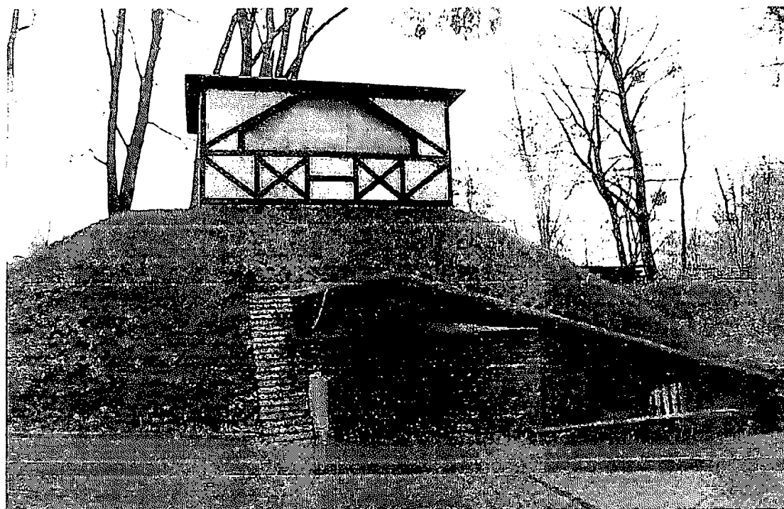
Вид с запада: стена траверса со входом и подпорная стенка частично закрыты тамбуром поздней постройки.
