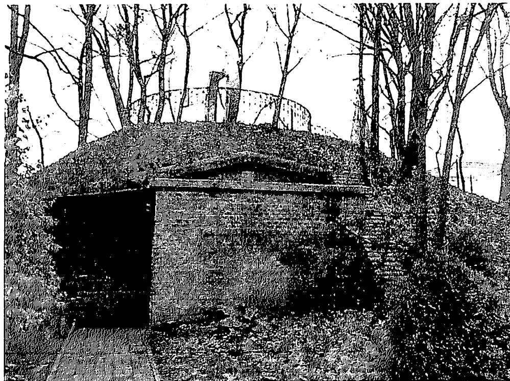
Вид с юго-запада:
