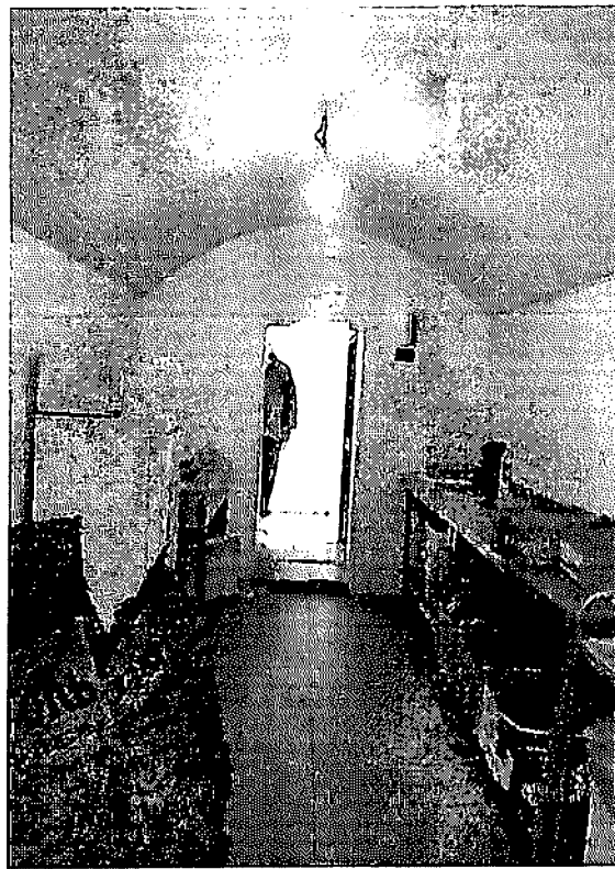
Интерьеры траверса: стены и своды обшиты панелями ПВХ, полы с современным плиточным покрытием. фото № 6
