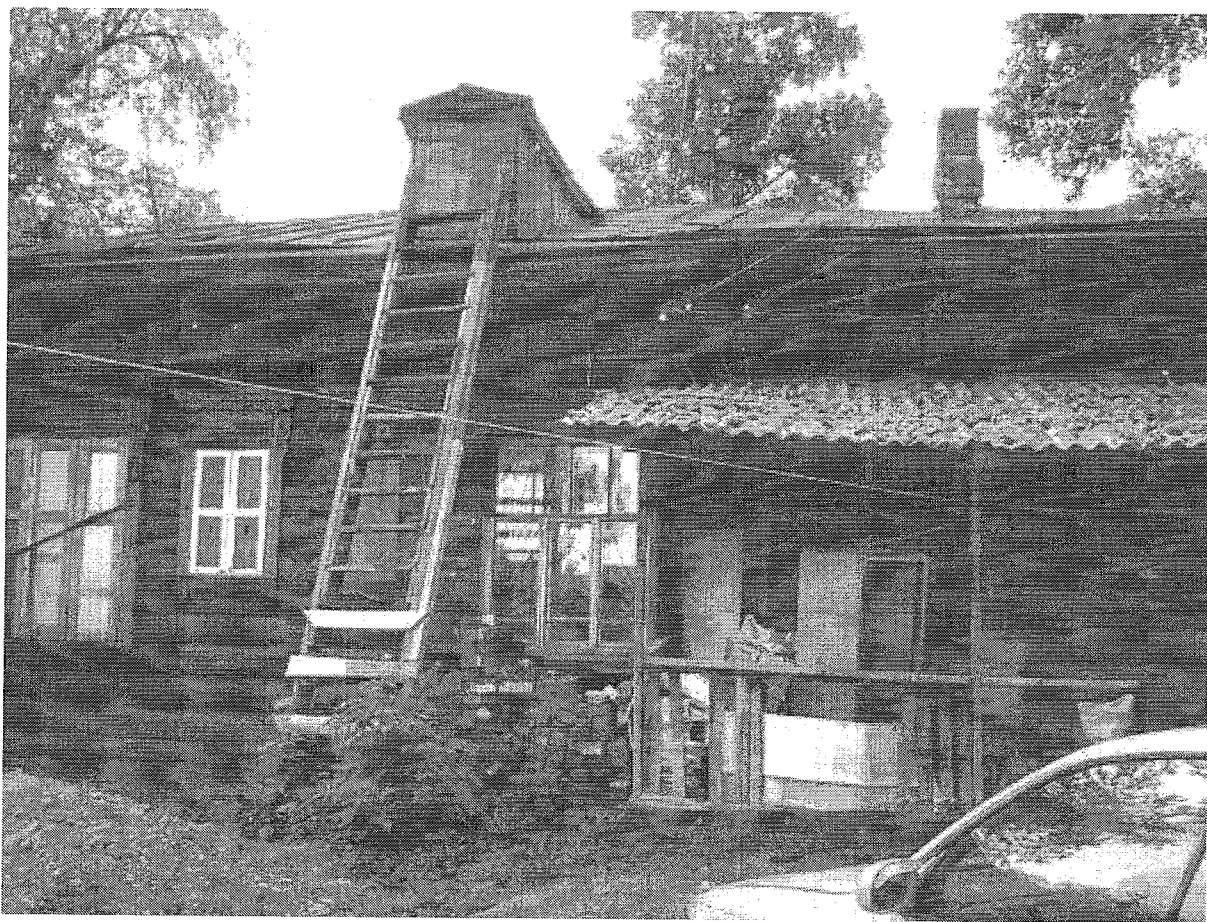
Фрагмент северо-западного фасада, центральная часть, 2005 г.
