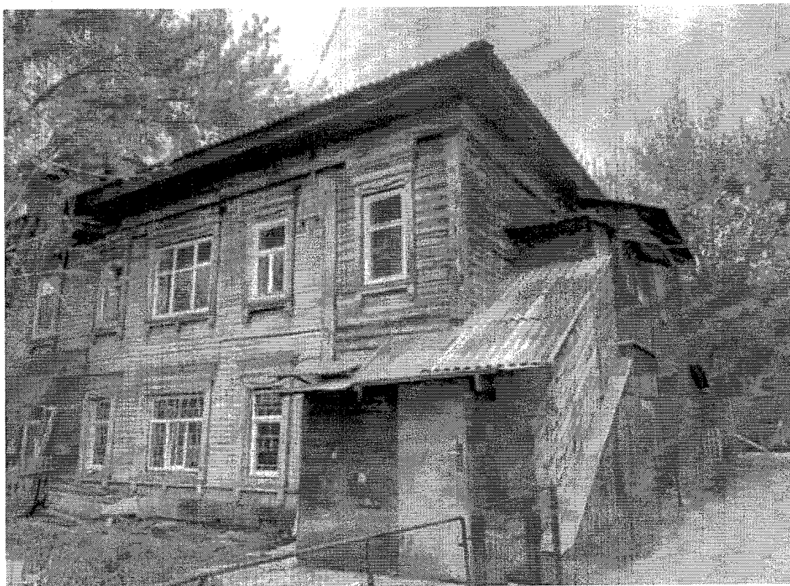
Северо-восточный и северо-западный фасады Объекта
