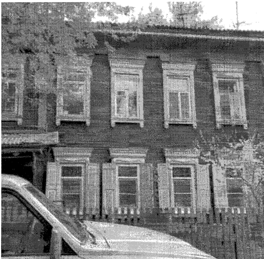
Фрагмент юго-западного фасада Объекта
