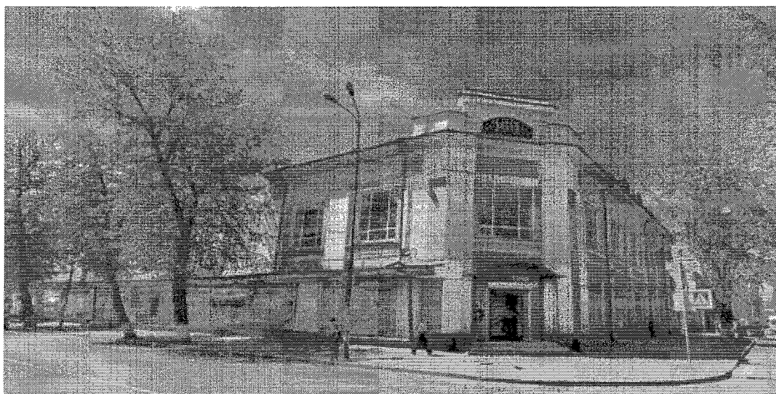
Вид Объекта с перекрёстка ул. Фурье и ул. Дзержинского, угловой фасад
