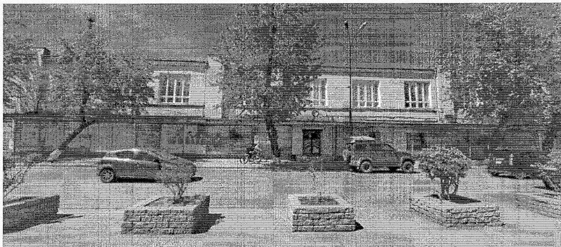
Фасад Объекта по ул. Дзержинского
