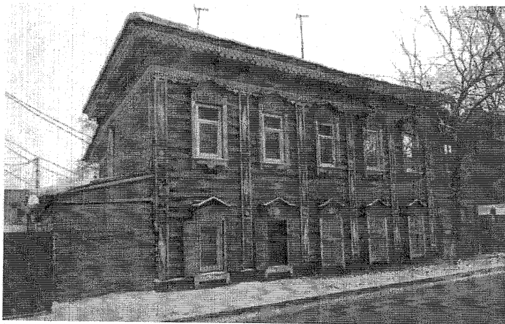
Фото 1. Общий вид здания с западного угла.
