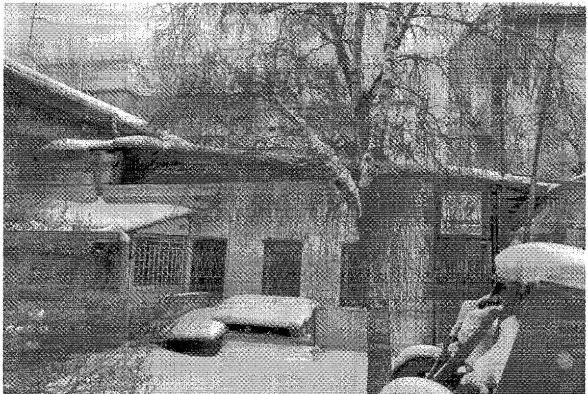
Фото 10. Вид на здание со стороны юга. / Декабрь, 2022 г.
