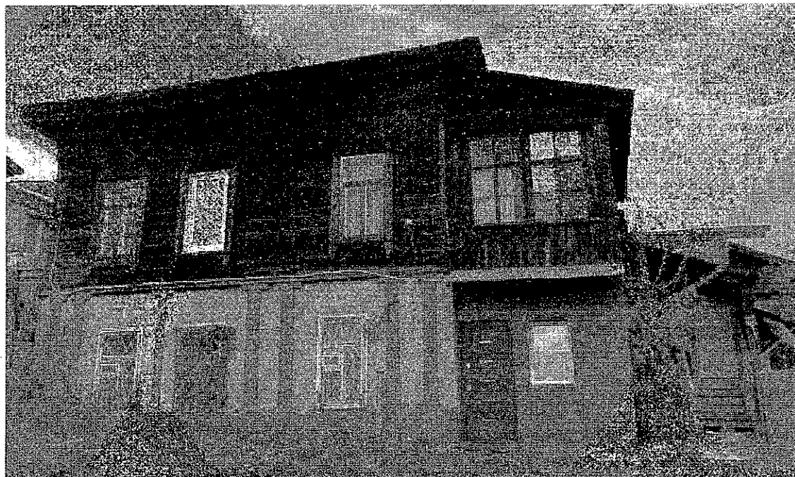
Боковой юго-западный фасад дома
