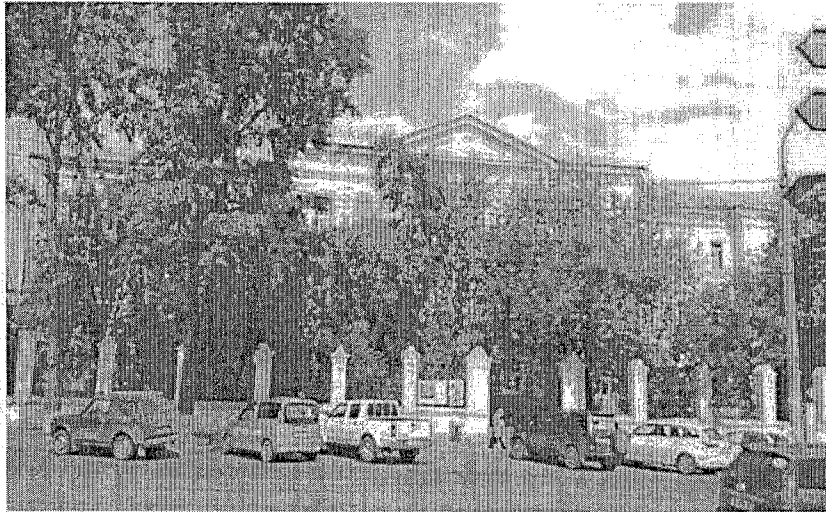
Фото 1. Главный юго-восточный фасад по улице Тимирязева.
