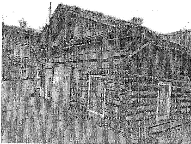
Фото 15. Северо-восточный фасад дома под лит. б.
