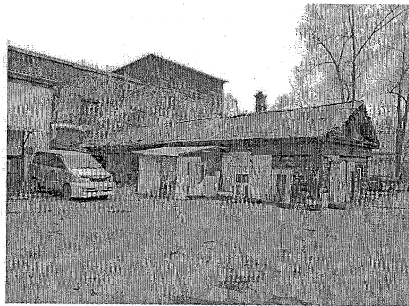
Фото 17. Юго-восточный фасад дома под лит. б.
