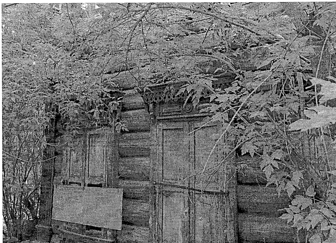
Фото 9, 10 – Фрагменты юго-восточного фасада
