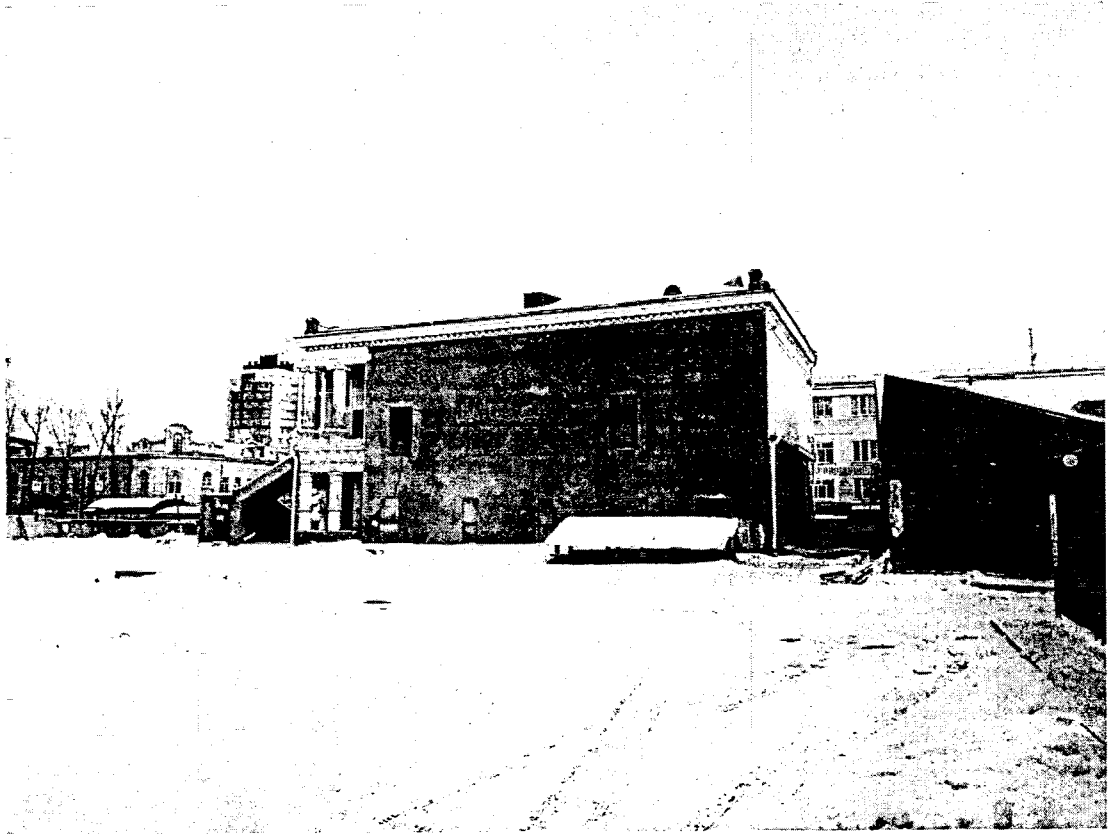
Фото 13. Общий вид здания с северо-запада. Фото 2003 г.
