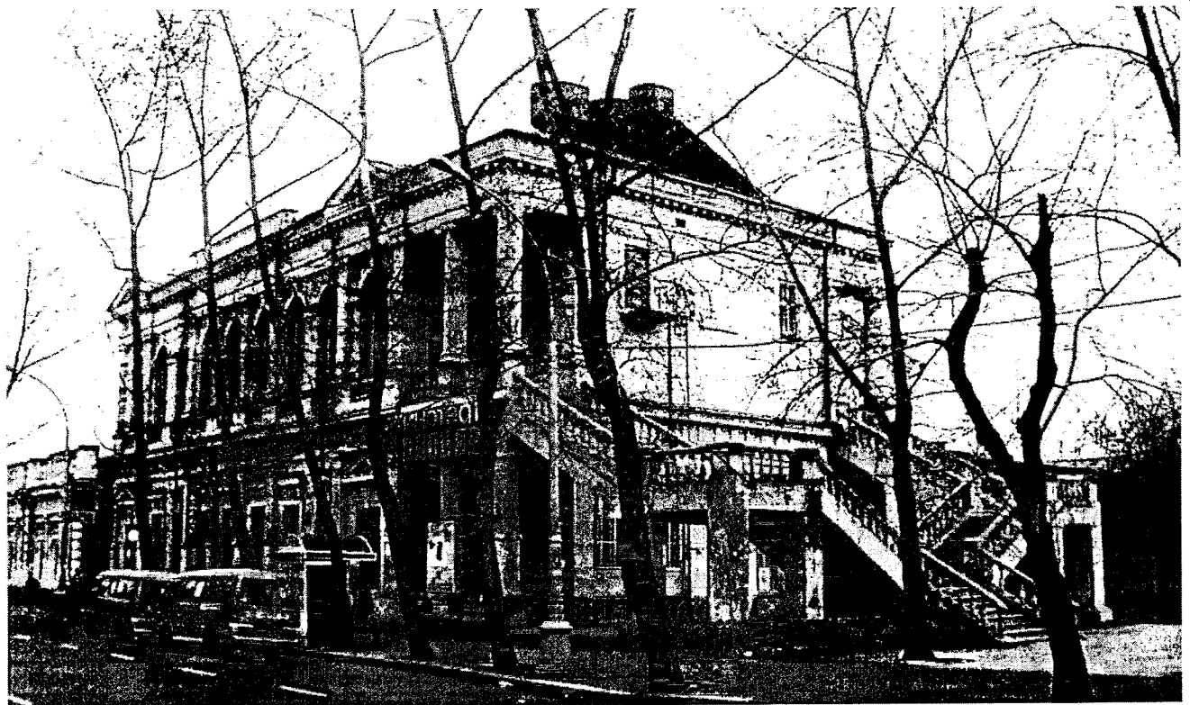
Фото 6. Общий вид здания с востока. Фото 2003 г.
